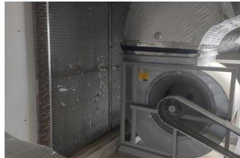
Figura 39 - Ventilador de insuflamento da casa de máquinas
