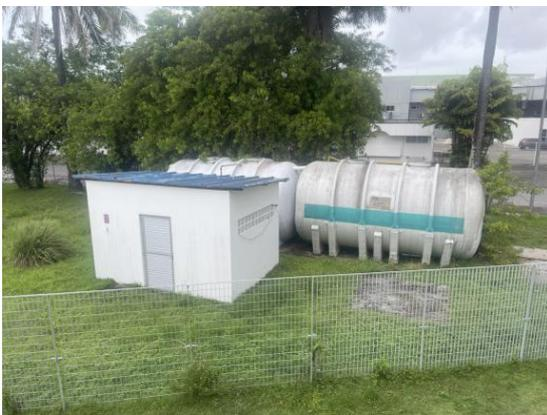
Figura 11 - Estação de tratamento de esgoto (ETE)
