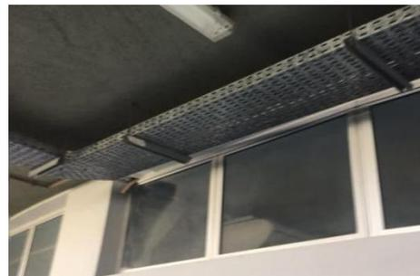
Figura 51 - Eletrocalhas e janelas para as salas no térreo
