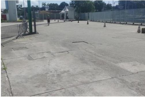
Figura 136 – Piso do ESTACIONAMENTO DE SERVIÇO necessitando de reparos
