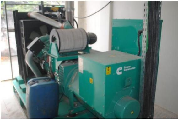
Figura 10 - Subestação - Grupo Motor gerador
