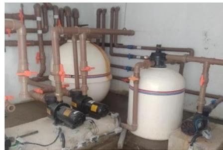
Figura 125 - Bombas, filtros e instalações na área da PISCINA
