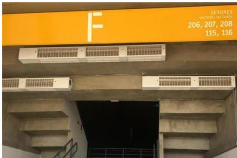
Figura 101 - Cortinas de ar do pavimento intermediário
