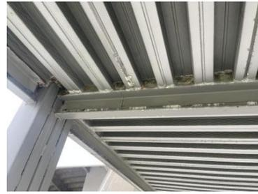
Figura 27 - Corrosão na cobertura das rampas de acesso
