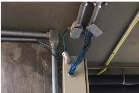
Figura 50 - Instalações de dados aparentes no corredor térreo
