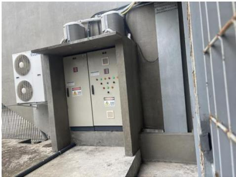
Figura 32 - Quadro de comando de um dos *chillers*
