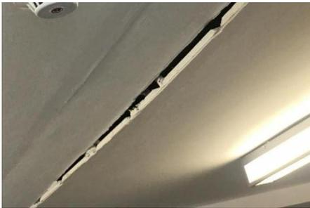
Figura 38 - Detalhe do selamento do forro da Sala do Acervo pela vibração da casa de máquinas logo acima
