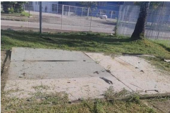
Figura 12 - Poço de recebimento da ETE, devidamente coberto com alçapão
