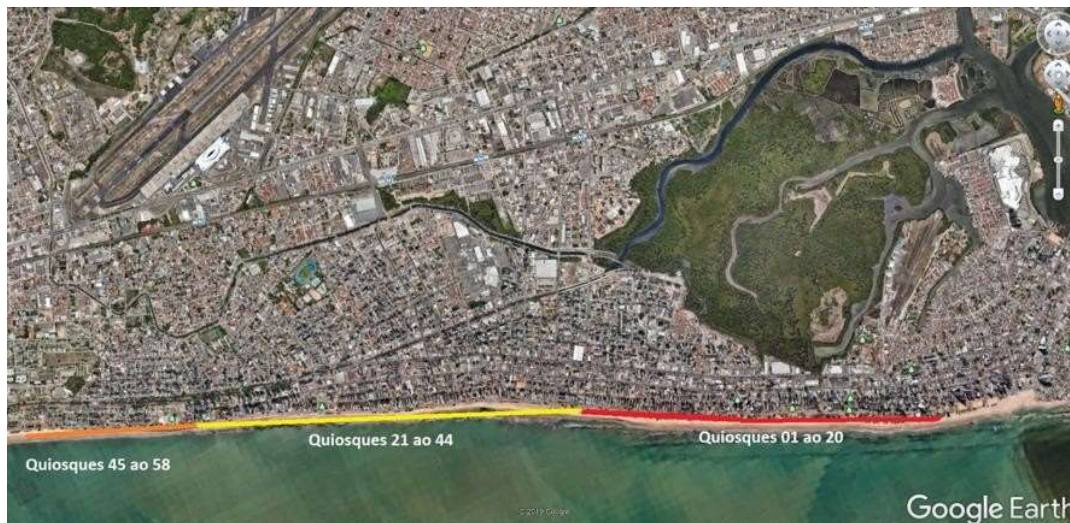
Figura 34. Identificação da situação de abastecimento de água nos quiosques da Orla do Recife. Laranja – abastecimento deficitário; Amarelo – abastecimento regular; Vermelho – Não existe rede de distribuição. Fonte: COMPESA.
