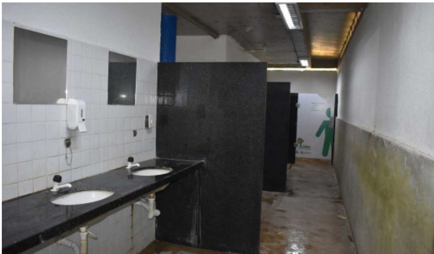
Figura 33 — Foto da edificação. Fonte: BNDES.
