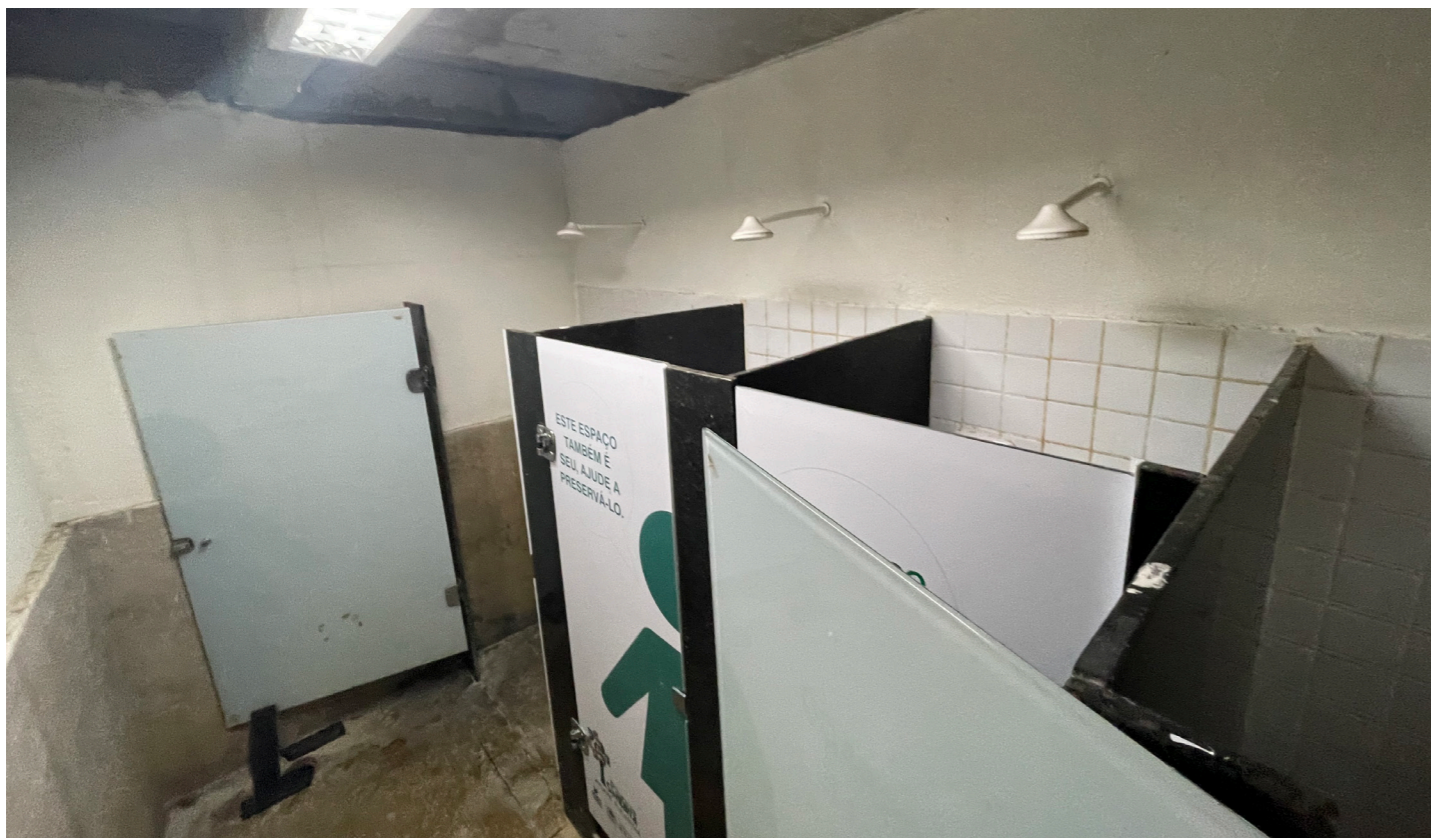
Figura 37 — Foto da edificação. Fonte: BNDES.
