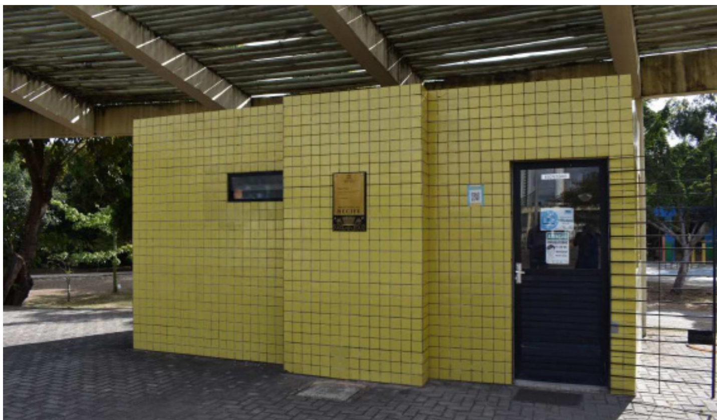
Figura 47 — Foto da edificação. Fonte: BNDES.
