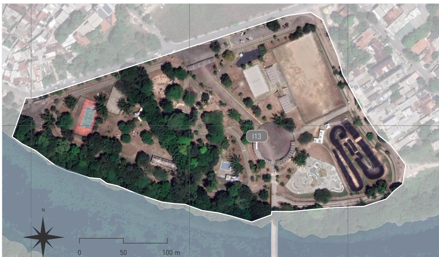
Figura 50 — Localização da edificação. Fonte: Mapa de confecção própria, a partir de informações colhidas em campo e fornecidas pelo BNDES.
