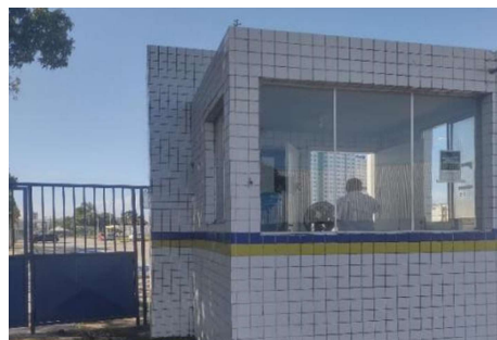
Figura 133 – Guarita de Acesso ao ESTACIONAMENTO GERAL
