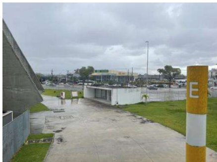
Figura 1 - Portão de Acesso E
