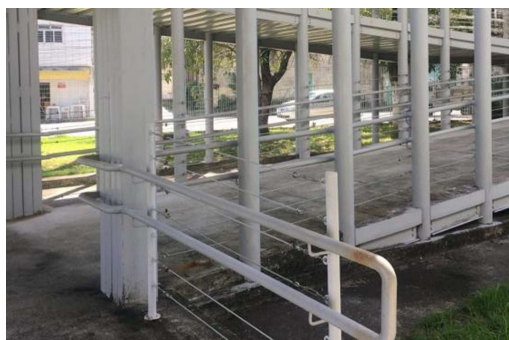
Figura 28 - Corrimão na subida da rampa de acesso
