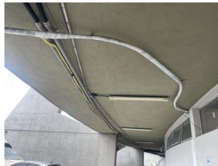
Figura 41 - Setor K - Instalações externas - Corredor externo
