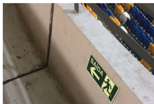
Figura 100 - Detalhe da sinalização de emergência - Piso Superior
