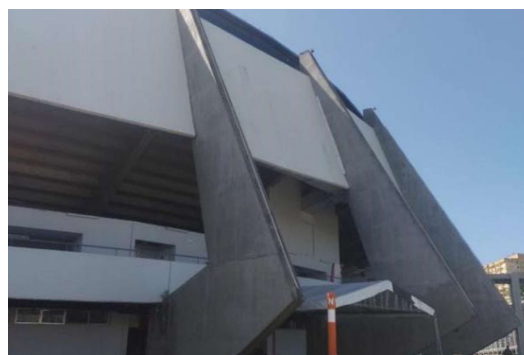
Figura 23 - Parte da fachada do GINÁSIO MULTIUSO
