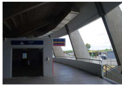
Figura 81 - Entrada de um dos auditórios no pavimento intermediário
