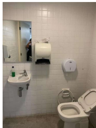
Figura 65 - Banheiro Camarote - Setor J
