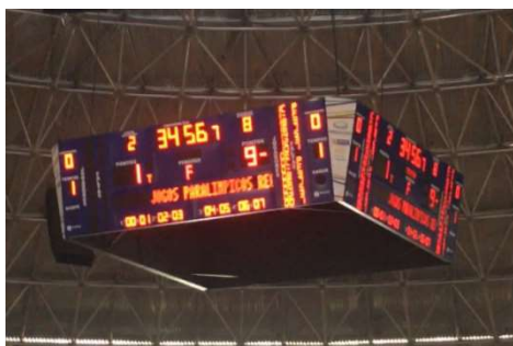
Figura 97 - Detalhe do placar - Quadra Principal
