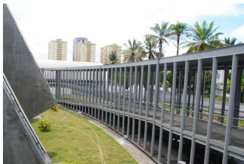
Figura 18 - Rampas de acesso
