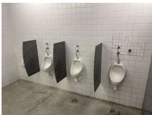
Figura 70 - Banheiro Masculino - Setor H
