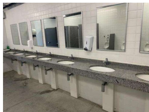
Figura 69 - Bancada com sete pias e espelho - Banheiro Masculino Setor H
