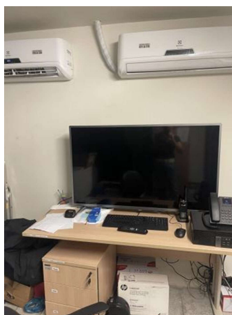
Figura 87 - Sala de rede rede/lógica
