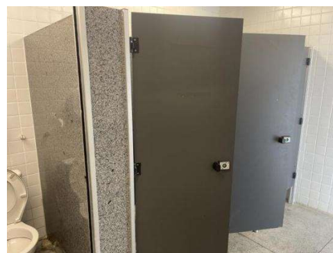
Figura 71 - Cabines com vaso sanitário - Banheiro Masculino - Setor H
