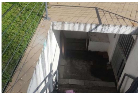
Figura 124 - Acesso à casa de bombas
