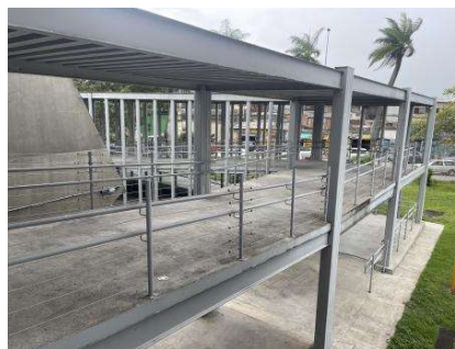
Figura 19 - Rampas de acesso
