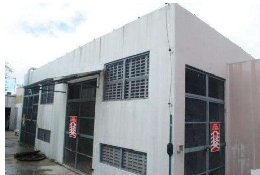
Figura 6 - Subestação e casa do gerador
