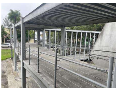
Figura 20 - Rampas de acesso
