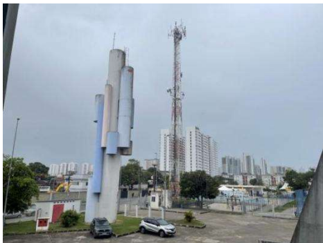
Figura 5 - Reservatório e torre de antena de telefonia
