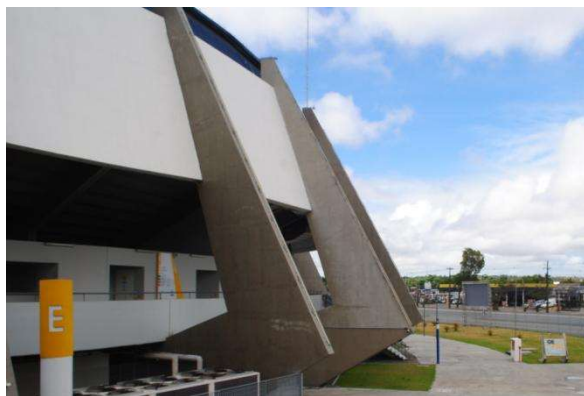
Figura 24 – Fachada, pilares e iluminação cênica do GINÁSIO MULTIUSO
