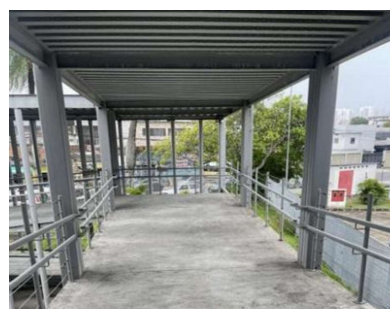
Figura 21 - Rampas de acesso
