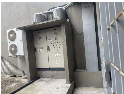
Figura 32 - Quadro de comando de um dos chillers
