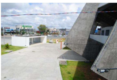
Figura 3 - Passeio e jardim Portão de Acesso N
