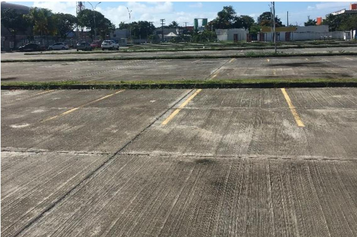
*Figura 109 – Piso com necessidade de ajustes para redução do empoçamento*
