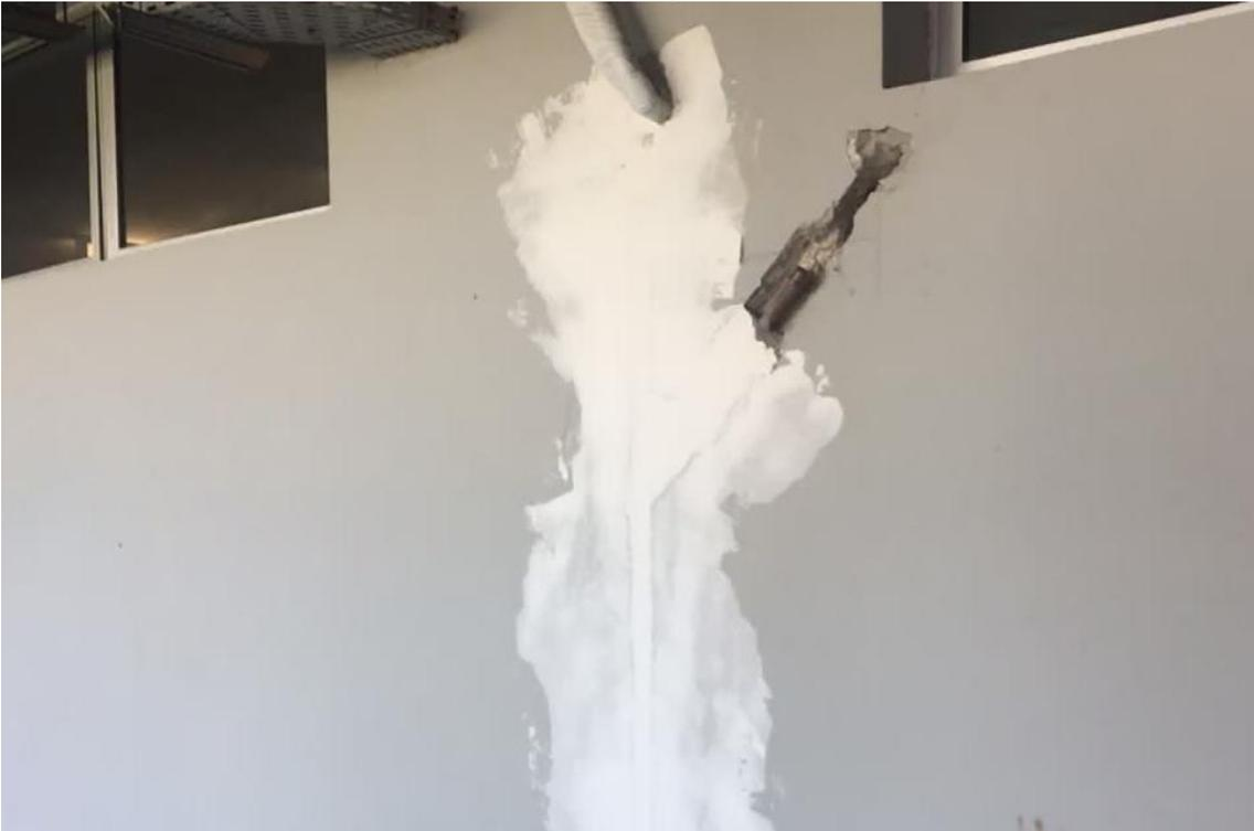
*Figura 33 - Instalações de dados aparentes no corredor térreo*
