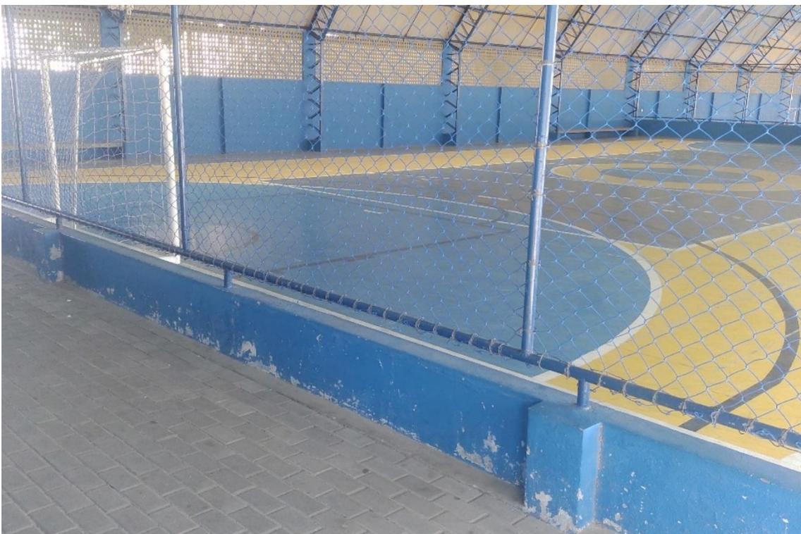
*Figura 87 – Portão do alambrado das QUADRAS POLIESPORTIVAS necessitando de retoque*
