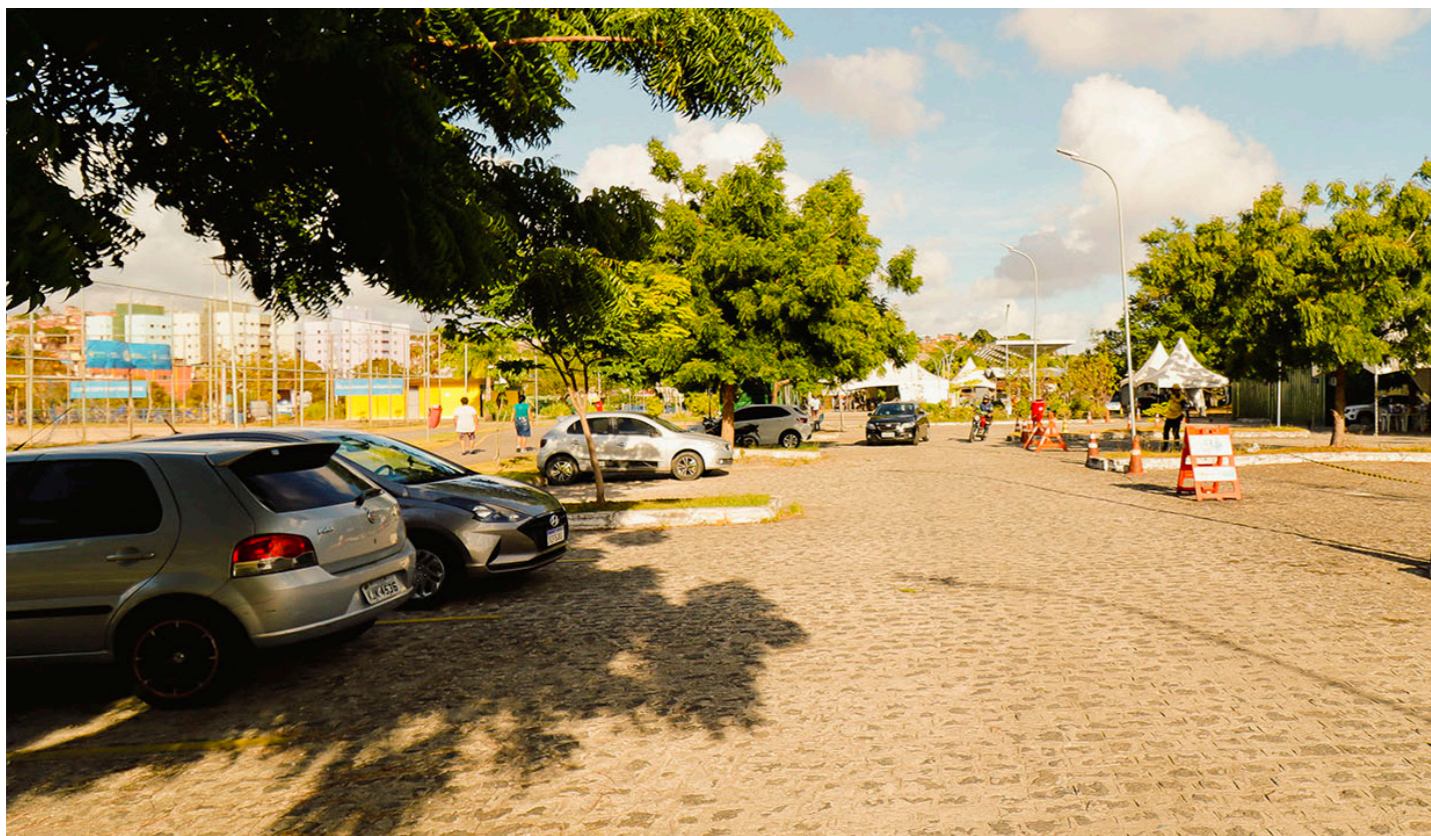
Figura 60 — Foto da estrutura. Fonte: BNDES.
