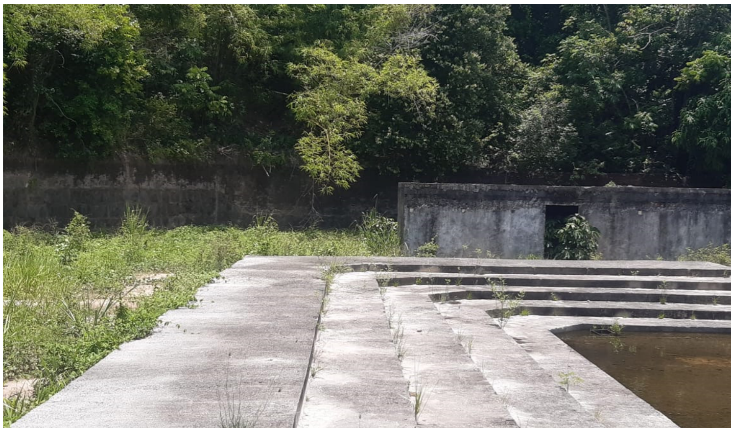
Figura 64 — Foto da edificação. Fonte: BNDES.
