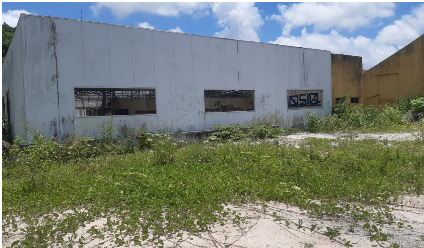
Figura 63 — Foto da edificação. Fonte: BNDES.
