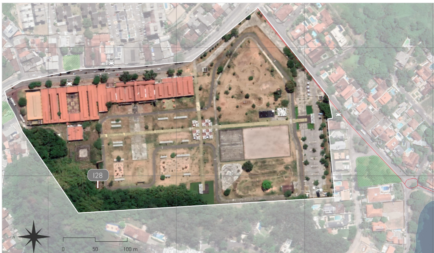
Figura 22 — Localização da edificação. Fonte: Mapa de confecção própria, a partir de informações colhidas em campo e fornecidas pelo BNDES.
