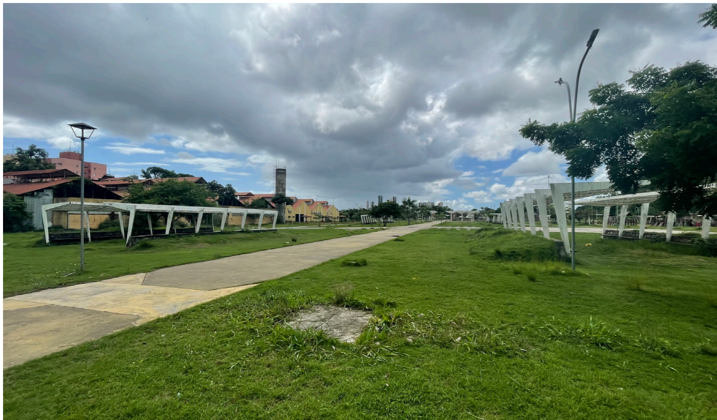
Figura 19 — Foto da estrutura. Fonte: BNDES. Fonte: visita técnica feita pela equipe em janeiro de 2022.
