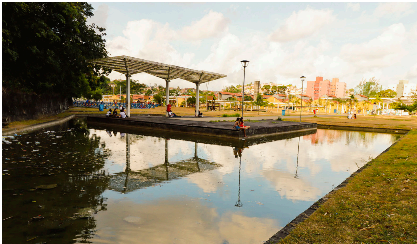
Figura 28 — Foto da estrutura. Fonte: BNDES.
