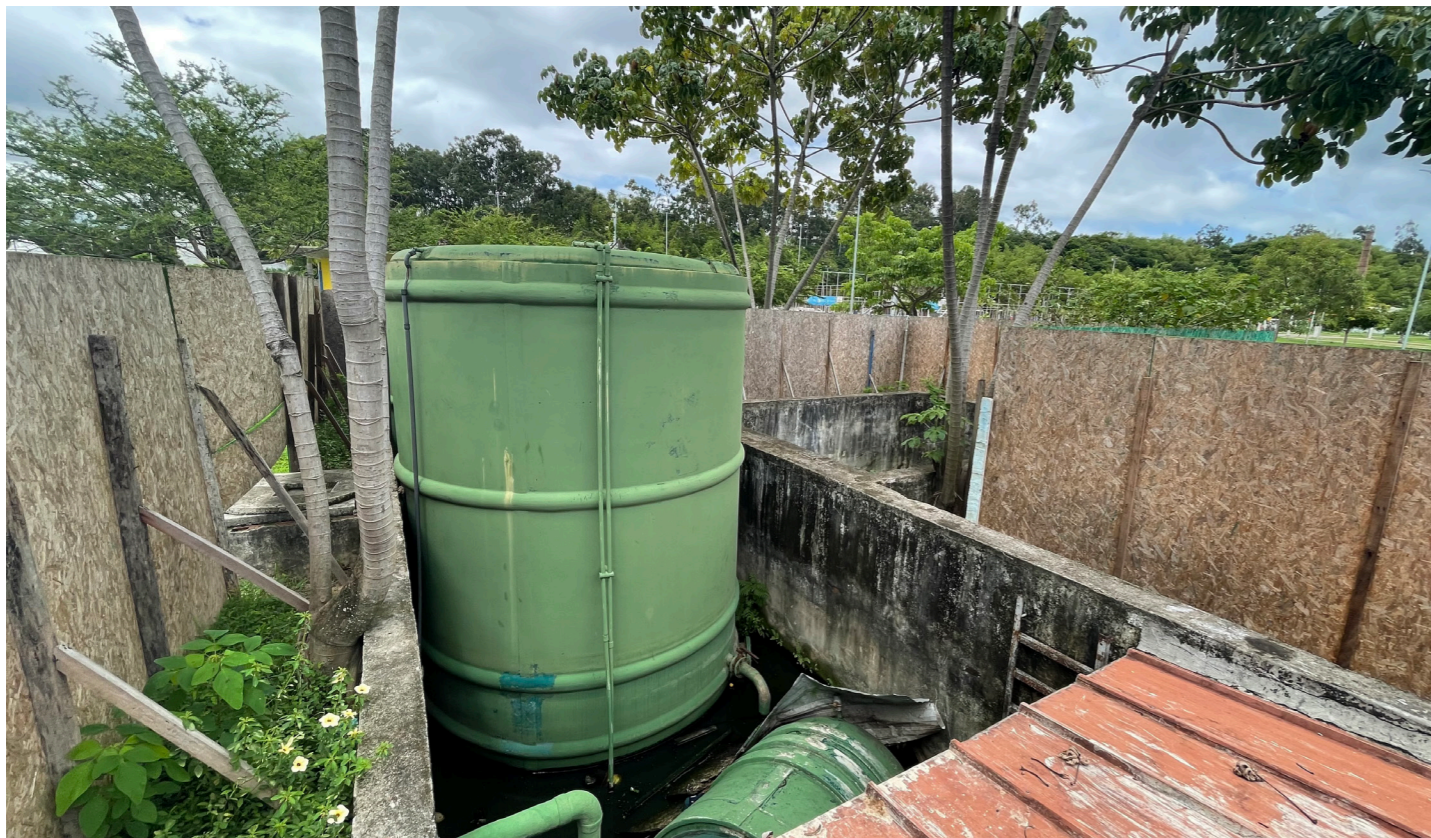
Figura 46 — Foto da estrutura. Fonte: BNDES. Fonte: visita técnica feita pela equipe em janeiro de 2022.
