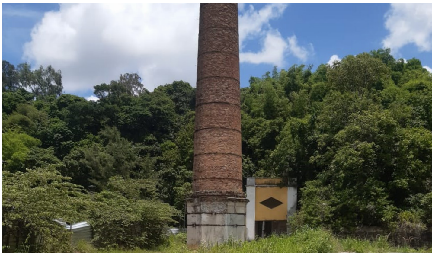
Figura 19 — Foto da estrutura. Fonte: BNDES. Fonte: visita técnica feita pela equipe em janeiro de 2022.
