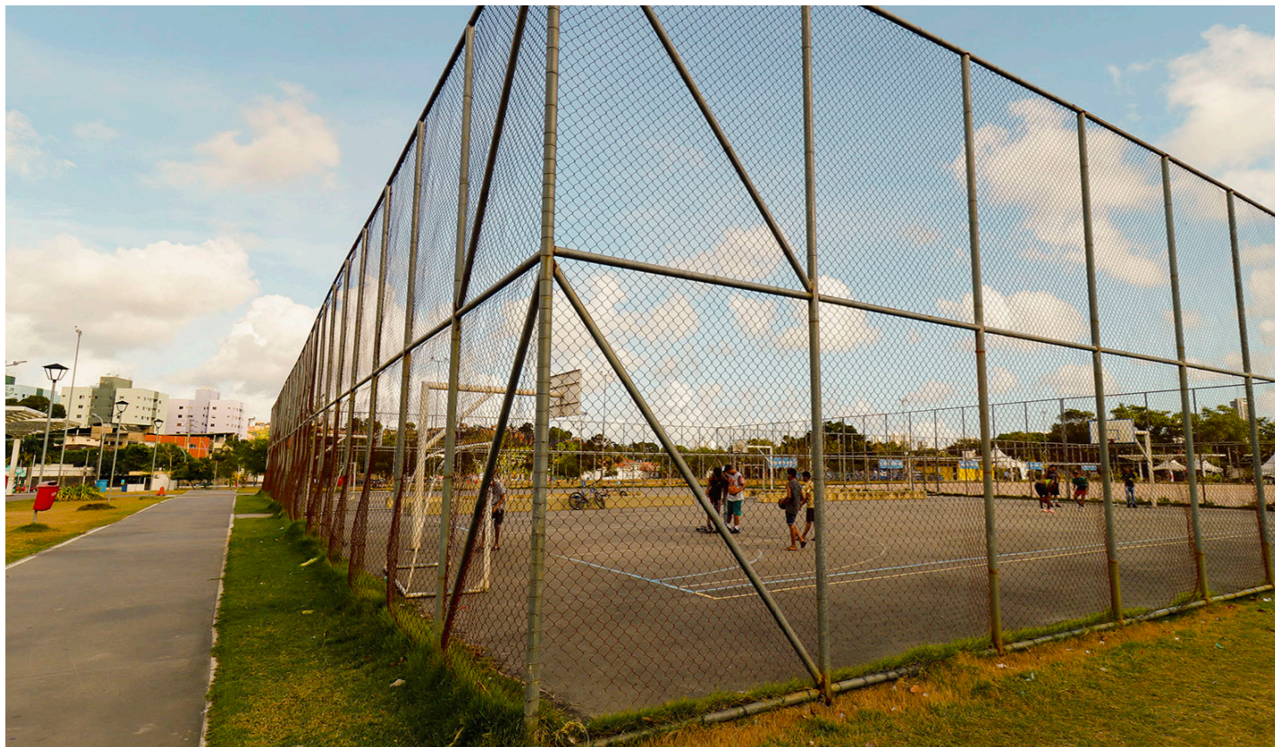
Figura 20 — Foto da estrutura. Fonte: BNDES.
