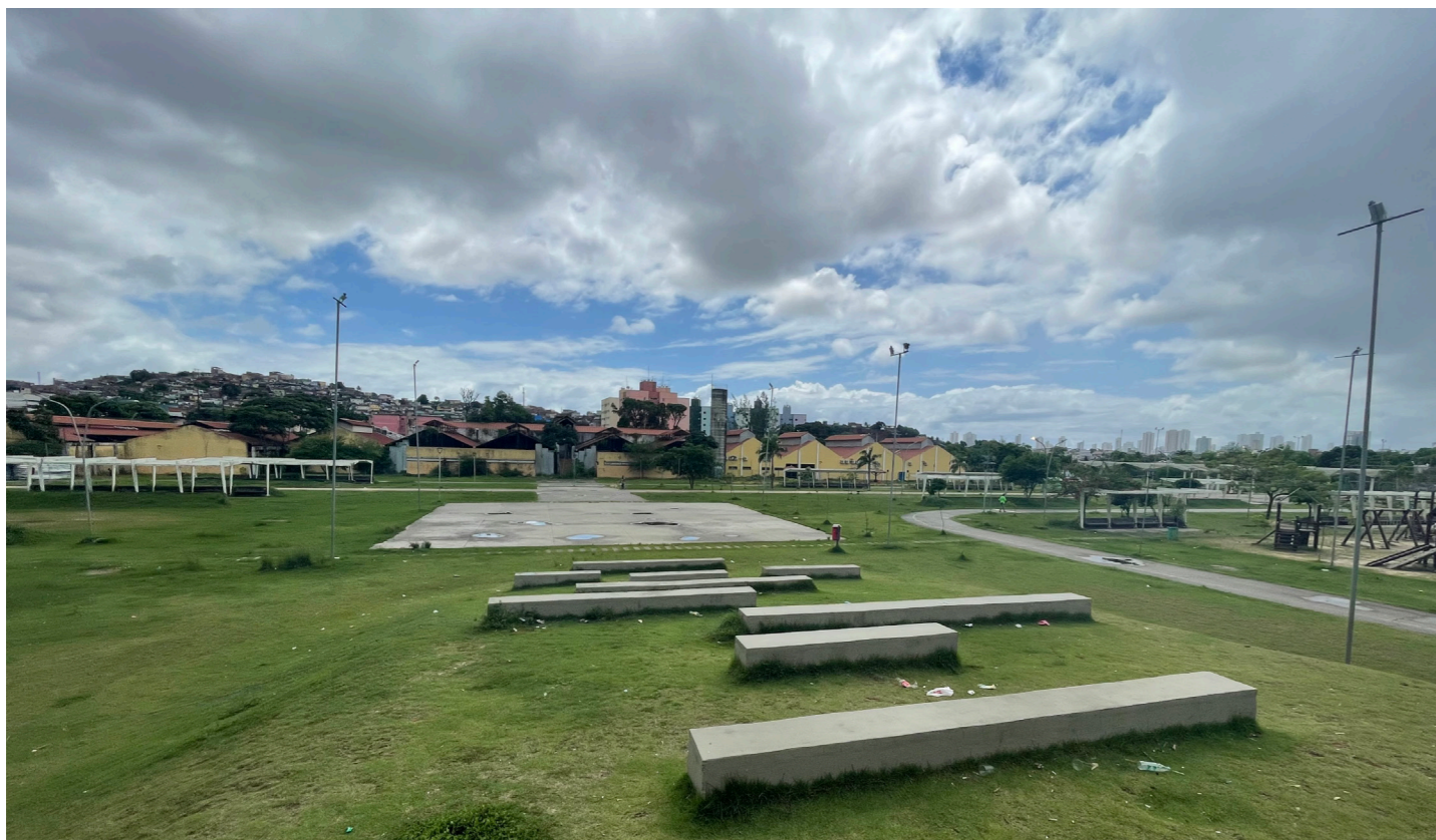
Figura 32 — Foto da estrutura. Fonte: visita técnica feita pela equipe em janeiro de 2022.
