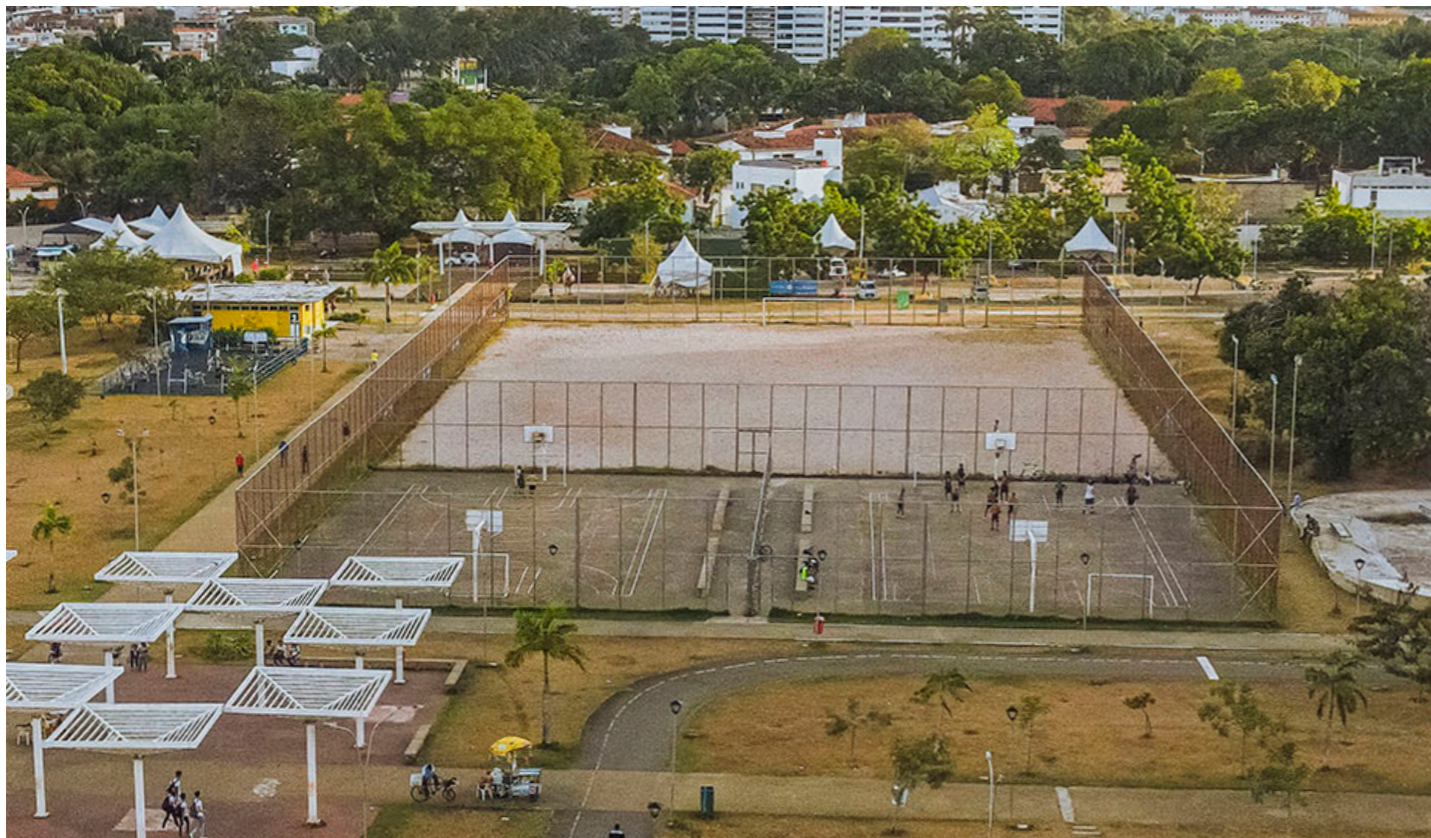
Figura 18 — Foto da estrutura. Fonte: BNDES.
