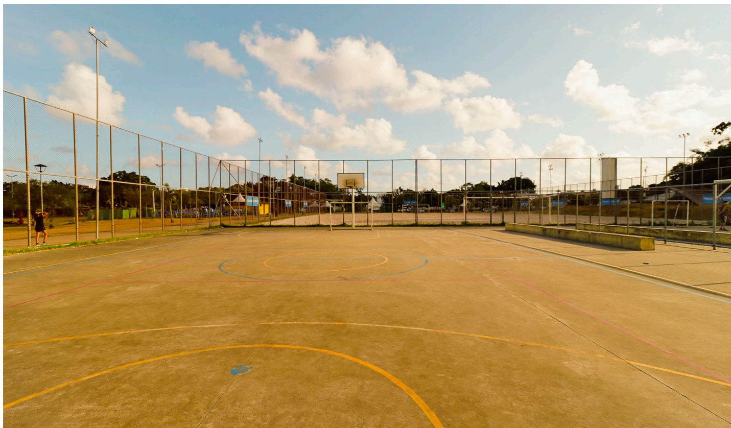
Figura 22 — Foto da estrutura. Fonte: BNDES.
