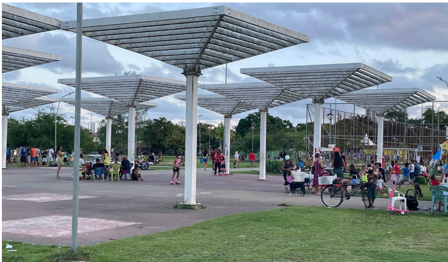
Figura 26 — Foto da estrutura. Fonte: visita técnica feita pela equipe em janeiro de 2022.
