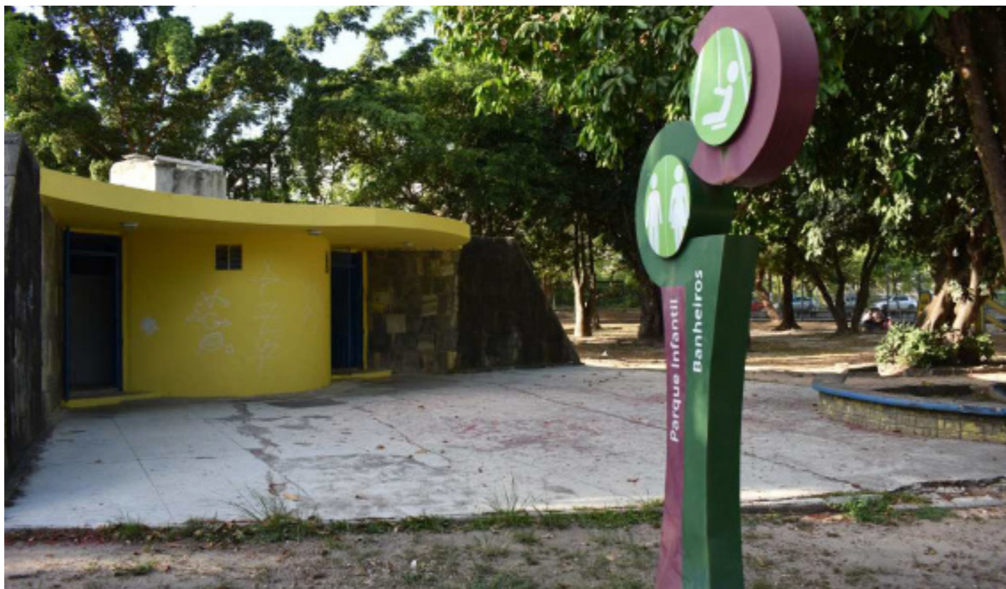
Figura 63 — Foto da edificação. Fonte: Google Street View.
