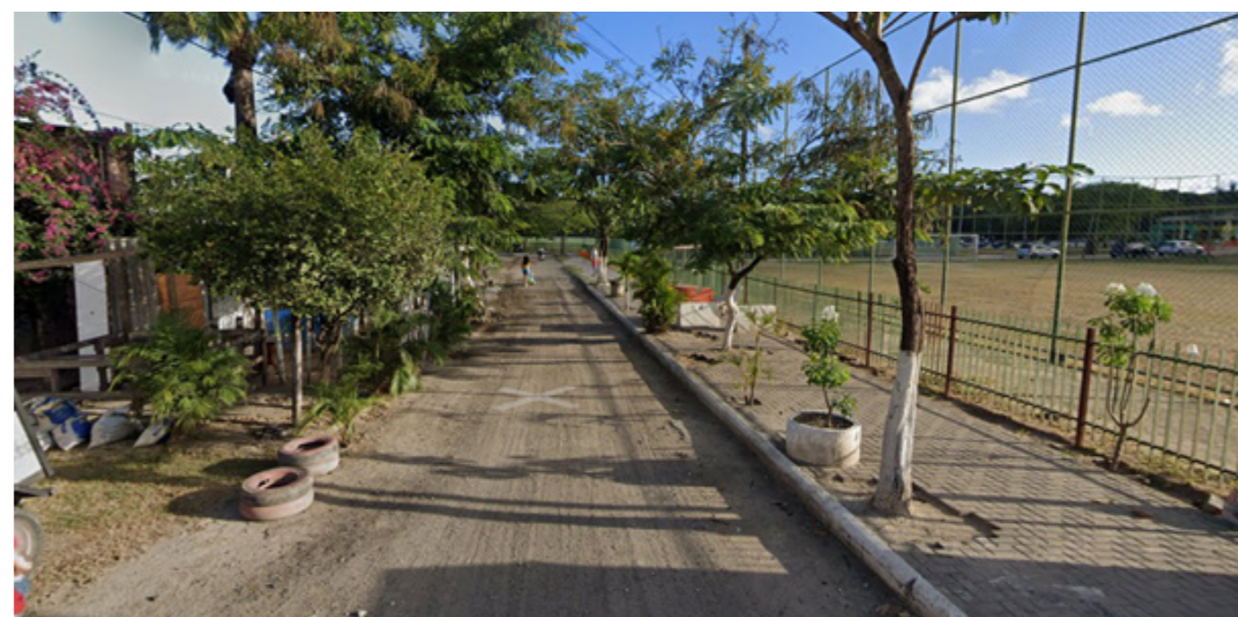
Figura 10 — Ocupação no leito carroçável, próximo ao portão oeste. Foto: Google Street View, 2021.
