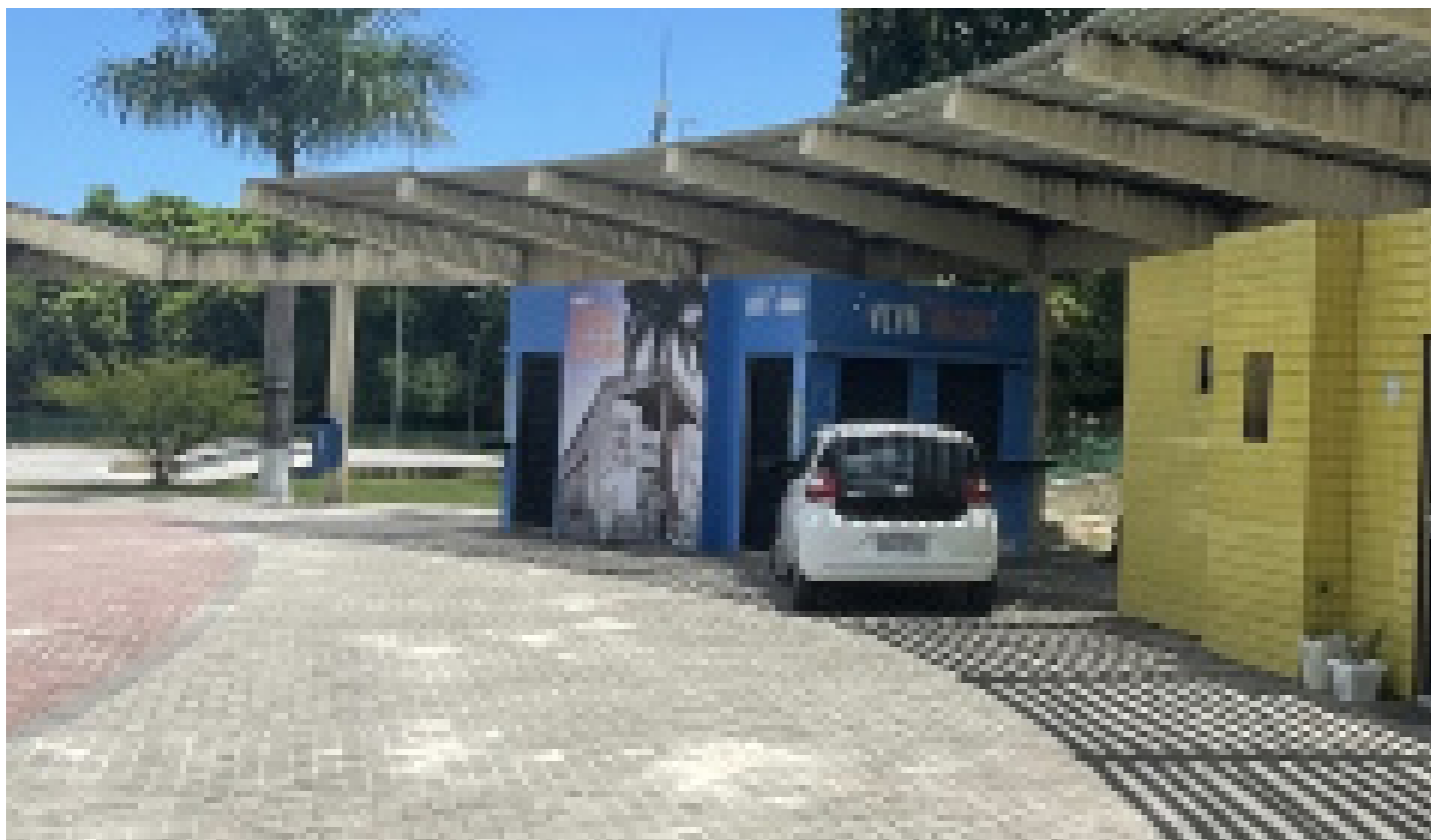
Figura 20 — Foto da edificação. Fonte: visita técnica feita pela equipe em janeiro de 2022.
