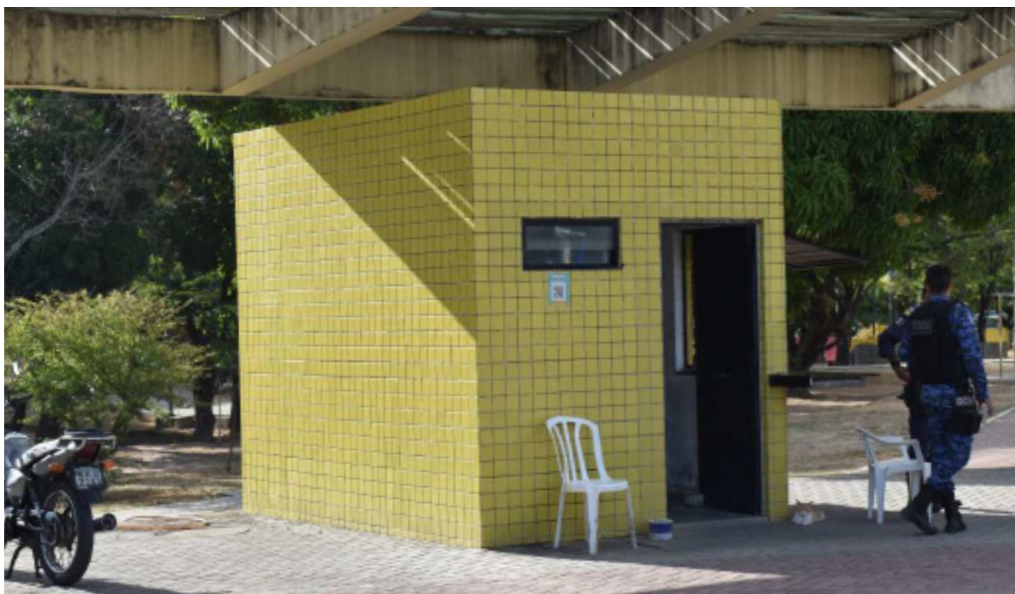
Figura 49 — Foto da edificação. Fonte: visita técnica feita pela equipe em janeiro de 2022.
