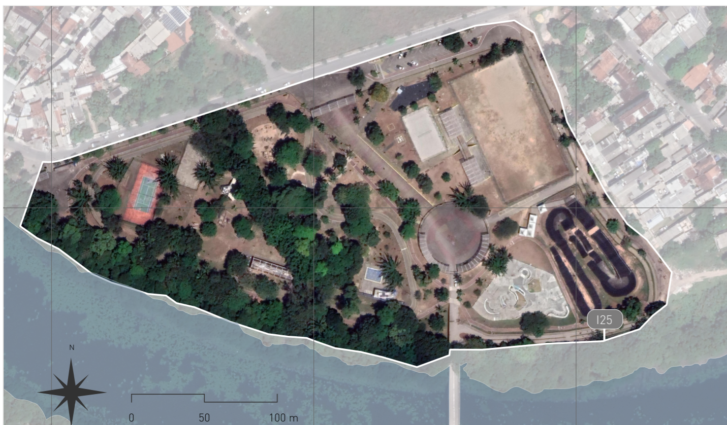
Figura 74 — Localização da edificação. Fonte: Mapa de confecção própria, a partir de informações colhidas em campo e fornecidas pelo BNDES.
