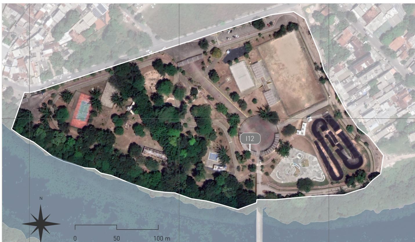
Figura 48 — Localização da edificação. Fonte: Mapa de confecção própria, a partir de informações colhidas em campo e fornecidas pelo BNDES.
