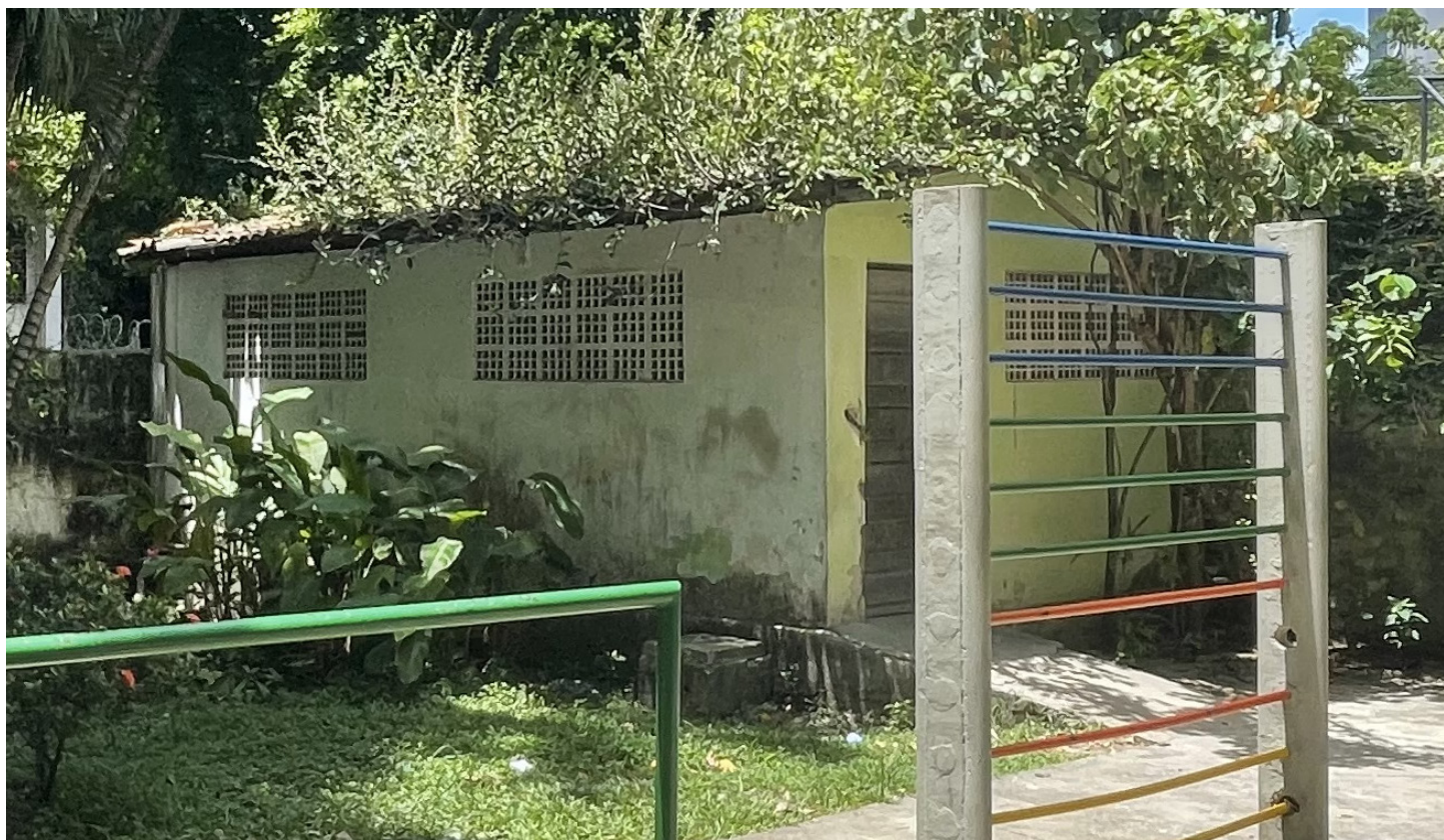
Figura 64 — Foto da edificação. Fonte: visita técnica feita pela equipe em janeiro de 2022.
