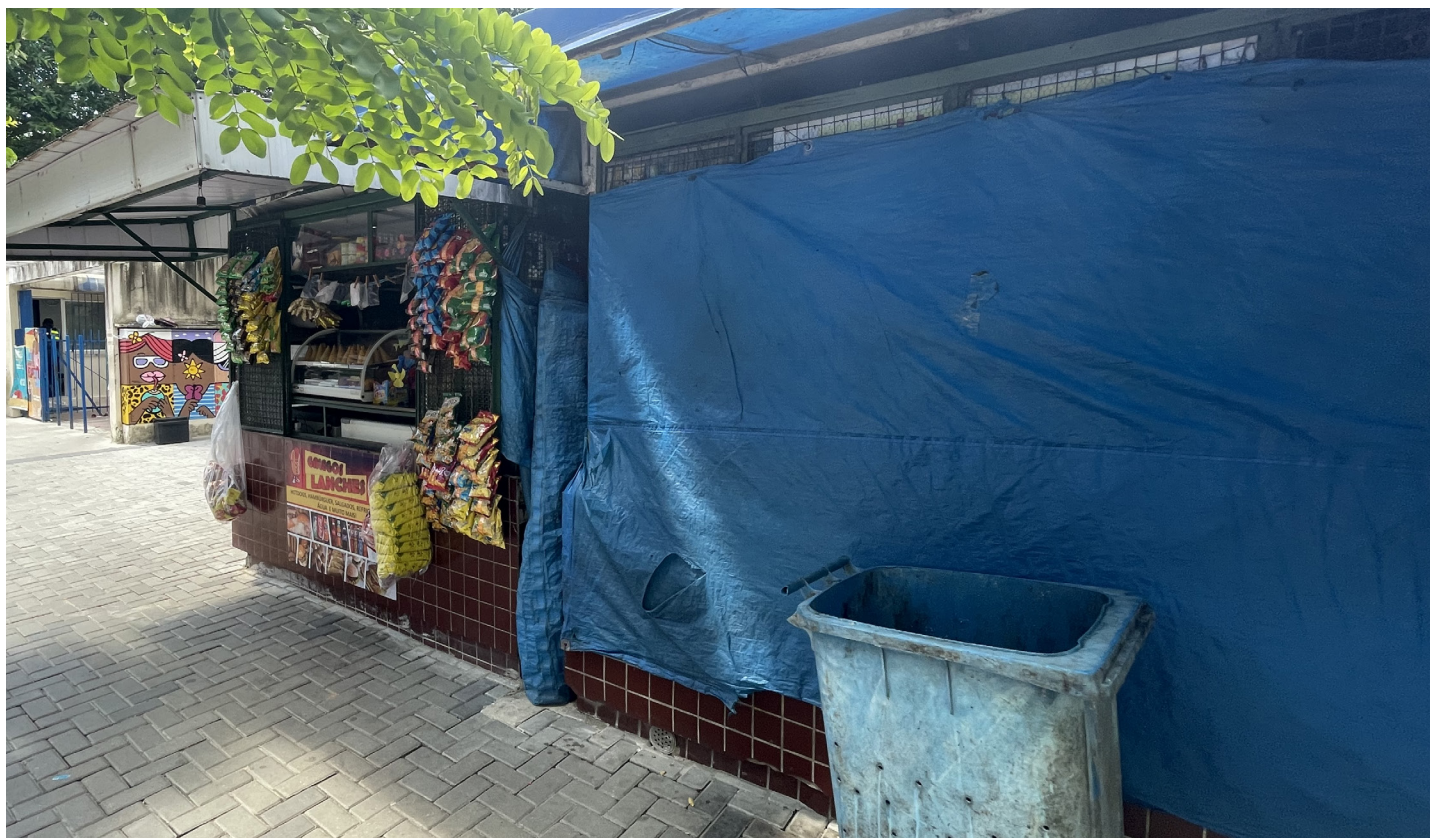
Figura 22 — Foto da estrutura. Fonte: visita técnica feita pela equipe em janeiro de 2022.
