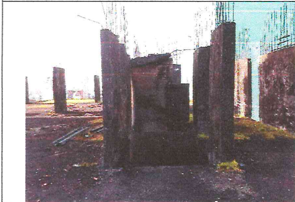
Fotos 25 e 26: Prolongamento de estruturas para construção de mais pavimentos-tipo da edificação
