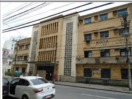
Rua Siqueira Campos, 2017. Fonte: DPPC. Destaca-se o acréscimo de um pavimento à direita, comprometendo a simetria volumétrica original da edificação.
