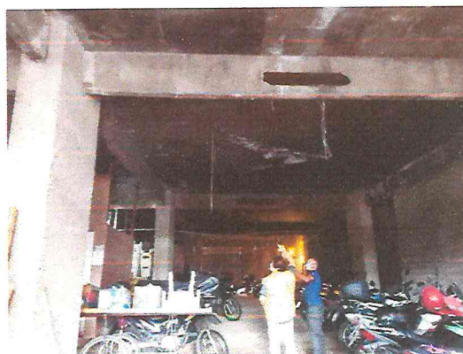
Foto 04: Vista do pavimento térreo
