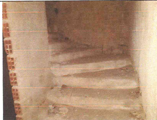
Foto 06: Escada de acesso aos pavimentos superiores
