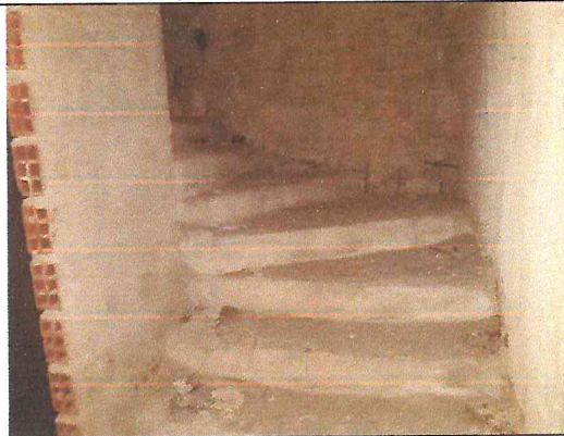
Foto 06: Escada de acesso aos pavimentos superiores
