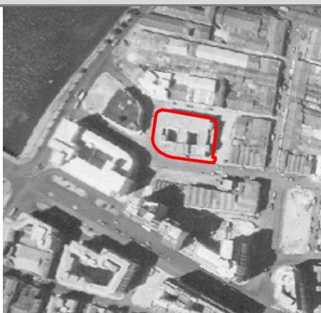
Trecho de fotografia aérea de 1951. É possível perceber a diferenciação volumétrica do acesso principal da edificação. Fonte: Museu da Cidade do Recife.
