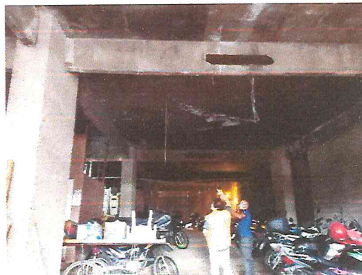
Foto 04: Vista do pavimento térreo
