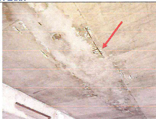
Foto 22: Evidência de trechos de lajes com aplicação de cimento/ argamassa.
