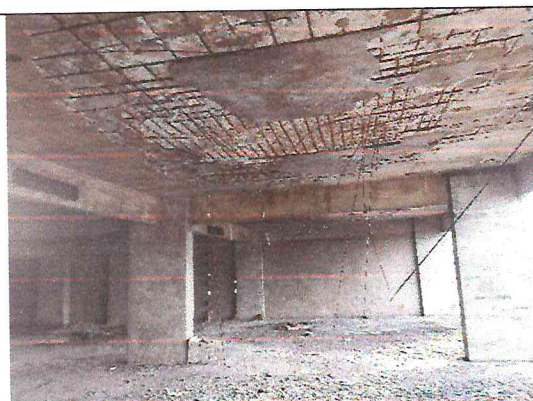
Fotos 19 e 20: Desgaste de lajes onde se observam queda de revestimentos e exposição de armaduras
