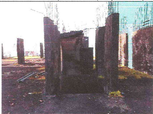
Fotos 25 e 26: Prolongamento de estruturas para construção de mais pavimentos-tipo da edificação
