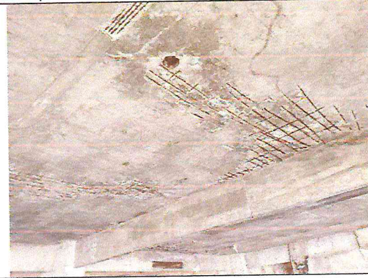
Fotos 19 e 20: Desgaste de lajes onde se observam queda de revestimentos e exposição de armaduras
