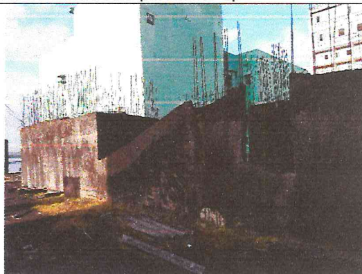
Fotos 25 e 26: Prolongamento de estruturas para construção de mais pavimentos-tipo da edificação
