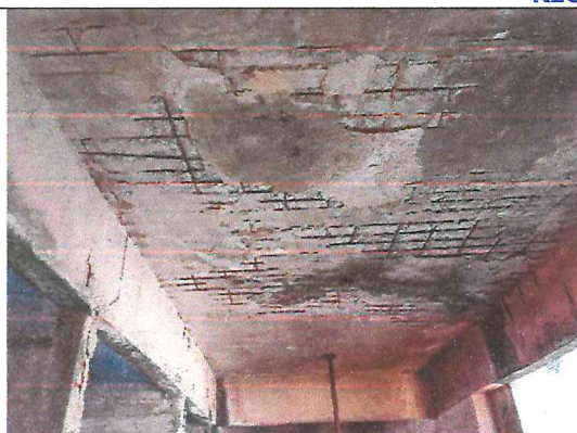
Foto 21: Desgaste de lajes onde se observam queda de revestimentos e exposição de armaduras
