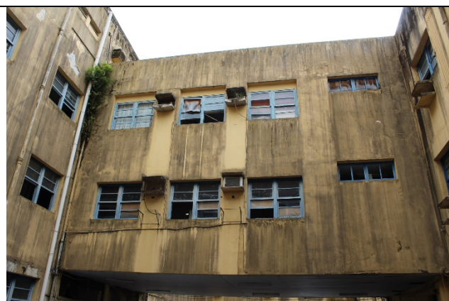
Fotos 15 e 16: Alteração de pintura por sucessivas infiltrações e ação de intempéries; danos em revestimentos e esquadrias de janelas (algumas inexistentes)
