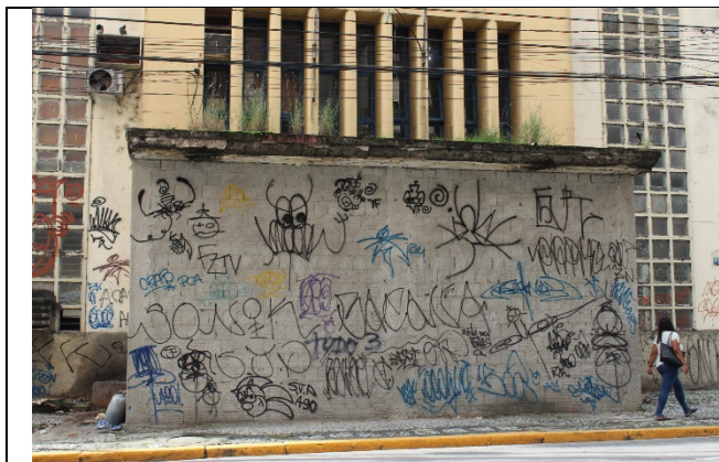
Fotos 11 e 12: Marquise voltada para a rua Siqueira Campos em precário estado, com riscos para colapsos, levando à construção de paredes de alvenaria para suporte estrutural
