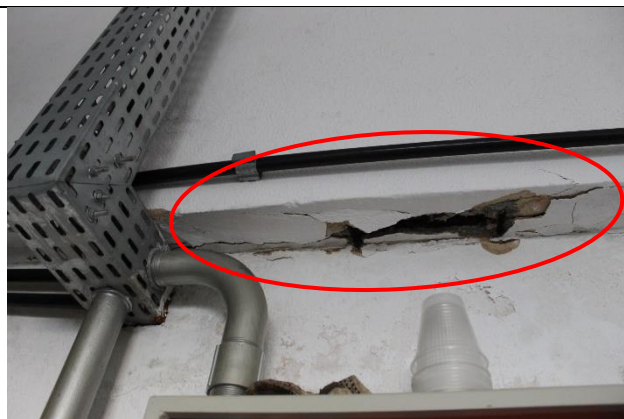
Fotos 11 e 12: Vista de instalações elétricas na casa de máquinas. É possível observar dano em viga acima do quadro elétrico, com exposição de armaduras oxidadas
