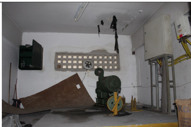
Foto 48: Vista da casa de máquinas desativada, em último pavimento
