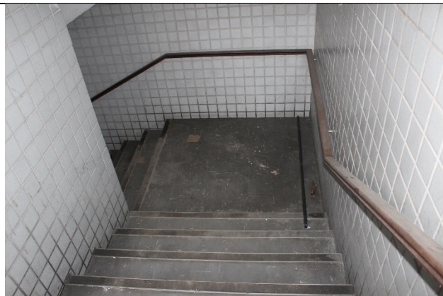
Foto 46: Escada em estado regular de conservação
