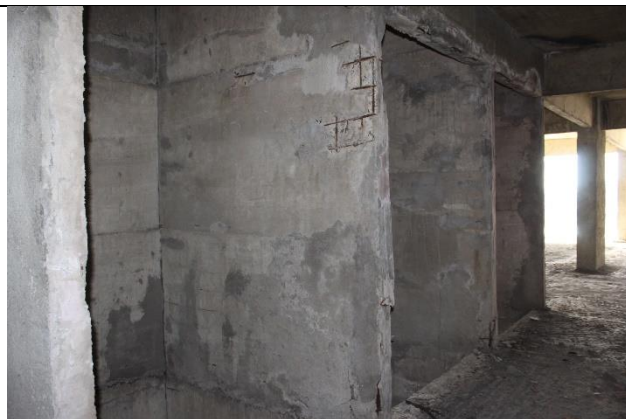
Fotos 19 e 20: Pilares embutidos e paredes de concreto armado dos elevadores com danos estruturais e exposição de armaduras oxidadas
