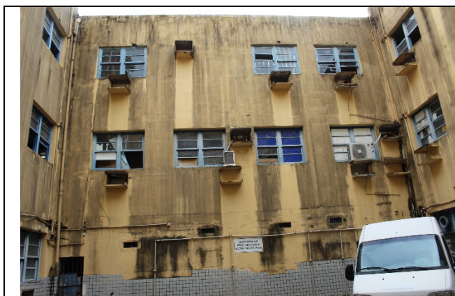
Fotos 15 e 16: Alteração de pintura por sucessivas infiltrações e ação de intempéries; danos em revestimentos e esquadrias de janelas (algumas inexistentes)
