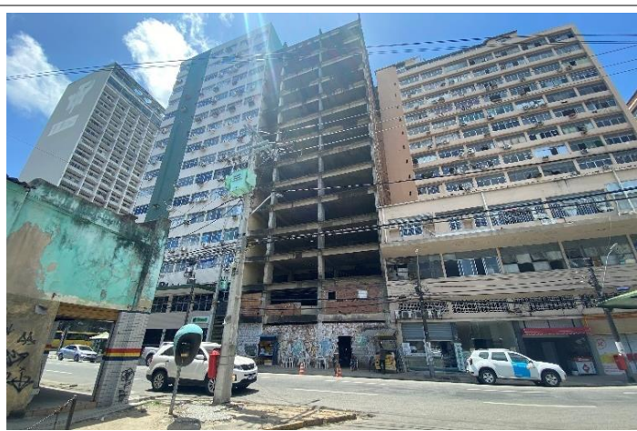
Vista da Rua Doutor José Henrique Wanderley para o conjunto edificado da quadra.
