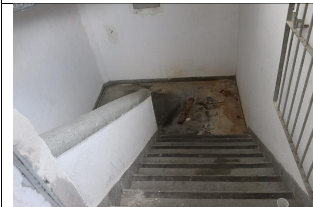
Foto 07: Escada interna em bom estado de conservação
