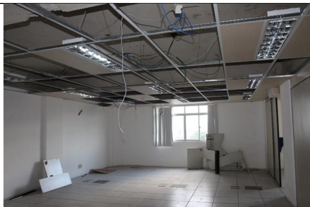
Fotos 19 e 20: Ambientes internos apresentam bom estado de alvenarias, pisos e elementos resistentes, havendo danos em forros e desativação de instalações elétricas
