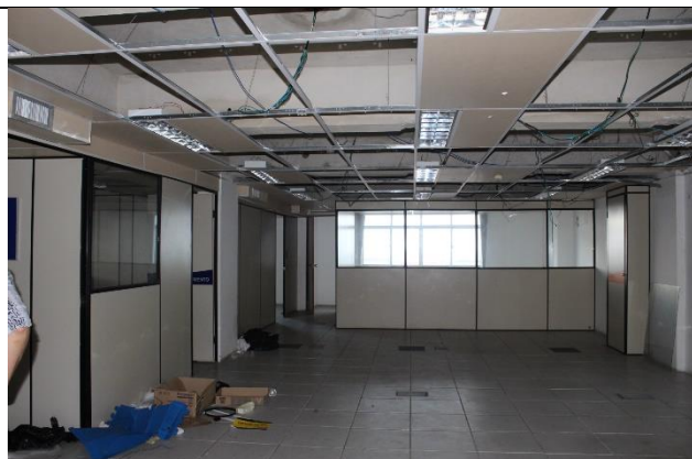
Fotos 19 e 20: Ambientes internos apresentam bom estado de alvenarias, pisos e elementos resistentes, havendo danos em forros e desativação de instalações elétricas
