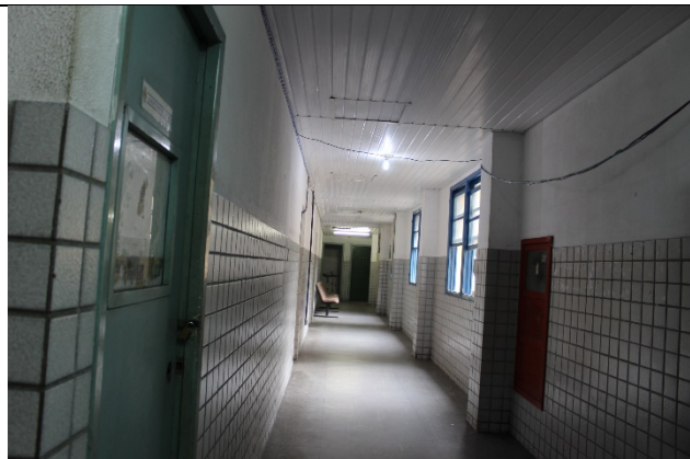
Foto 45: Vista para circulação interna em pavimento utilizado, com conservação regular
