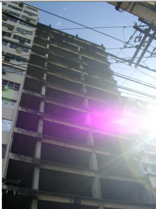
Vista para a Rua Siqueira Campos, 2011. Fonte: Acervo DPPC.
