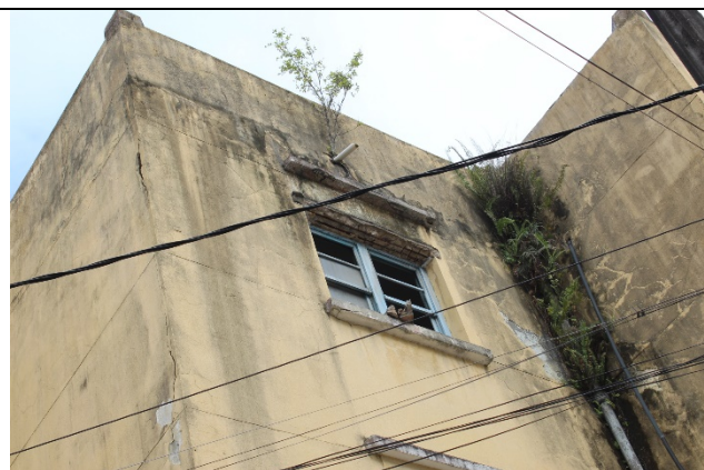
Foto 14: Fissuras, umidade e enraizamento de vegetação
