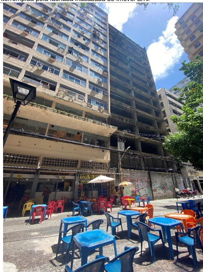
Nesta imagem, percebe-se a quebra da leitura do conjunto edificado com a fachada inacabada do S/N. No entanto, nota-se o alinhamento de vigas e lajes entre o N°279 e o S/N, indicando uma proposta de continuidade das fachadas.
