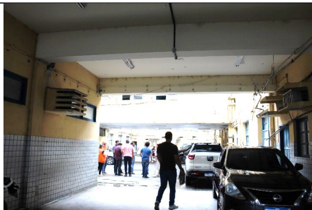
Foto 22: Entrada principal à edificação e pátio interno
