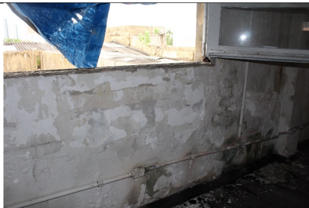
Foto 27: Infiltrações internas, ausência de esquadrias, proliferação de lodo e desgastes de revestimentos
