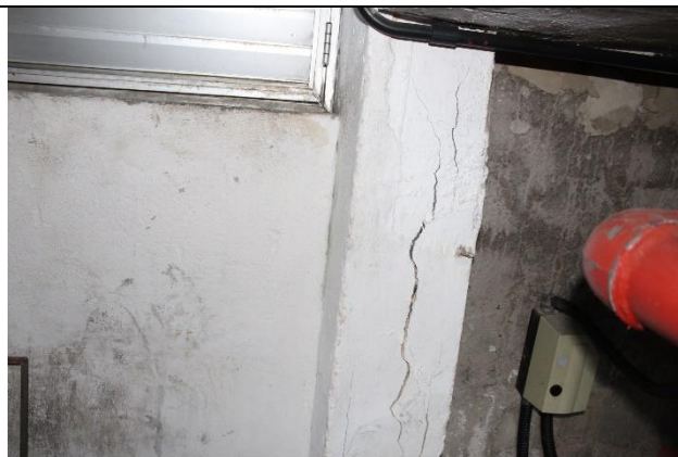
Foto 14: Fissura em pilar próximo ao reservatório, sugerindo oxidação de armaduras
