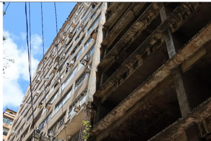
Detalhe da fachada da edificação de N°279 e leitura de conjunto interrompida pela fachada inacabada do imóvel S/N.
