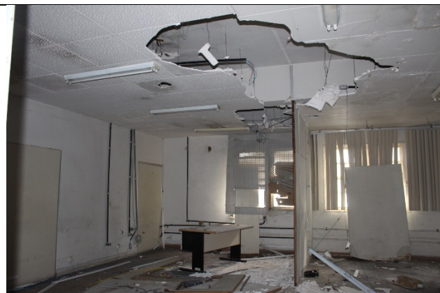
Foto 36: Colapso parcial de forro de gesso
