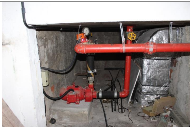
Foto 13: Vista das tubulações do reservatório superior em bom estado de conservação
