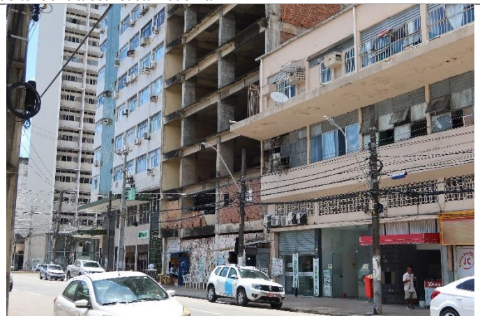
Destaque para ambiência da Rua Siqueira Campos com o térreo caracterizado pelo alto pé direito e pelas fachadas ativas com uso de comércio e serviços que são responsáveis pela movimentação da área.
