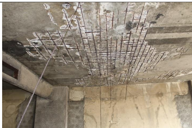
Fotos 11 e 12: Lajes apresentam danos severos, rupturas de armaduras que se encontram expostas e oxidadas, flexão de lajes presentes em áreas com maior degradação
