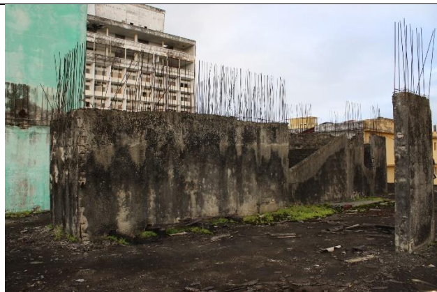
Fotos 25 e 26: Vistas do último pavimento existente, sem conclusão da edificação que sugere pavimentos superiores em projeto inacabado. A laje não indica aplicação de aditivos impermeabilizantes ou proteções mecânicas contra intempéries
