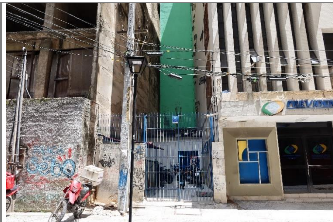
Detalhe do afastamento entre as edificações de N°300 e S/N°.
