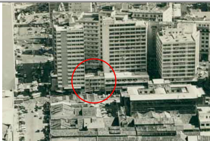
Vista para o bairro de Santo Antônio, em destaque área do lote em questão, nota-se que o esqueleto ainda não tinha sido erguido, século XX. Fonte: IBGE cidades.
