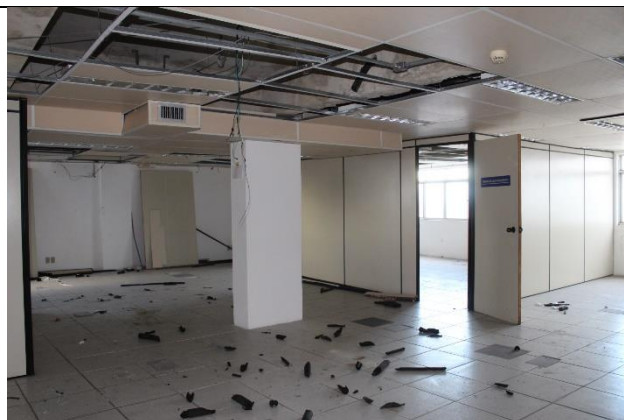
Foto 22: Danos em forros e desativação de instalações elétricas
