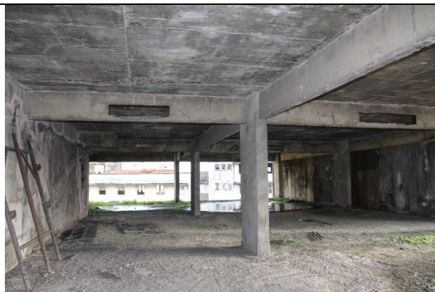
Fotos 23 e 24: Acúmulo de águas pluviais sobre lajes, mantendo-se umidade excessiva dos elementos internos
