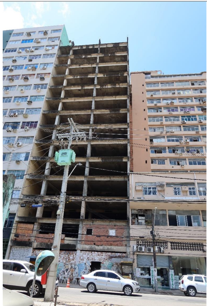
Vista a Rua Siqueira Campos. Nota-se verticalidade das edificações da quadra, característica dos edifícios construídos durante a reforma do bairro no século XX.
