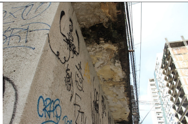
Fotos 11 e 12: Marquise voltada para a rua Siqueira Campos em precário estado, com riscos para colapsos, levando à construção de paredes de alvenaria para suporte estrutural
