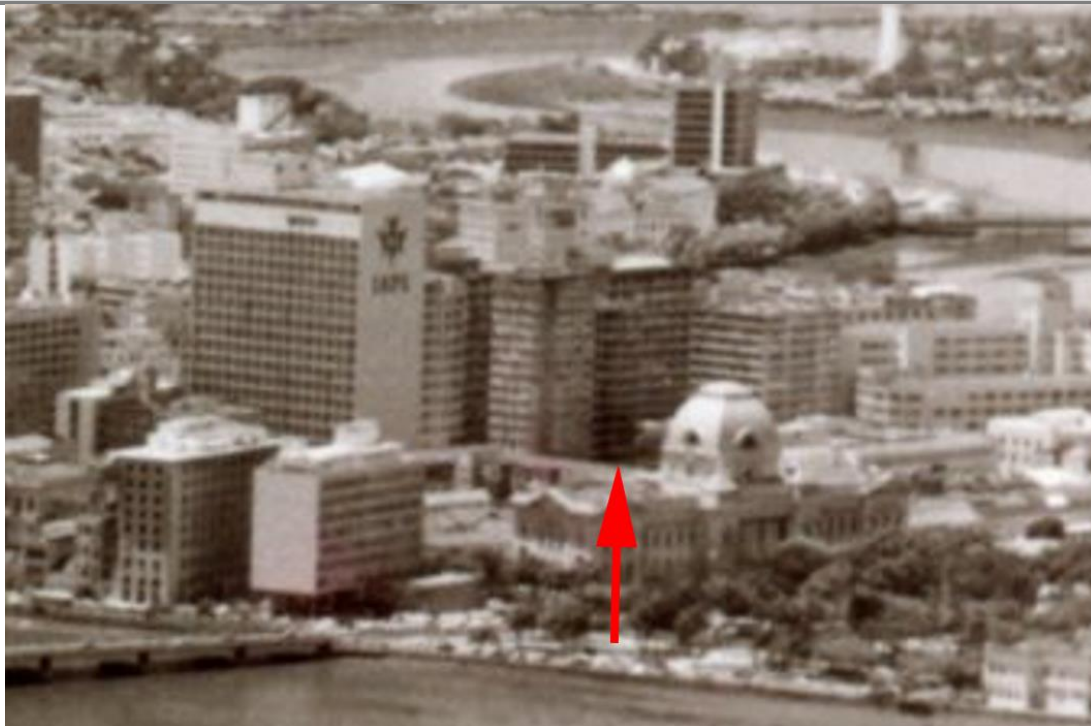
Vista área do bairro de Santo Antônio, em destaque área do lote com esqueleto já erguido, 1979. Fonte: Acervo DPE-URB.
