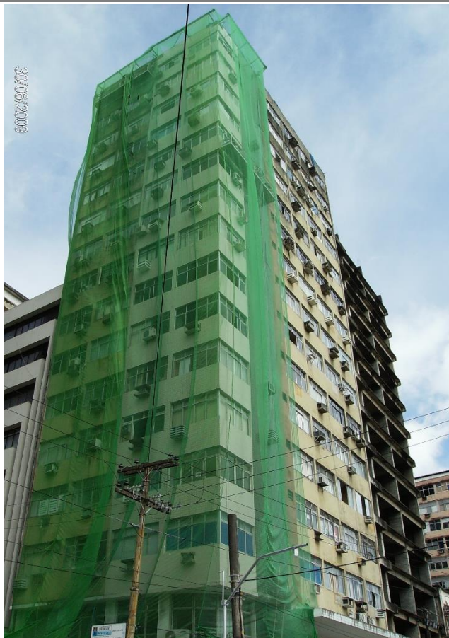
Vista para a Rua Siqueira Campos, 2007. Fonte: Acervo DPPC.
