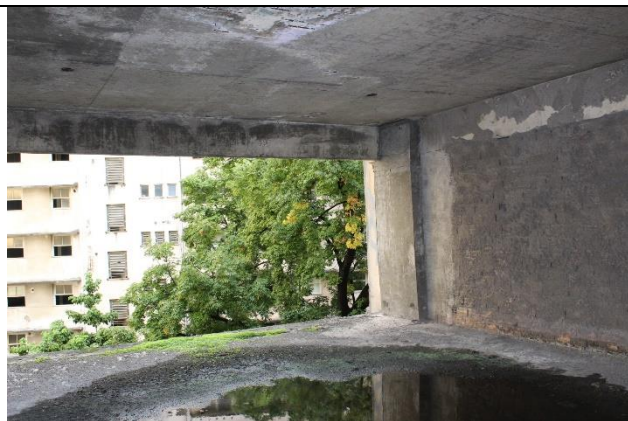
Fotos 23 e 24: Acúmulo de águas pluviais sobre lajes, mantendo-se umidade excessiva dos elementos internos
