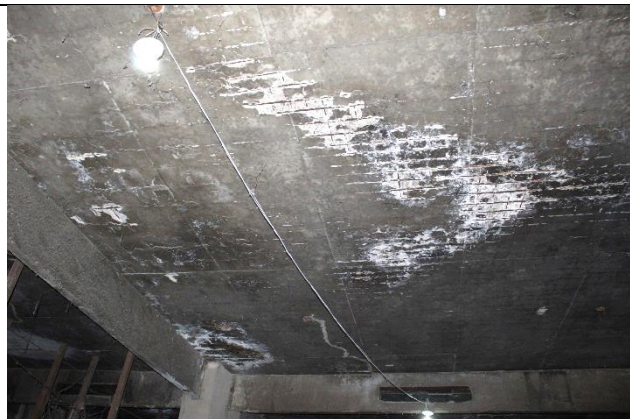
Fotos 03 e 04: Pavimento térreo (estacionamento) – danos estruturais em lajes, sugerindo camada de recobrimento insuficiente
