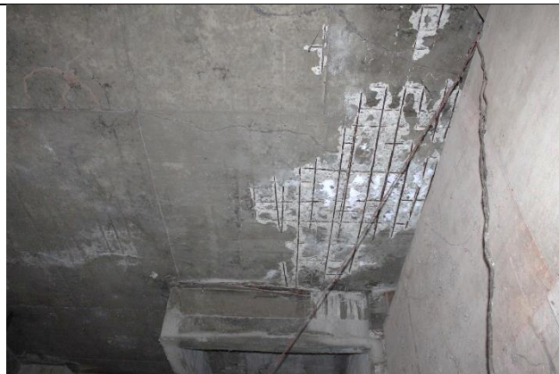
Fotos 03 e 04: Pavimento térreo (estacionamento) – danos estruturais em lajes, sugerindo camada de recobrimento insuficiente
