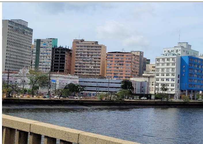
Vista da Ponte Princesa Isabel para o conjunto edificado do bairro de Santo Antônio, com destaque para a quadra 11565075. Nota-se impacto do imóvel inacabado na paisagem.
