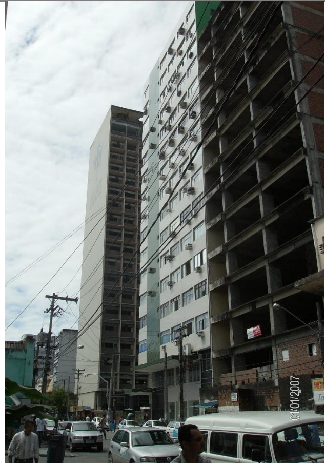
Vista a Rua Siqueira Campos, 2010. Fonte: Acervo DPPC.
