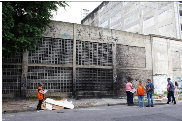
Foto 02: Fachada pela Rua da Saudade
