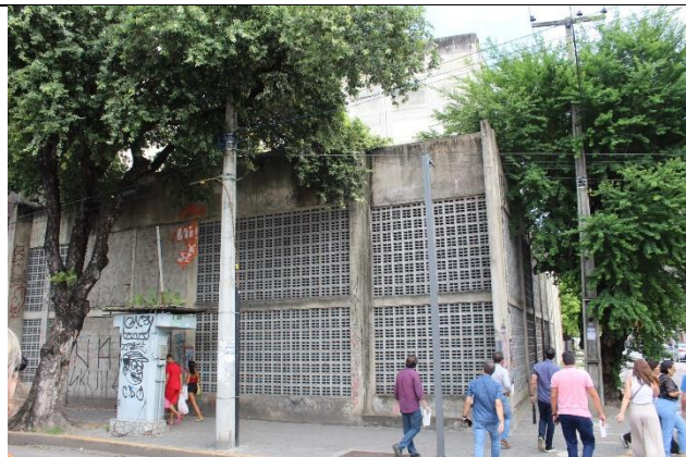
Foto 01: Fachada pela Rua do Riachuelo
