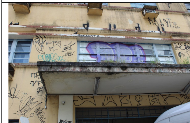
Foto 13: Marquise voltada para a rua Dr. José Henrique Wanderley com infiltrações e enraizamento de vegetação
