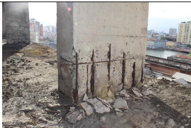
Fotos 17 e 18: Pilares com danos estruturais e exposição de armaduras oxidadas, sobretudo nas bases
