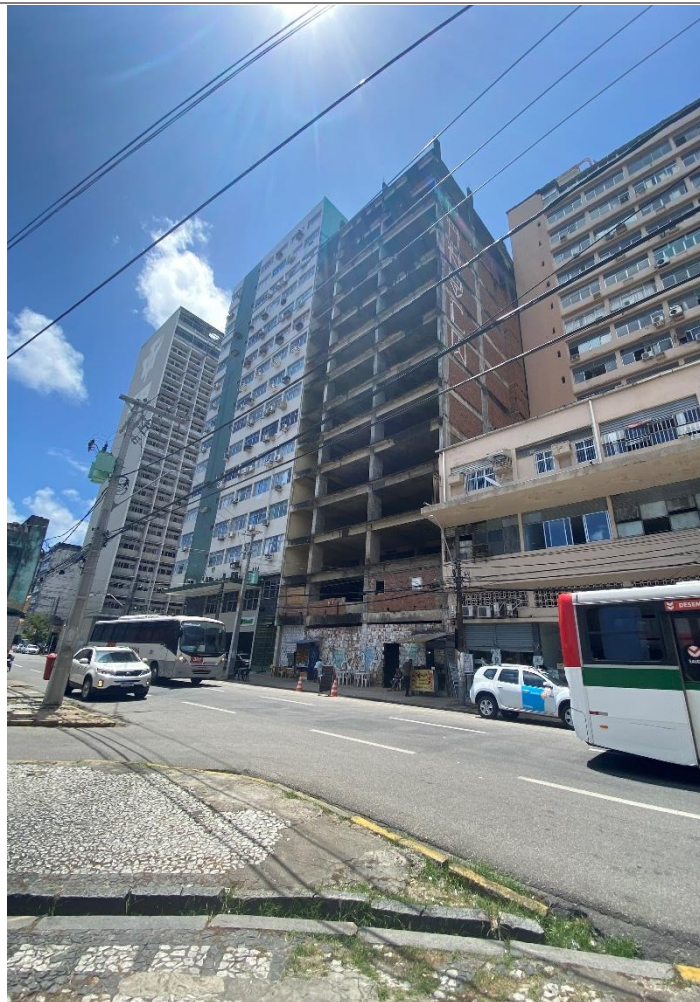
Vista para a Rua Siqueira Campos com destaque para escala das edificações da quadra.
