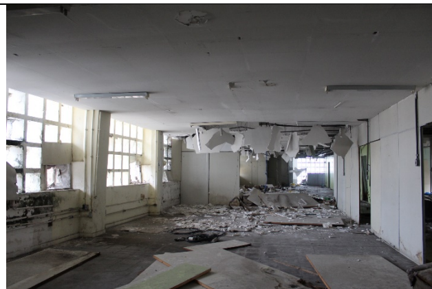
Foto 40: Vista para salão em último pavimento
