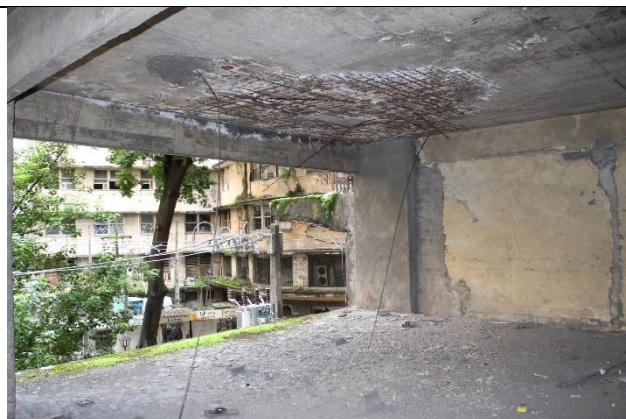
Fotos 11 e 12: Lajes apresentam danos severos, rupturas de armaduras que se encontram expostas e oxidadas, flexão de lajes presentes em áreas com maior degradação
