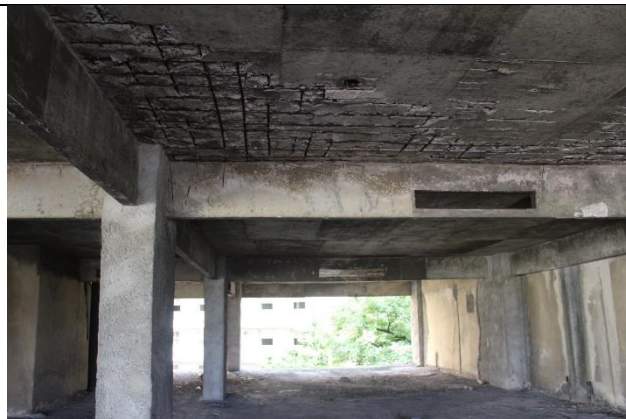
Fotos 15 e 16: Armaduras oxidadas de aspecto avermelhado, pulverulento e poroso, denominados ferrugem, sugerindo corrosão eletroquímica em meio aquoso
