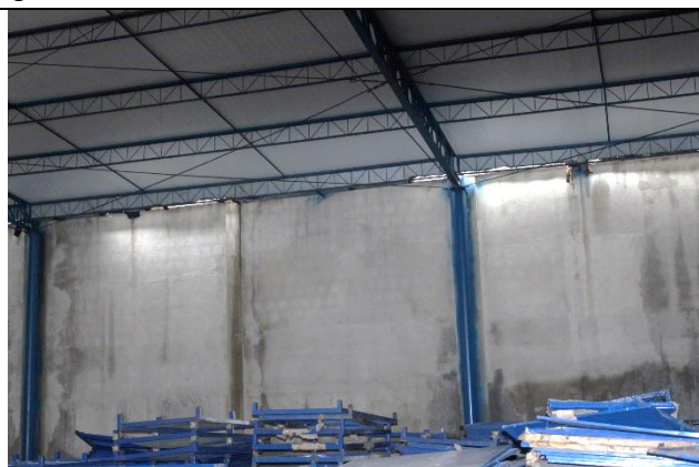
Fotos 05 e 06: Vista parcial interna: Estilo construtivo de galpão, manchas de umidade nas alvenarias; elementos de cobertura sugerem bom estado de conservação
