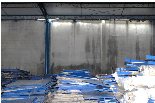
Fotos 05 e 06: Vista parcial interna: Estilo construtivo de galpão, manchas de umidade nas alvenarias; elementos de cobertura sugerem bom estado de conservação
