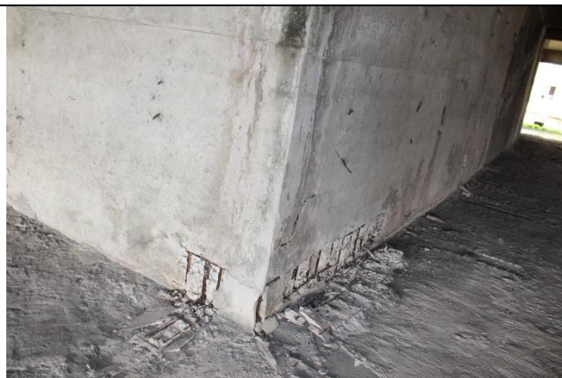
Fotos 17 e 18: Pilares com danos estruturais e exposição de armaduras oxidadas, sobretudo nas bases
