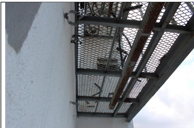
Fotos 05 e 06: Detalhe para estrutura metálica oxidada em varanda lateral
