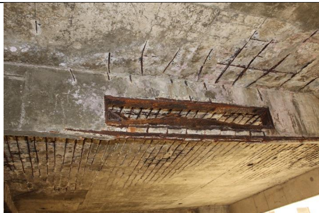
Fotos 15 e 16: Armaduras oxidadas de aspecto avermelhado, pulverulento e poroso, denominados ferrugem, sugerindo corrosão eletroquímica em meio aquoso
