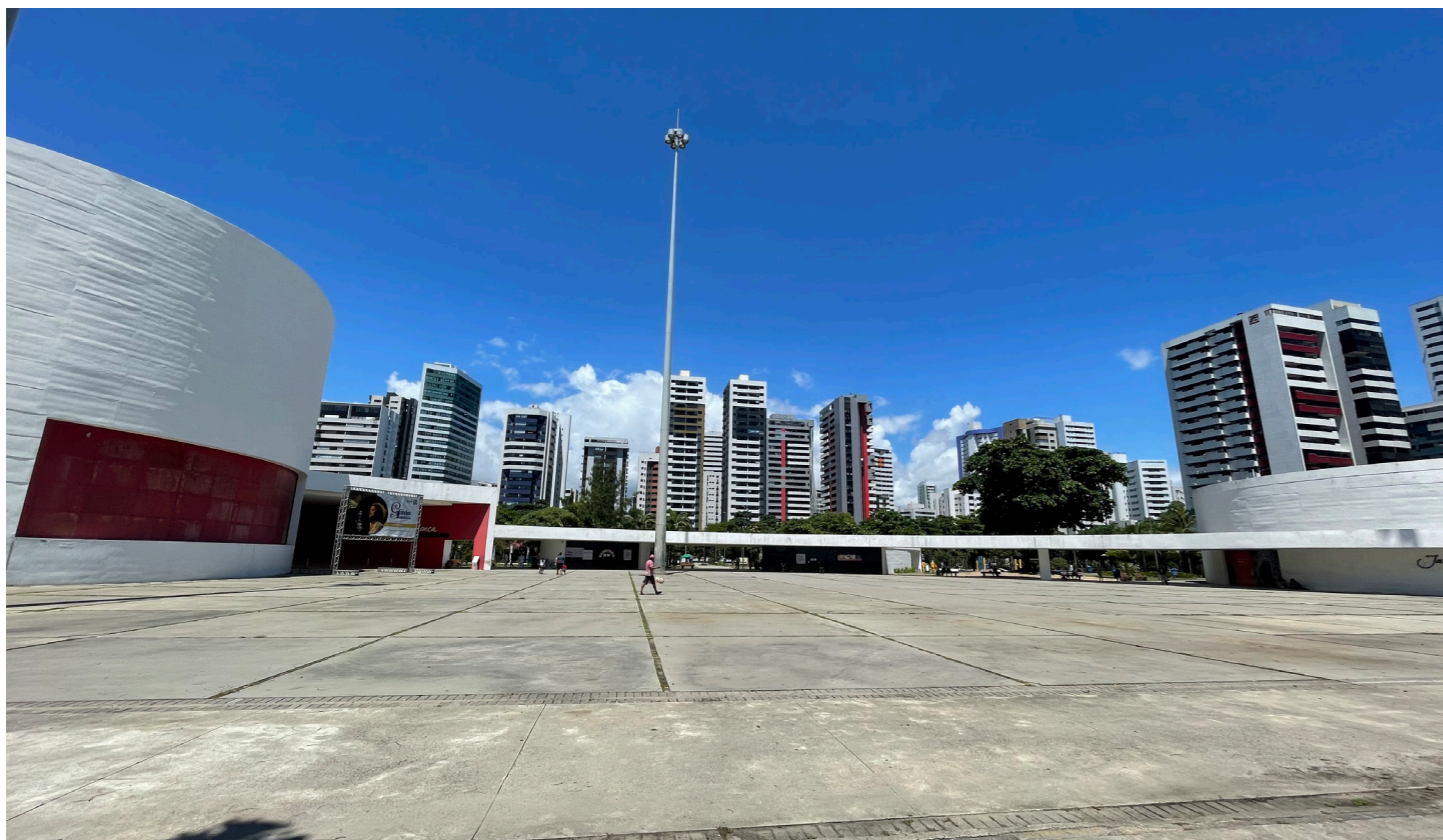
Figura 51 — Foto da estrutura. Fonte: visita técnica feita pela equipe em janeiro de 2022.
