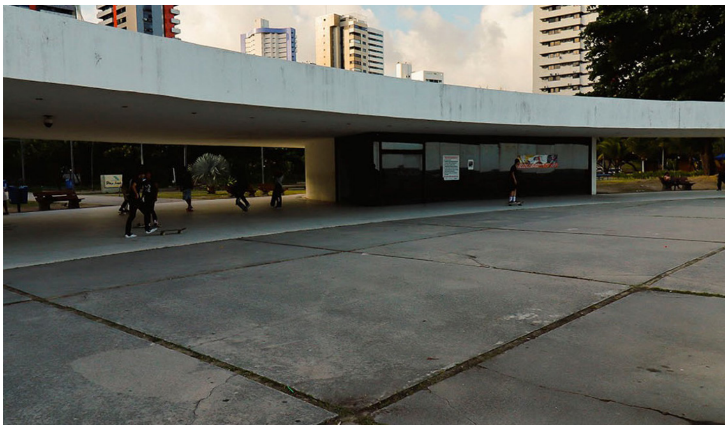
Figura 28 — Foto externa da edificação. Fonte: BNDES.
