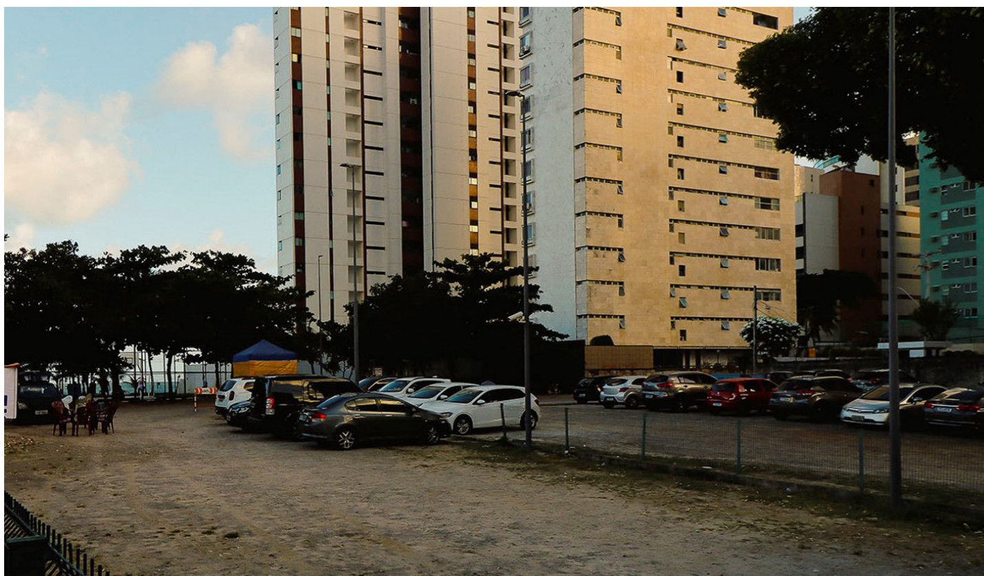
Figura 47 — Foto da estrutura. Fonte: BNDES.
