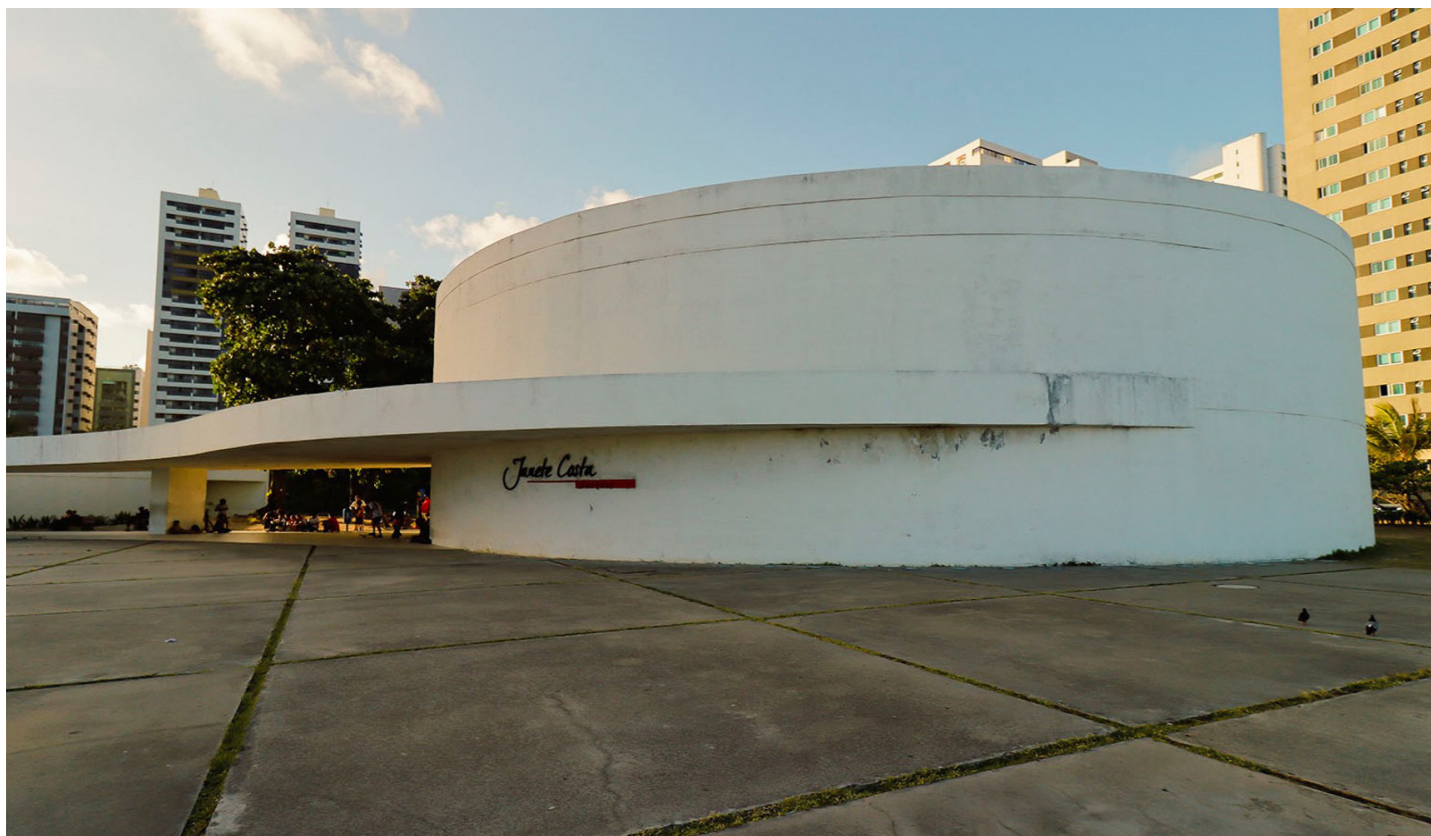
Figura 23 — Foto externa da edificação. Fonte: BNDES.
