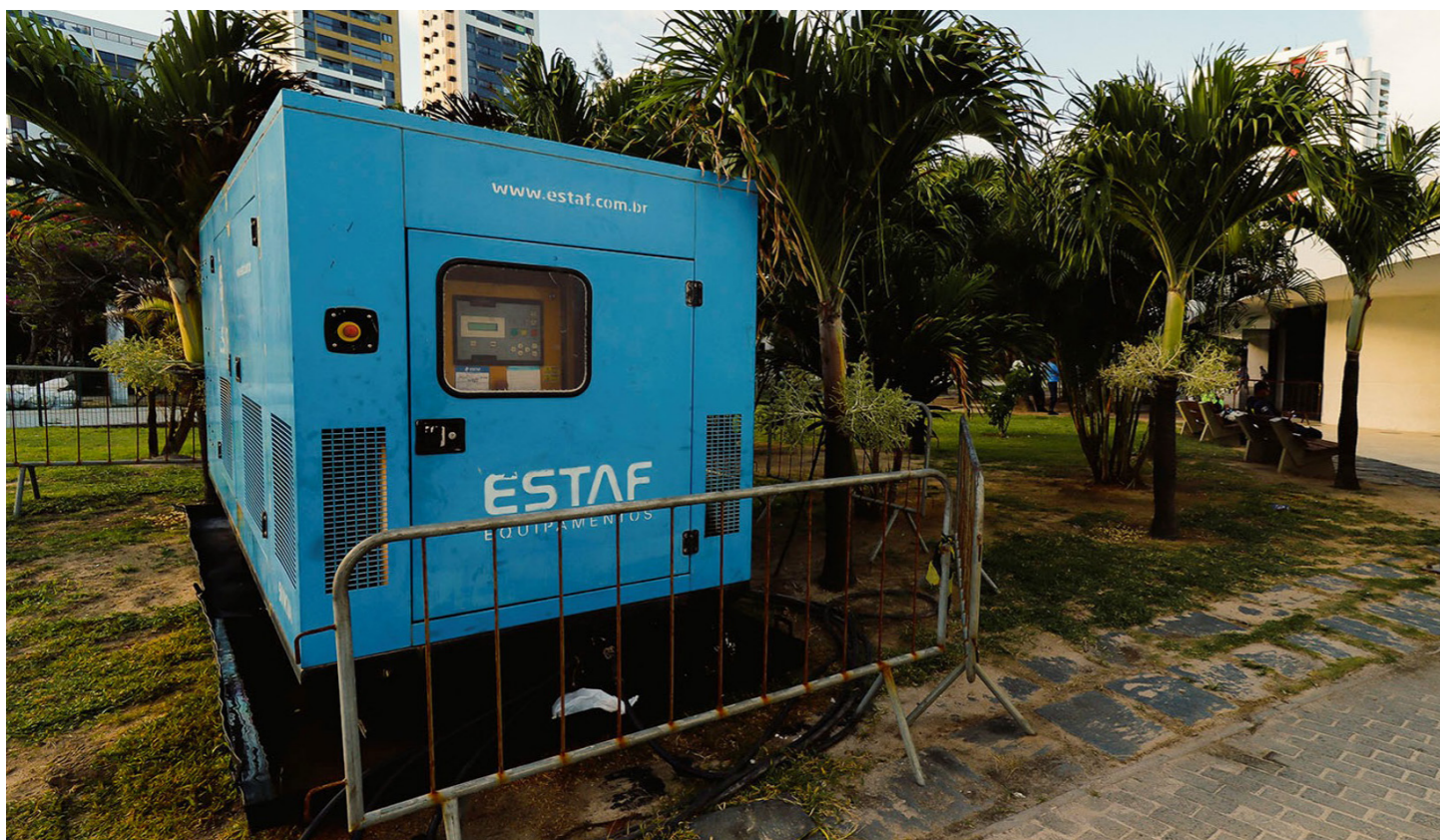
Figura 41 — Foto da estrutura. Fonte: BNDES.
