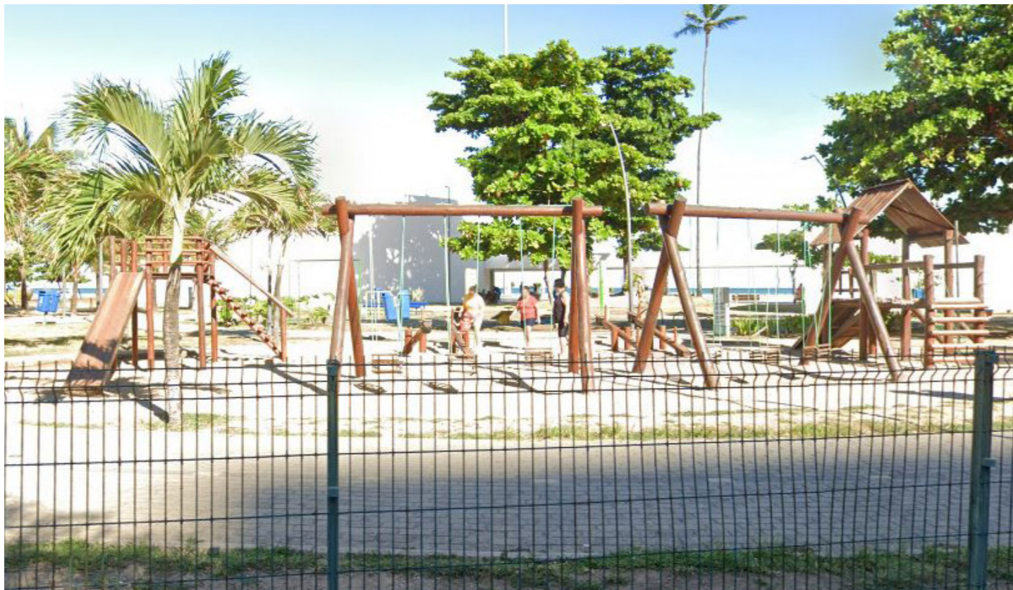
Figura 37 — Foto da estrutura. Fonte: google street view.
