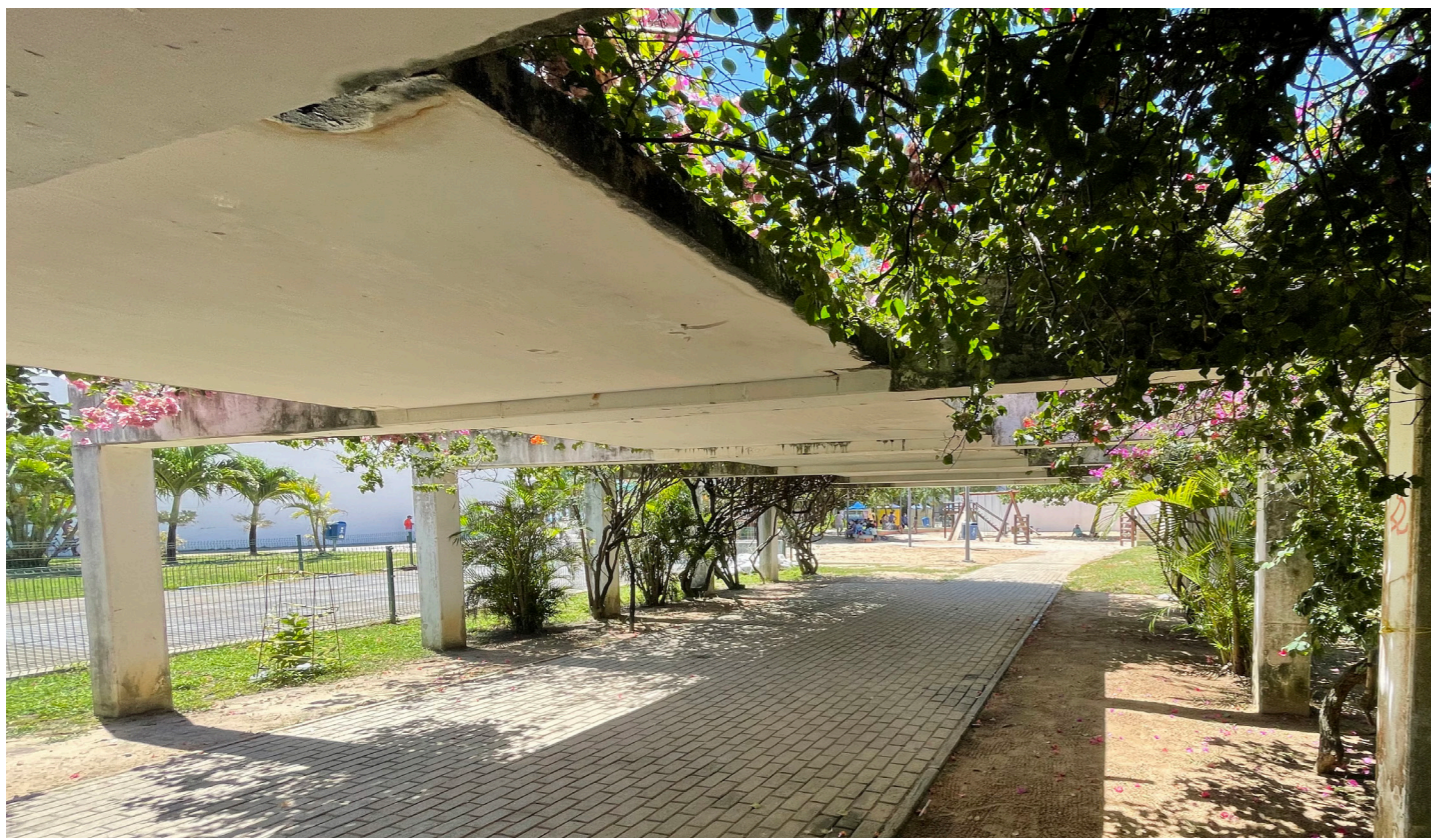
Figura 39 — Foto da estrutura. Fonte: visita técnica feita pela equipe em janeiro de 2022.
