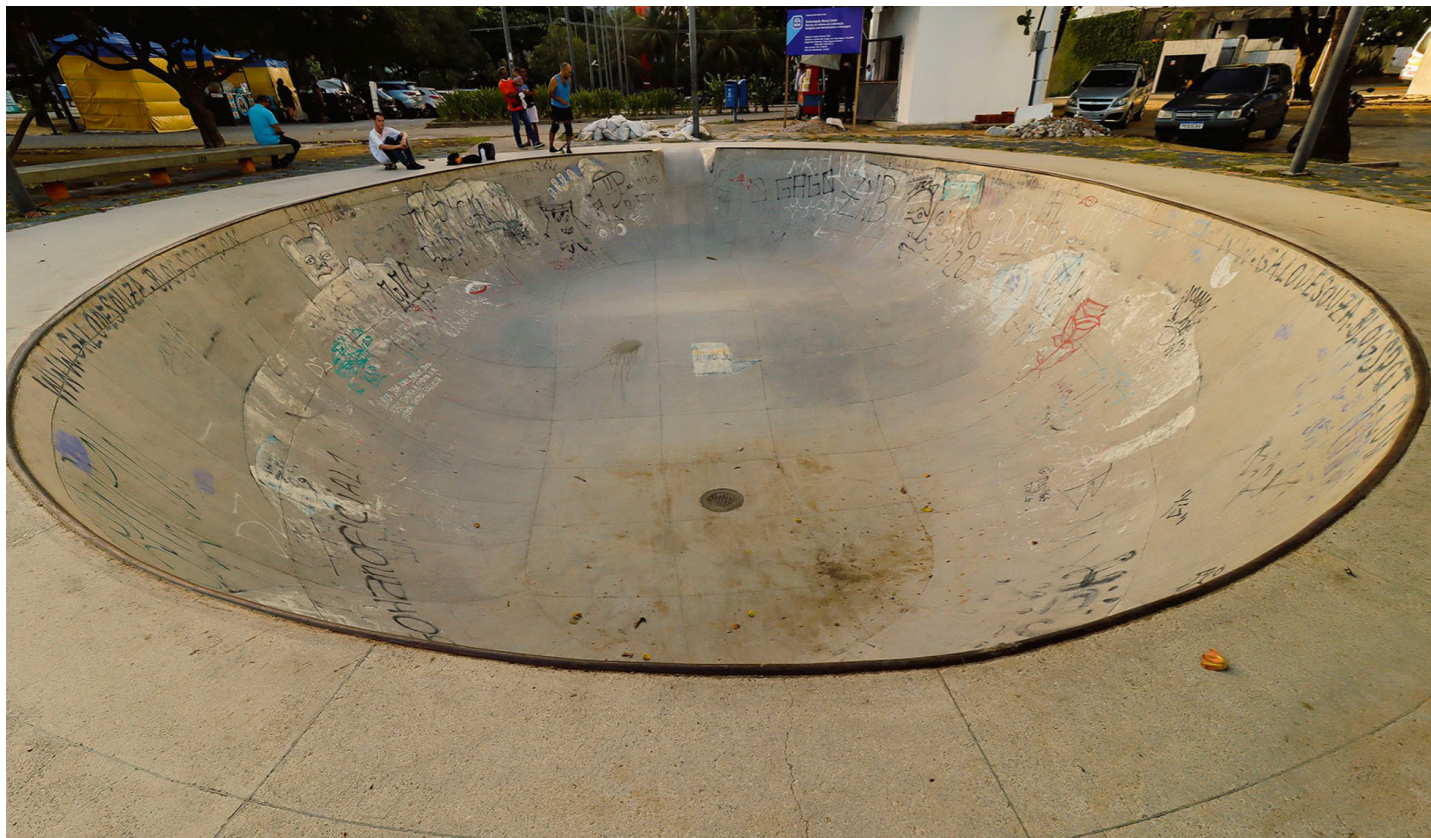
Figura 33 — Foto da estrutura. Fonte: BNDES.
