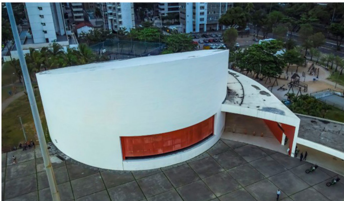
Figura 21 — Foto externa da edificação. Fonte: BNDES.
