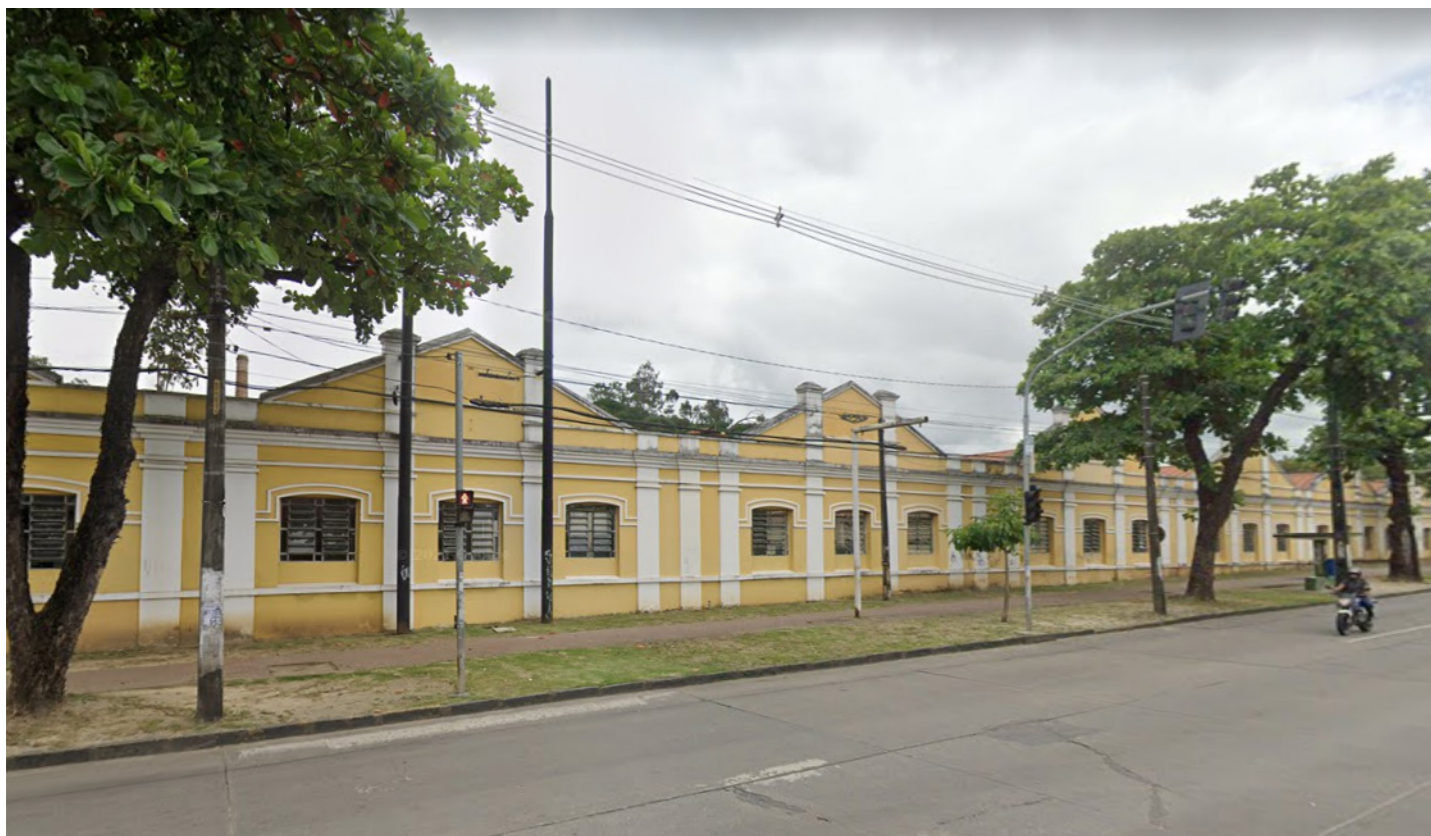
Figura 52 — Foto da edificação. Fonte: Google Street View.
