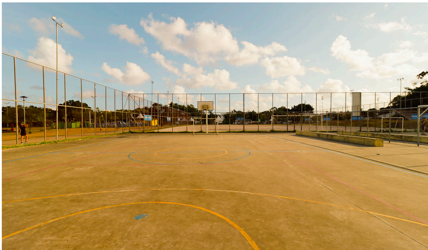
Figura 22 — Foto da estrutura. Fonte: BNDES.
