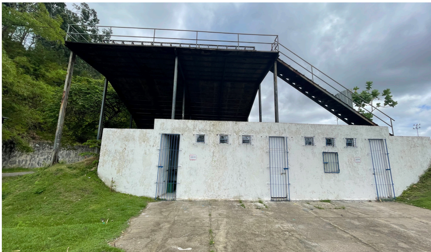
Figura 54 — Foto da estrutura. Fonte: BNDES. Fonte: visita técnica feita pela equipe em janeiro de 2022.
