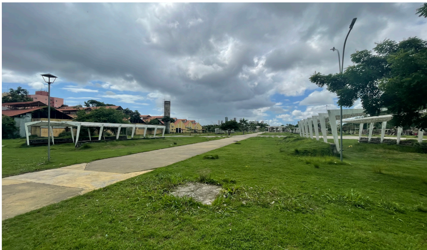
Figura 19 — Foto da estrutura. Fonte: BNDES. Fonte: visita técnica feita pela equipe em janeiro de 2022.
