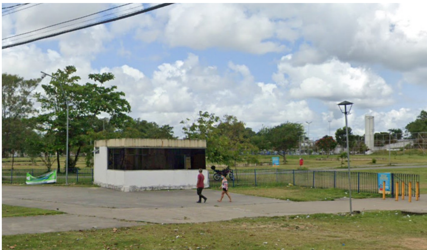
Figura 58 — Foto da edificação. Fonte: Google Street View.
