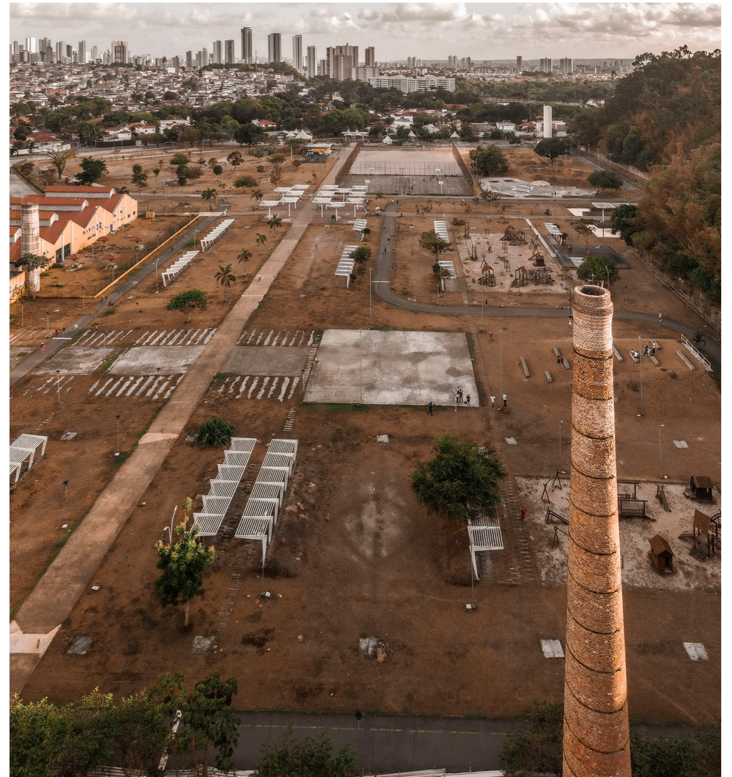
Figura 9 — Foto aérea Parque Urbano da Macaxeira. Fonte: BNDES.
