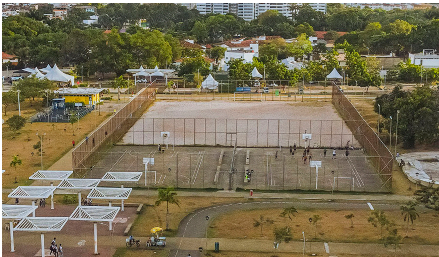
Figura 18 — Foto da estrutura. Fonte: BNDES.
