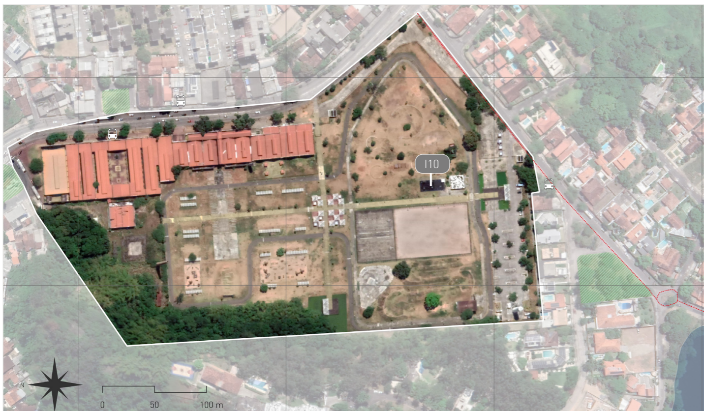
Figura 36 — Localização da estrutura. Fonte: Mapa de confecção própria, a partir de informações colhidas em campo e fornecidas pelo BNDES.
