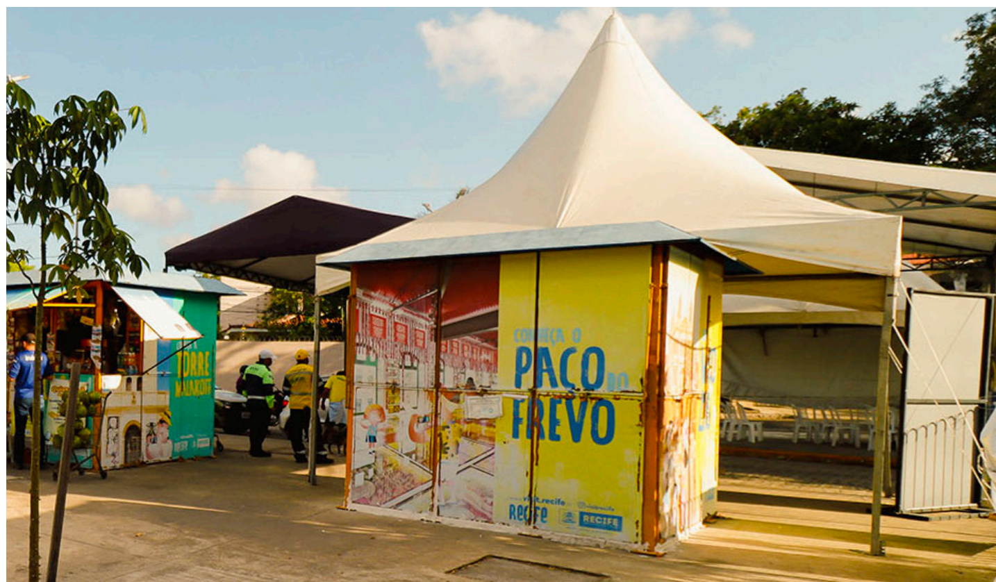
Figura 71 — Foto da edificação. Fonte: visita técnica feita pela equipe em janeiro de 2022.
