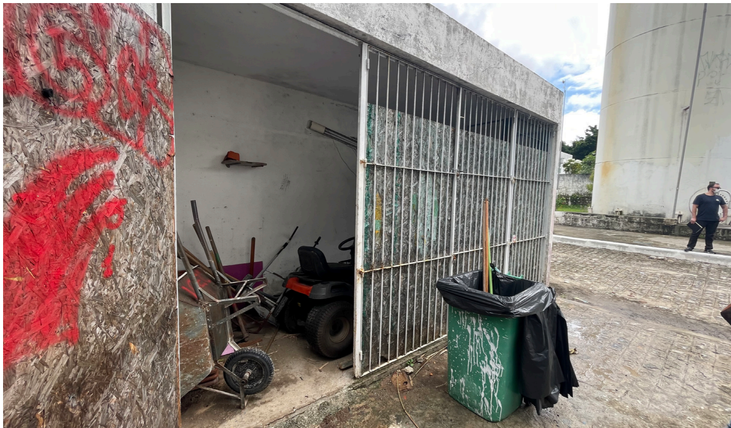
Figura 61 — Foto da edificação. Fonte: visita técnica feita pela equipe em agosto de 2021
