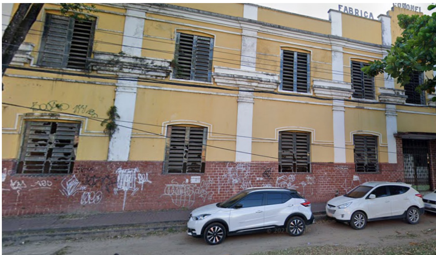
Figura 50 — Foto da edificação. Fonte: Google Street View.
