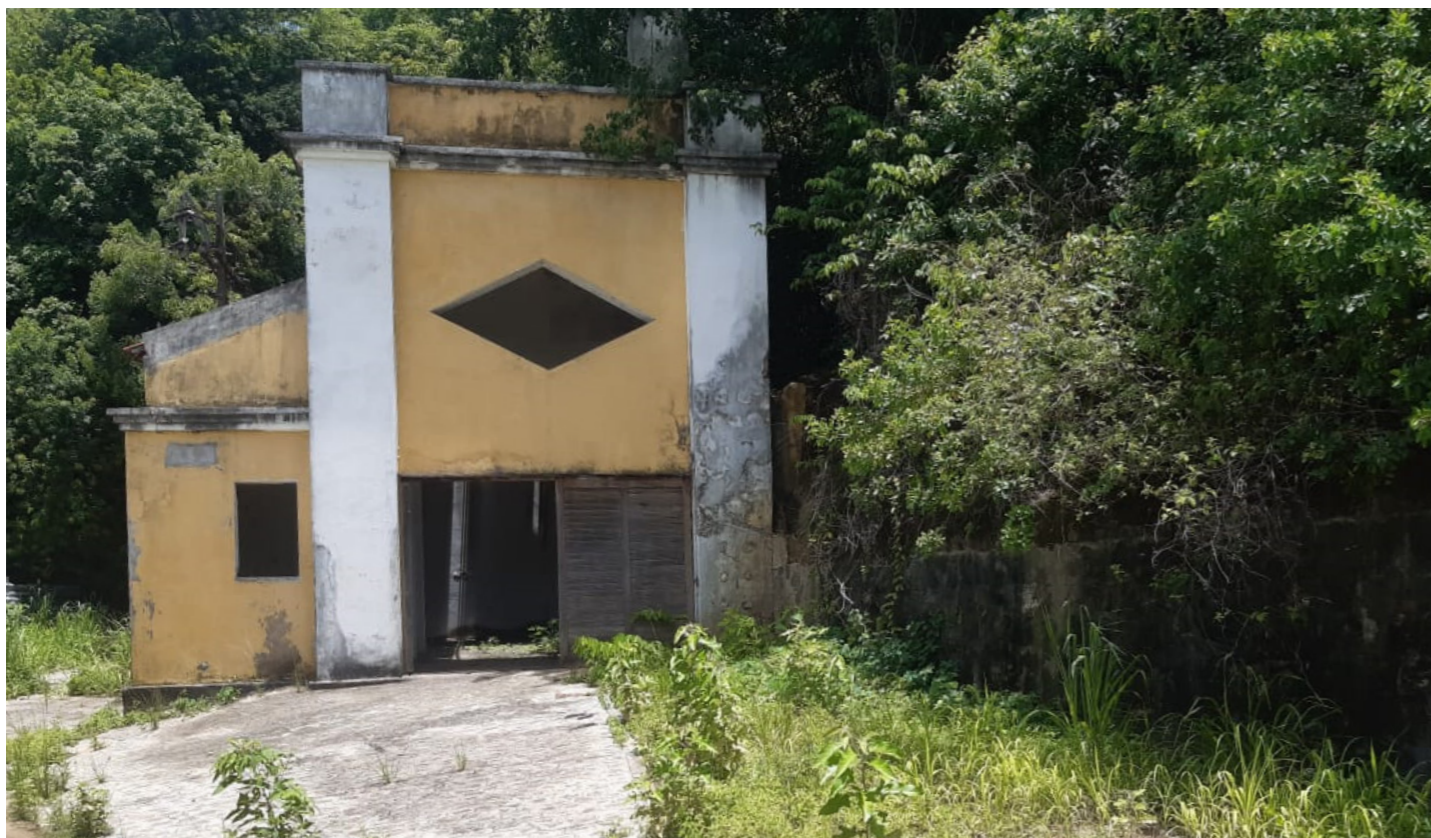
Figura 21 — Foto da edificação. Fonte: visita técnica feita pela equipe em janeiro de 2022.
