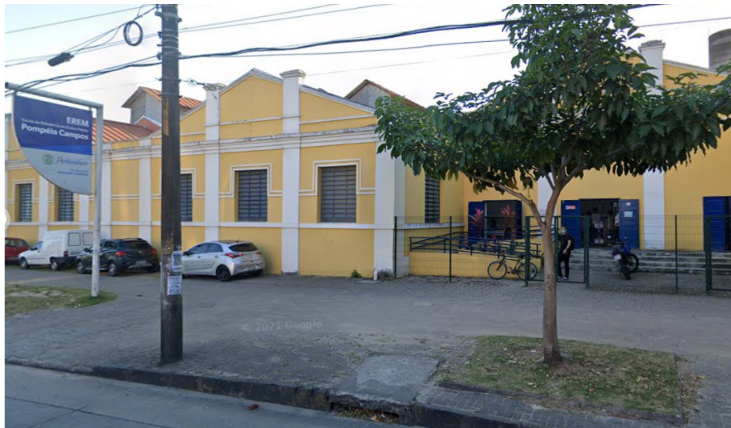
Figura 48 — Foto da edificação. Fonte: Google Street View.
