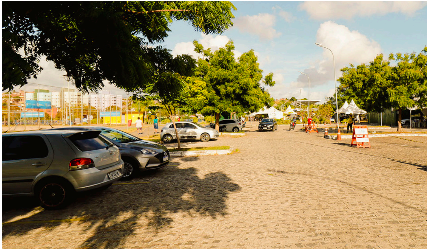
Figura 60 — Foto da estrutura. Fonte: BNDES.
