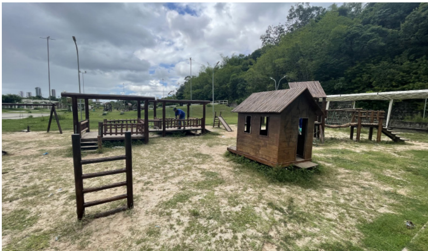
Figura 35 — Foto da estrutura. Fonte: visita técnica feita pela equipe em janeiro de 2022.
