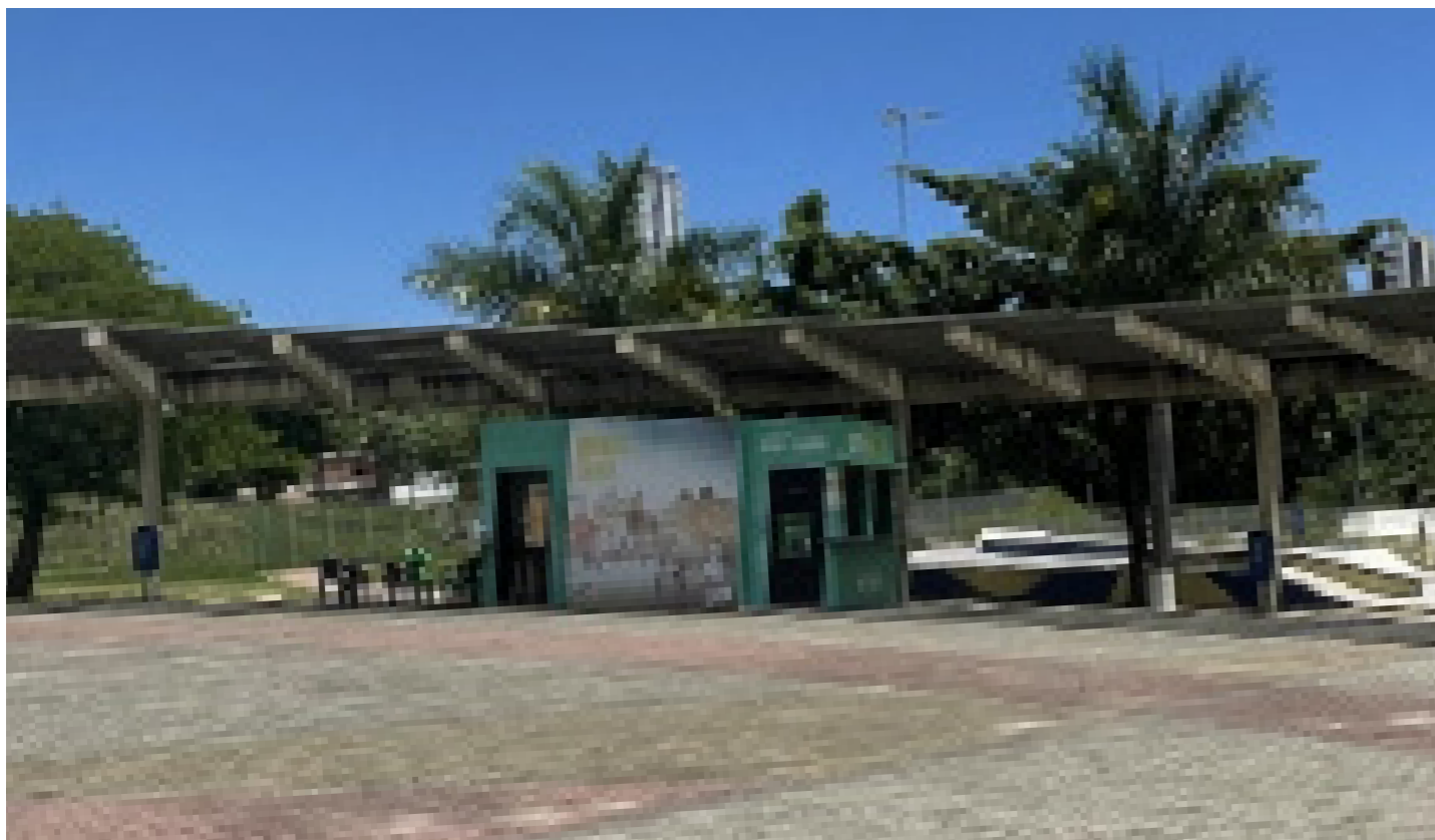
Figura 24 — Foto da edificação. Fonte: visita técnica feita pela equipe em janeiro de 2022.
