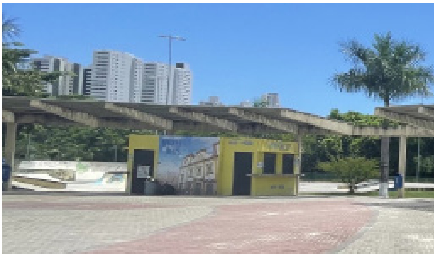
Figura 22 — Foto da edificação. Fonte: visita técnica feita pela equipe em janeiro de 2022.
