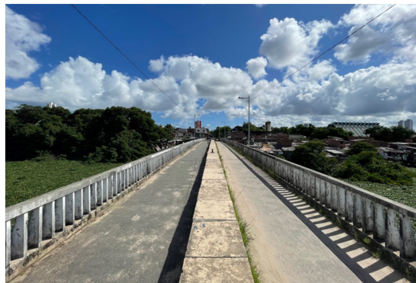
Figura 9 — Passarela Santana-Vila Santa Luzia. Foto: Equipe, Janeiro 2022.
