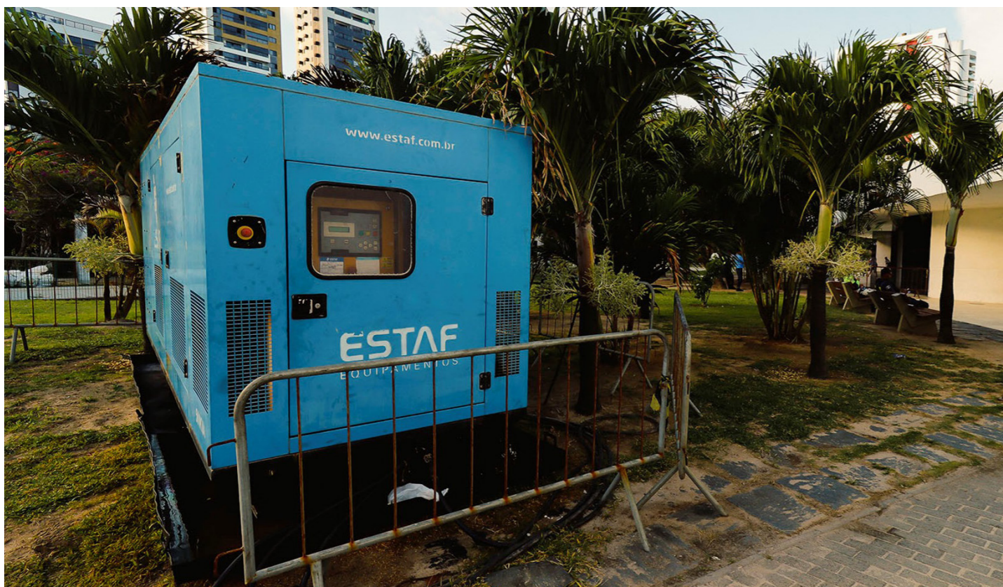
Figura 41 — Foto da estrutura. Fonte: BNDES.
