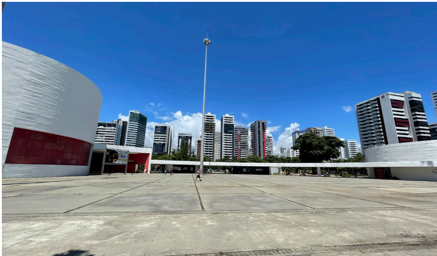
Figura 51 — Foto da estrutura. Fonte: visita técnica feita pela equipe em janeiro de 2022.
