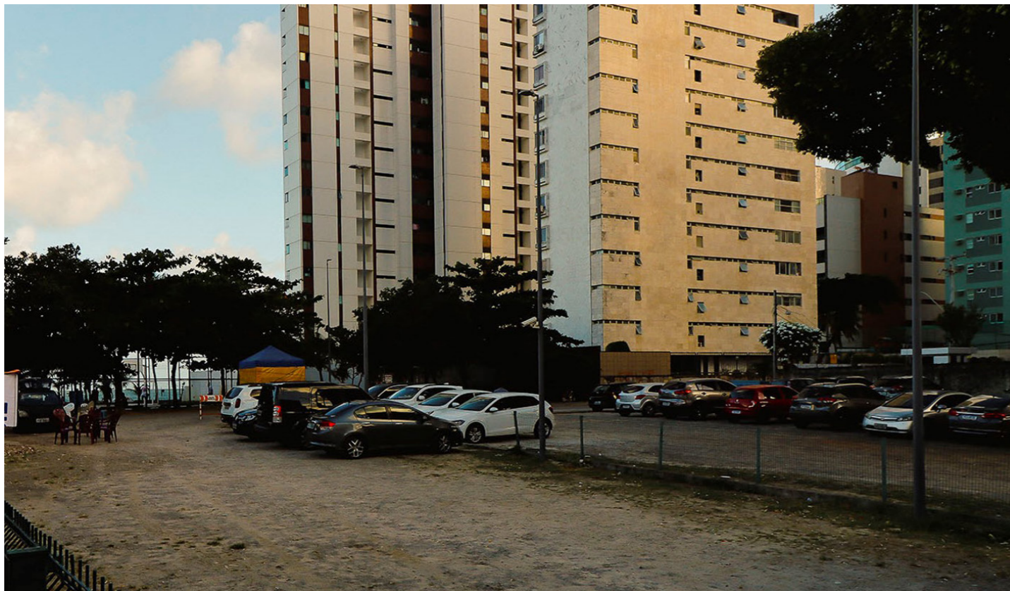
Figura 47 — Foto da estrutura. Fonte: BNDES.
