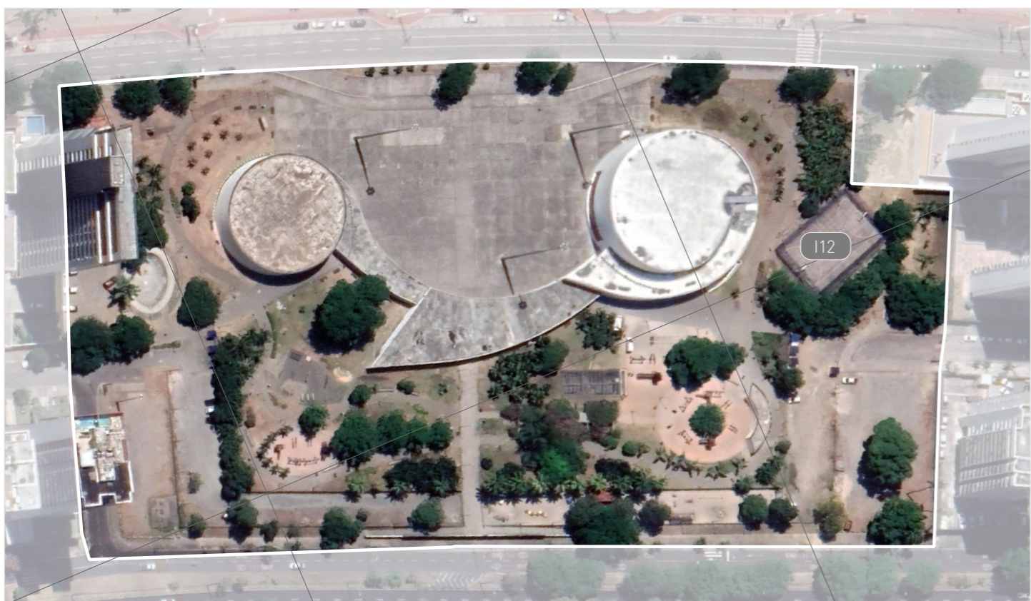
Figura 50 — Localização da estrutura. Fonte: Mapa de confecção própria, a partir de informações colhidas em campo e fornecidas pelo BNDES.
