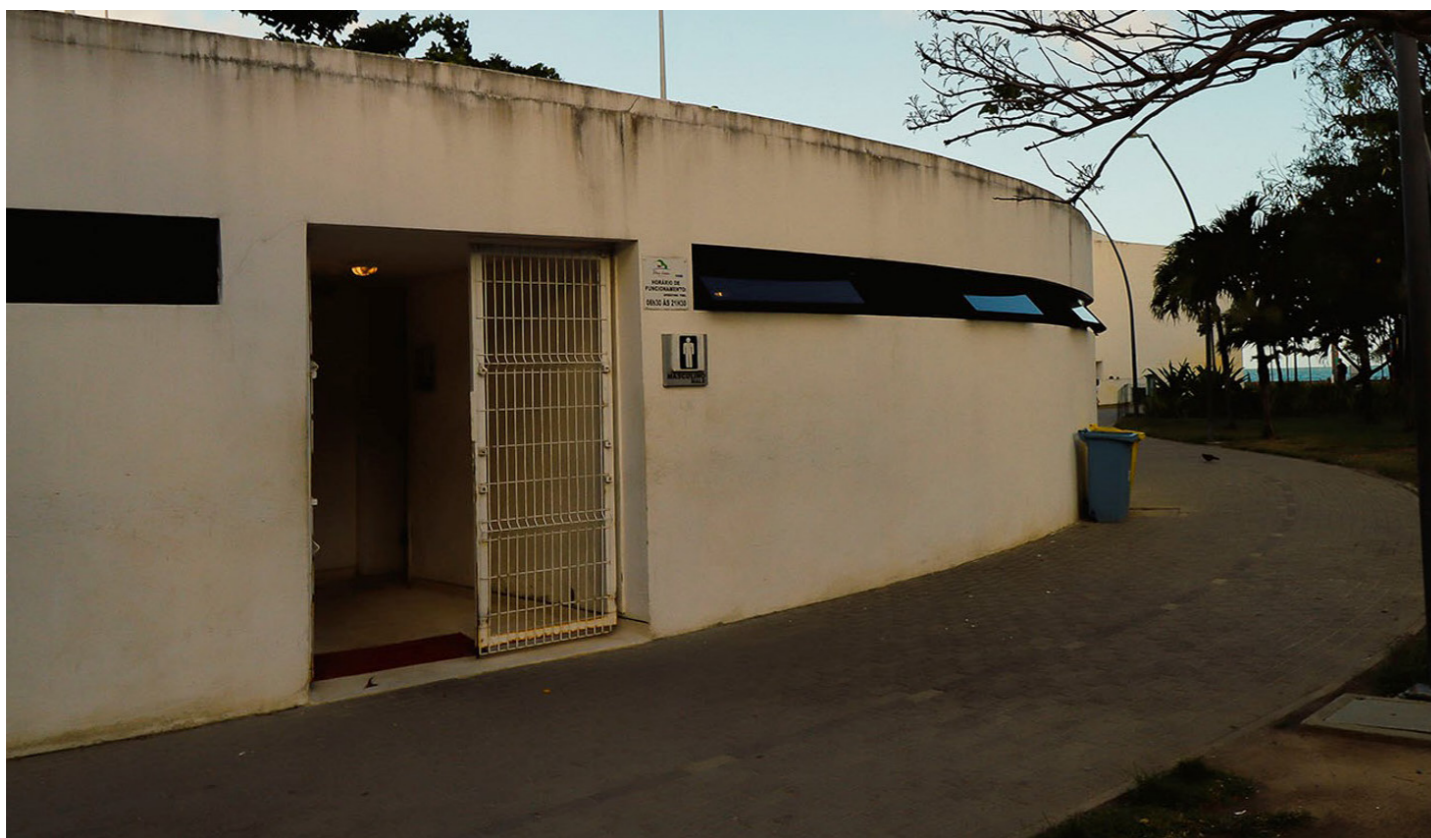
Figura 43 — Foto da estrutura. Fonte: BNDES.
