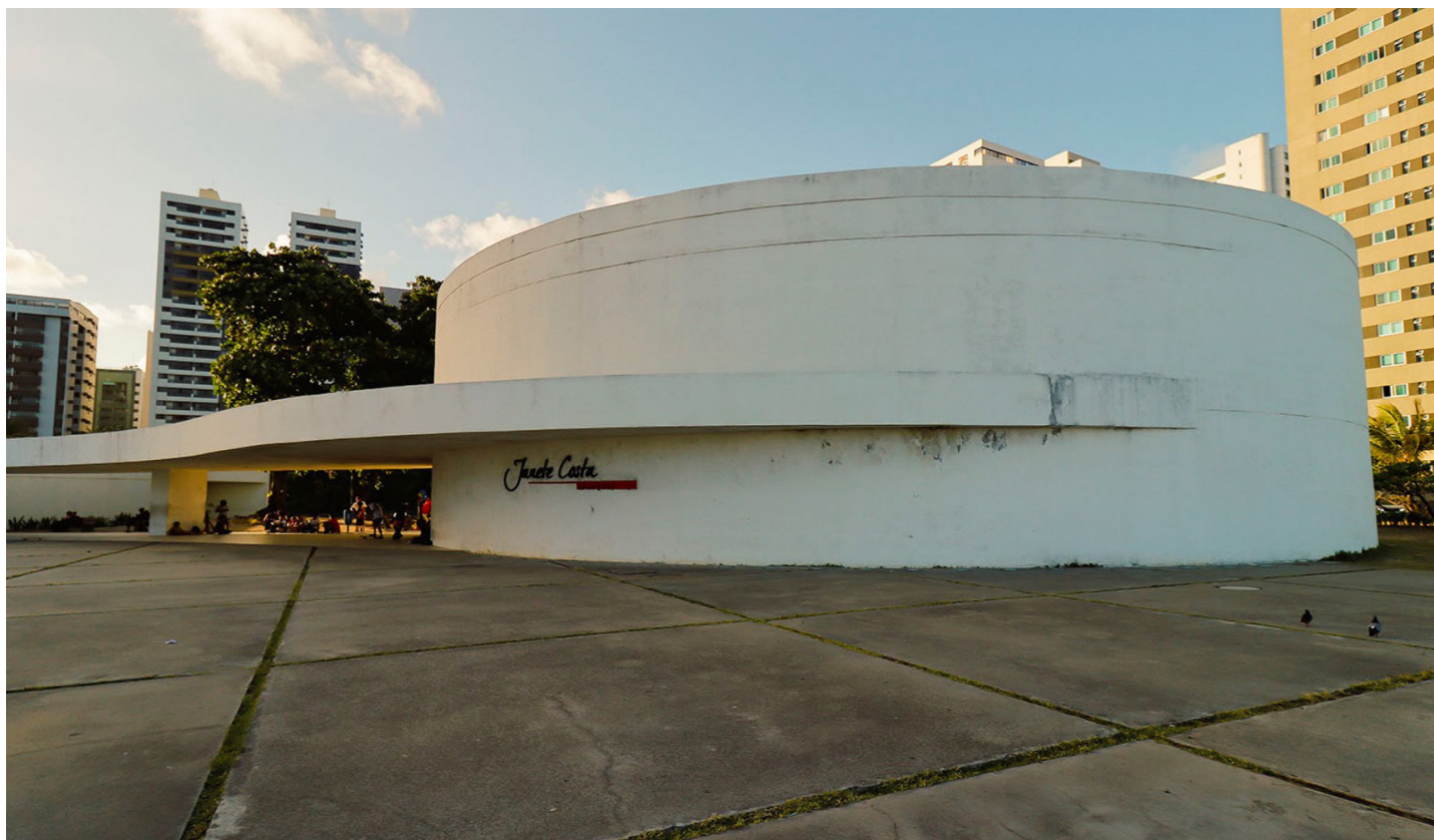
Figura 23 — Foto externa da edificação. Fonte: BNDES.
