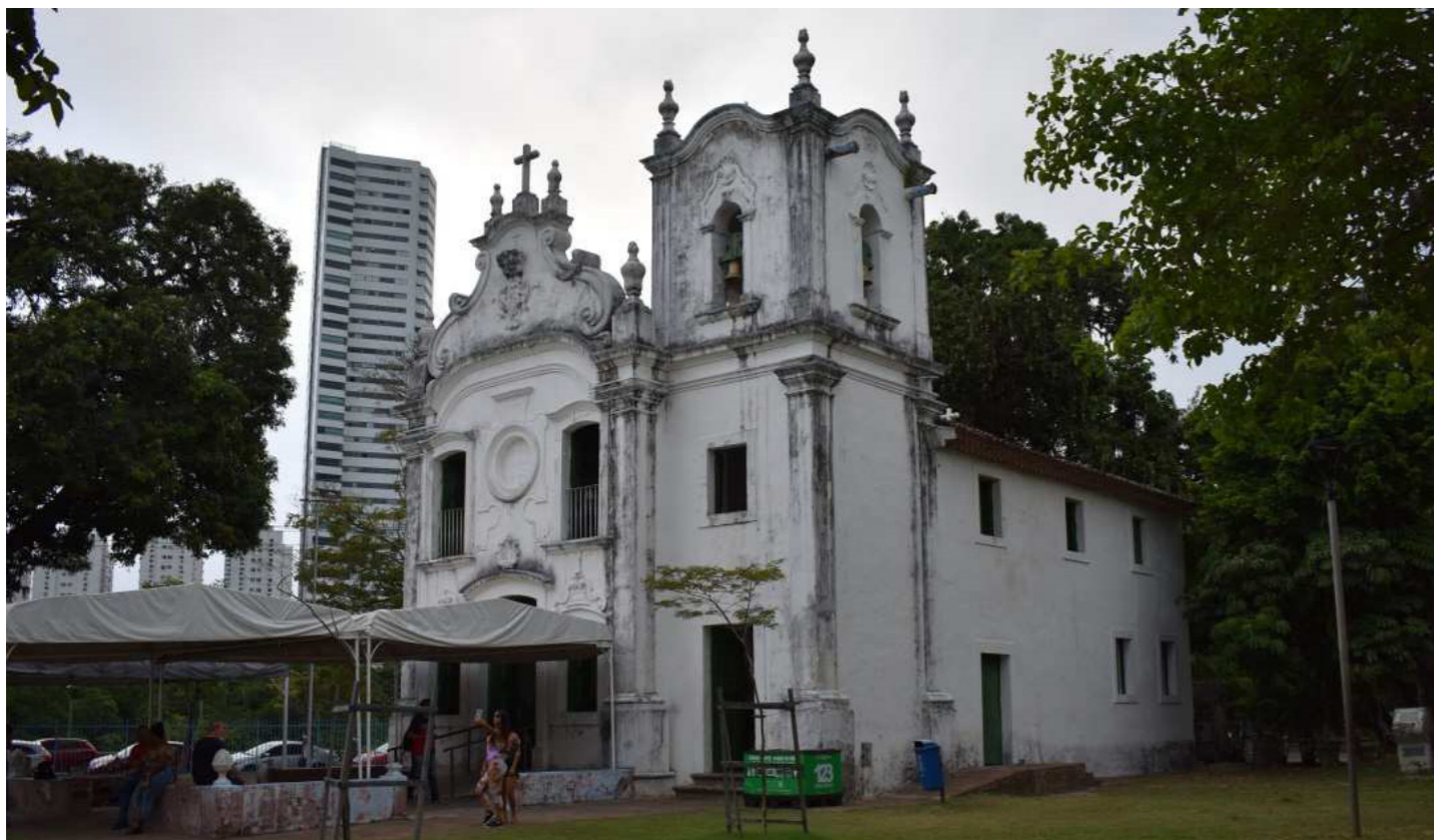
Figura 48 — Foto da edificação. Fonte: BNDES.
