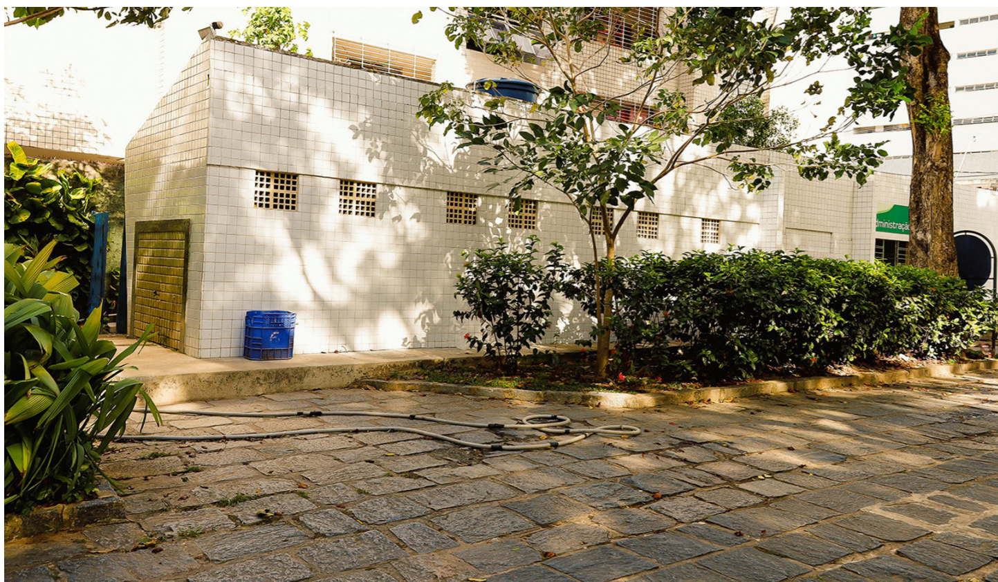
Figura 74 — Foto da edificação. Fonte: BNDES.
