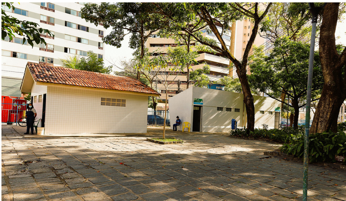
Figura 72 — Foto da edificação. Fonte: BNDES.
