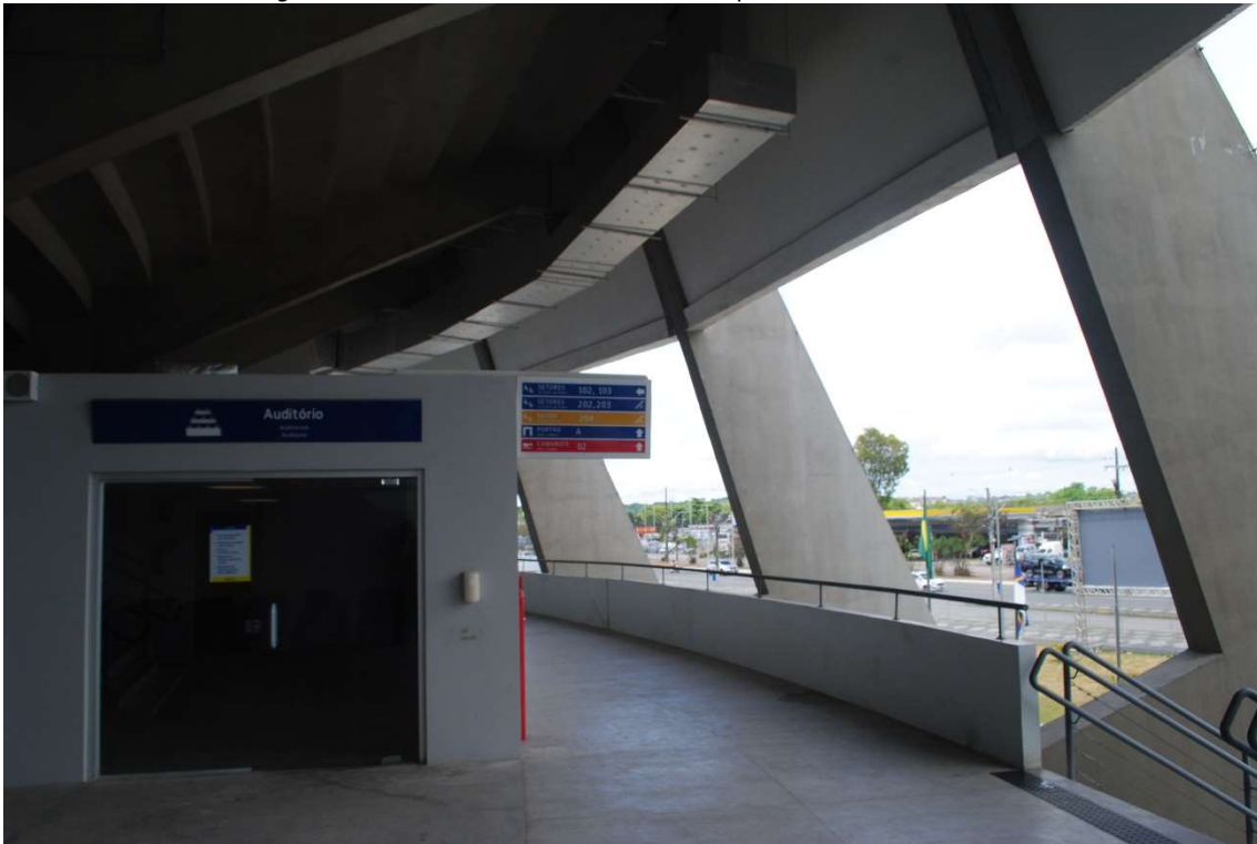
Figura 59 - Entrada de um dos auditórios no pavimento intermediário
