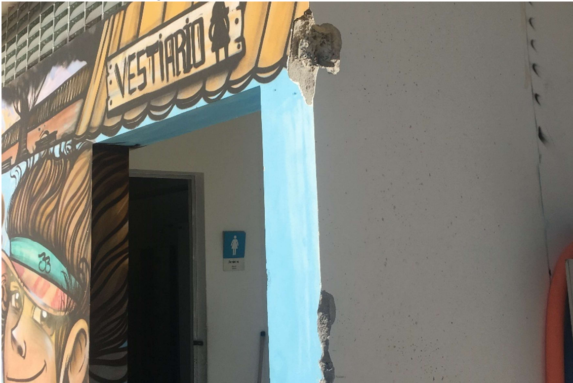
Figura 100 - Acesso aos vestiários do PARQUE AQUÁTICO
