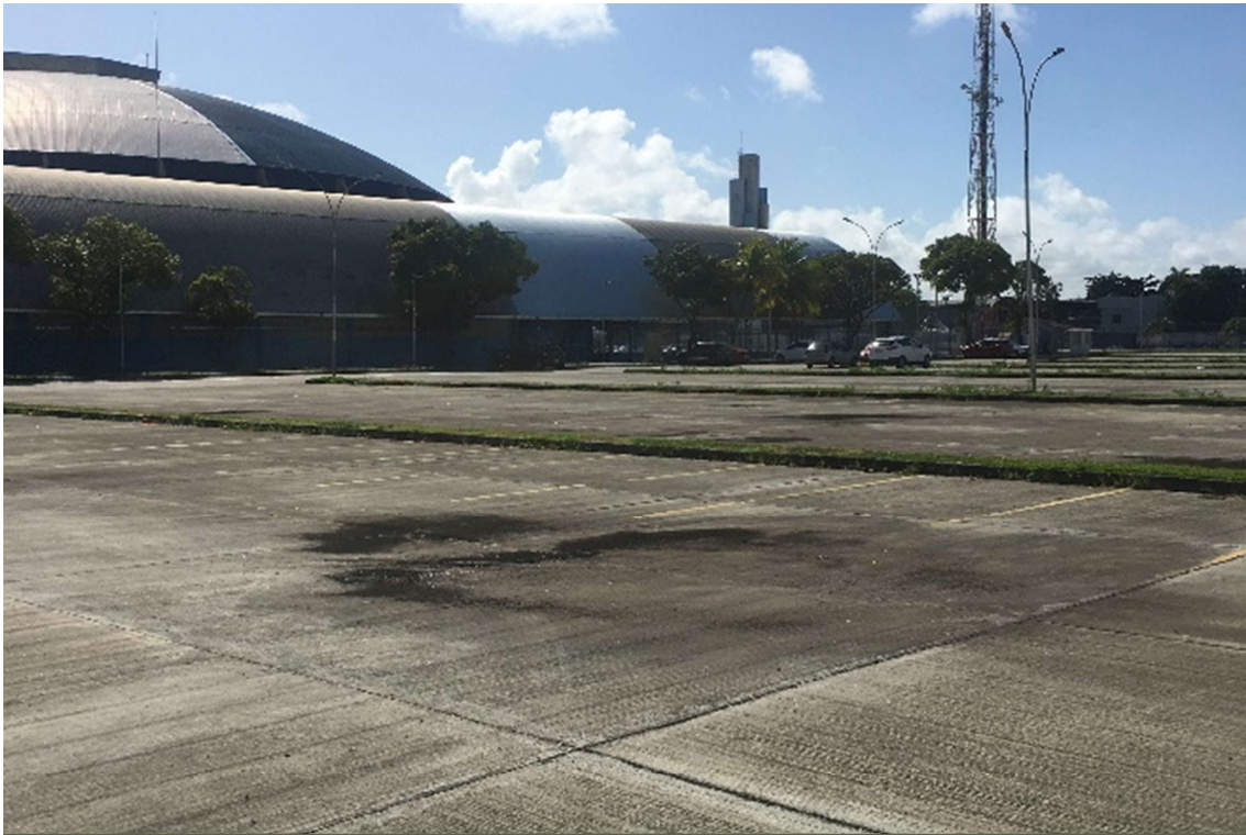
Figura 105 – Visão geral do ESTACIONAMENTO GERAL
