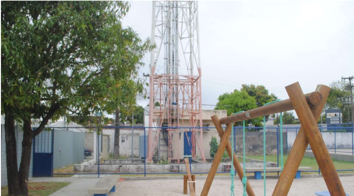
Figura 120 - Área da antena de telefonia e playground
