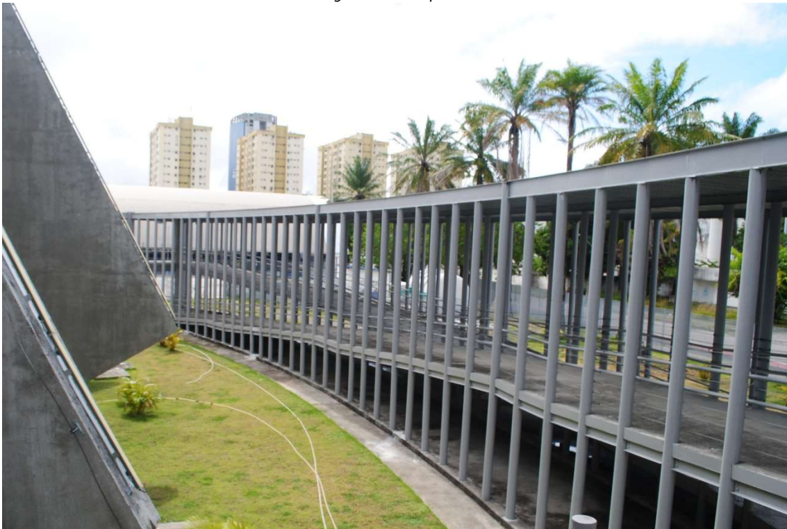
Figura 25 - Rampas de acesso
