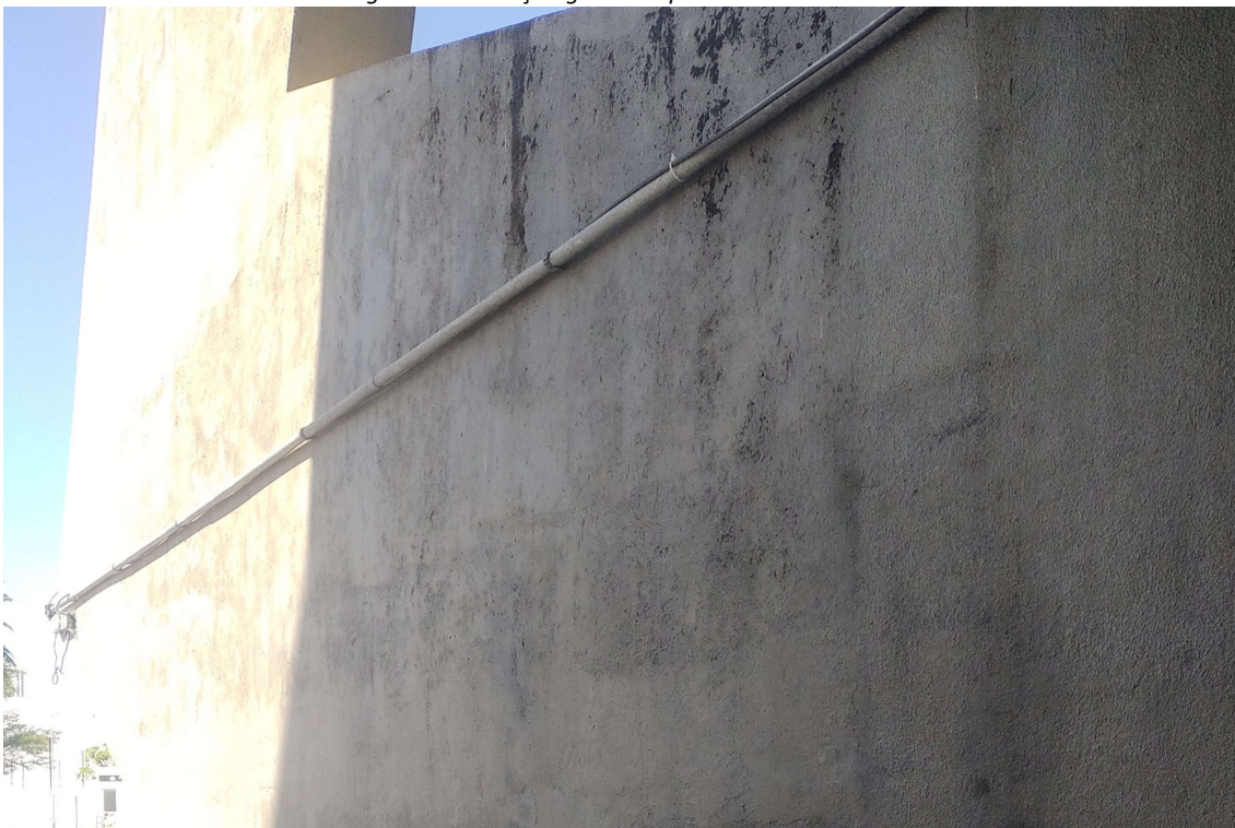
Figura 23 - Situação geral dos pilares da ARENA MULTIUSO
