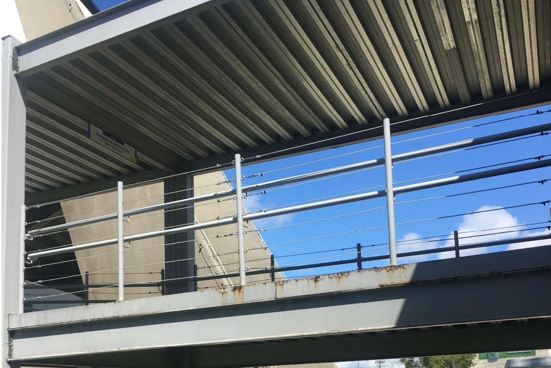
Figura 29 - Laje da rampa de acesso
