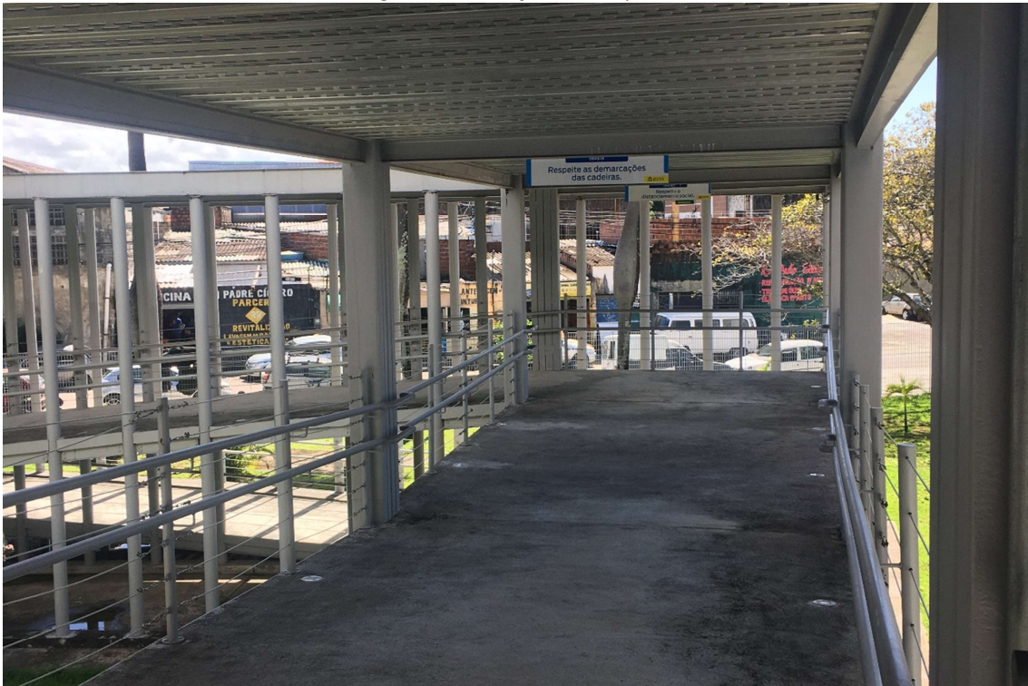
Figura 28 – Condições da rampa de acesso
