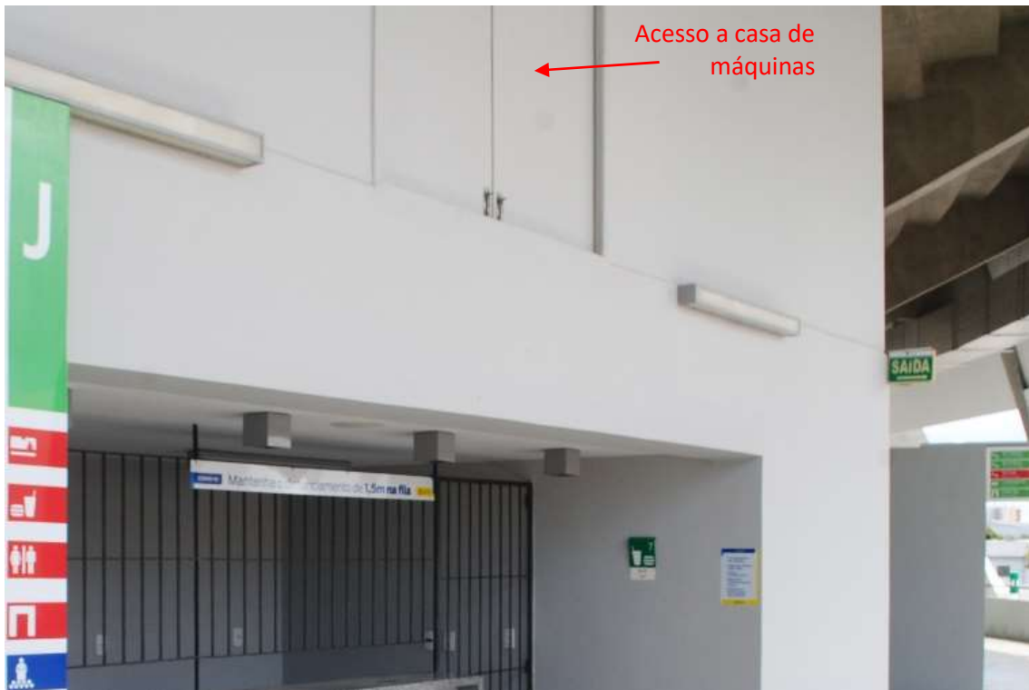
Figura 68 - Acesso a casa de máquinas
