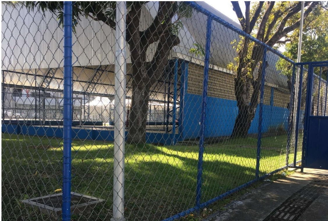
Figura 91 – Alambrado de divisa entre as QUADRAS POLIESPORTIVAS e o ESTACIONAMENTO GERAL
