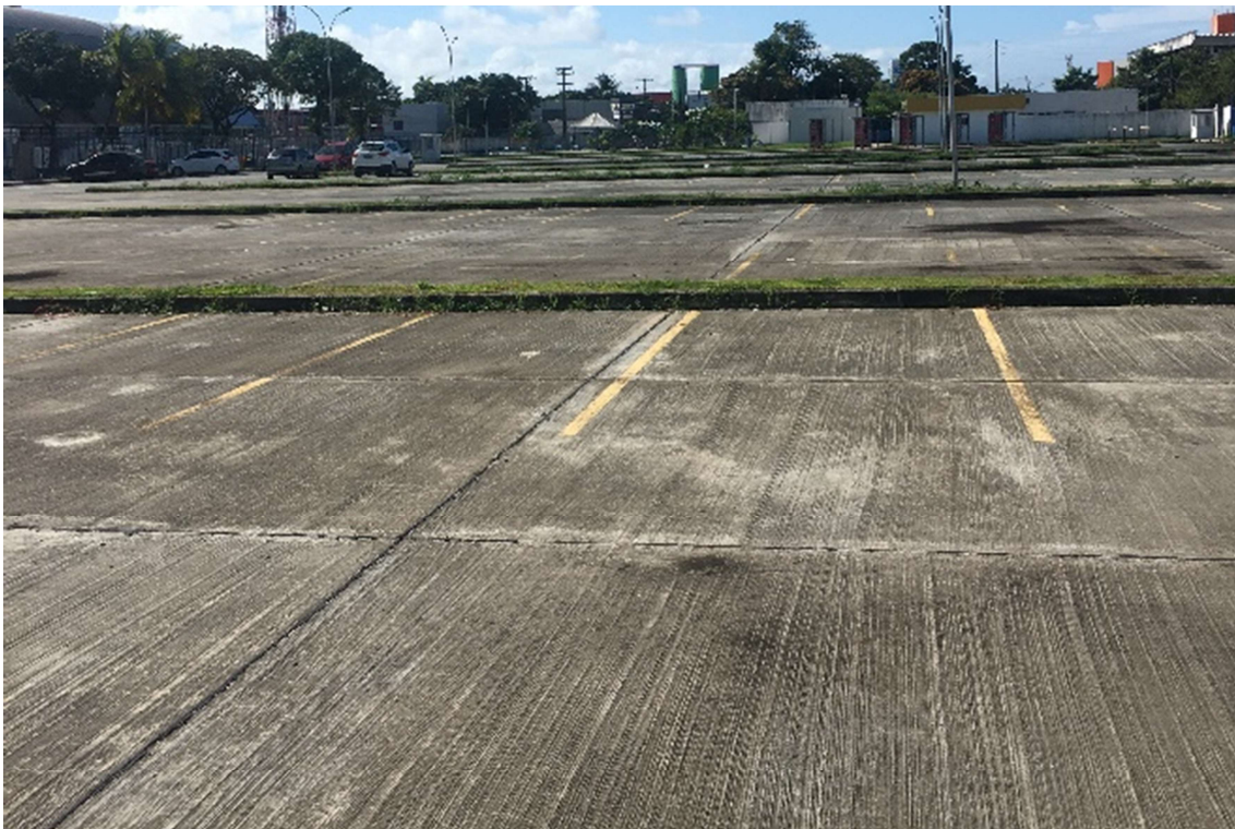
Figura 108 – Situação geral do piso do ESTACIONAMENTO GERAL
