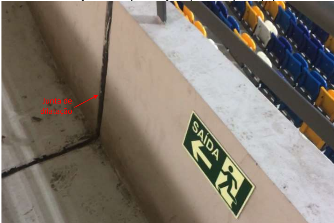
Figura 80 - Sinalização de emergência e junta de dilatação da edificação
