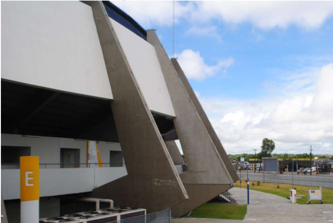
Figura 18 – Fachada da ARENA MULTIUSO
