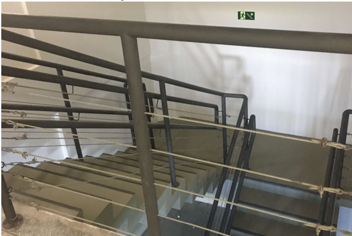
Figura 63 - Escada de acesso exclusivo à tribuna
