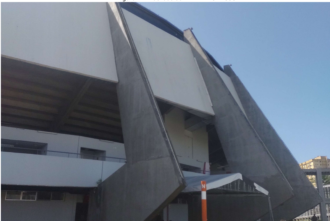
Figura 21 - Fachada da ARENA MULTIUSO
