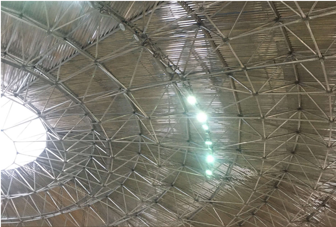
Figura 24 - Estrutura de suporte da cobertura e sistema de iluminação da ARENA MULTIUSO
