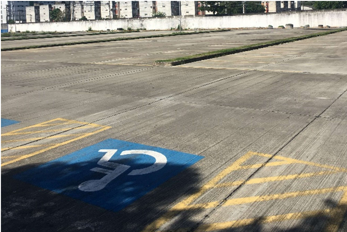
Figura 106 – Vagas destinadas a pessoas com mobilidade reduzida
