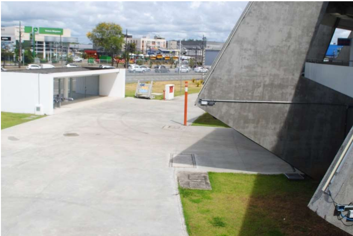
Figura 3 - Portão de acesso e parte do PASSEIO E JARDIM
