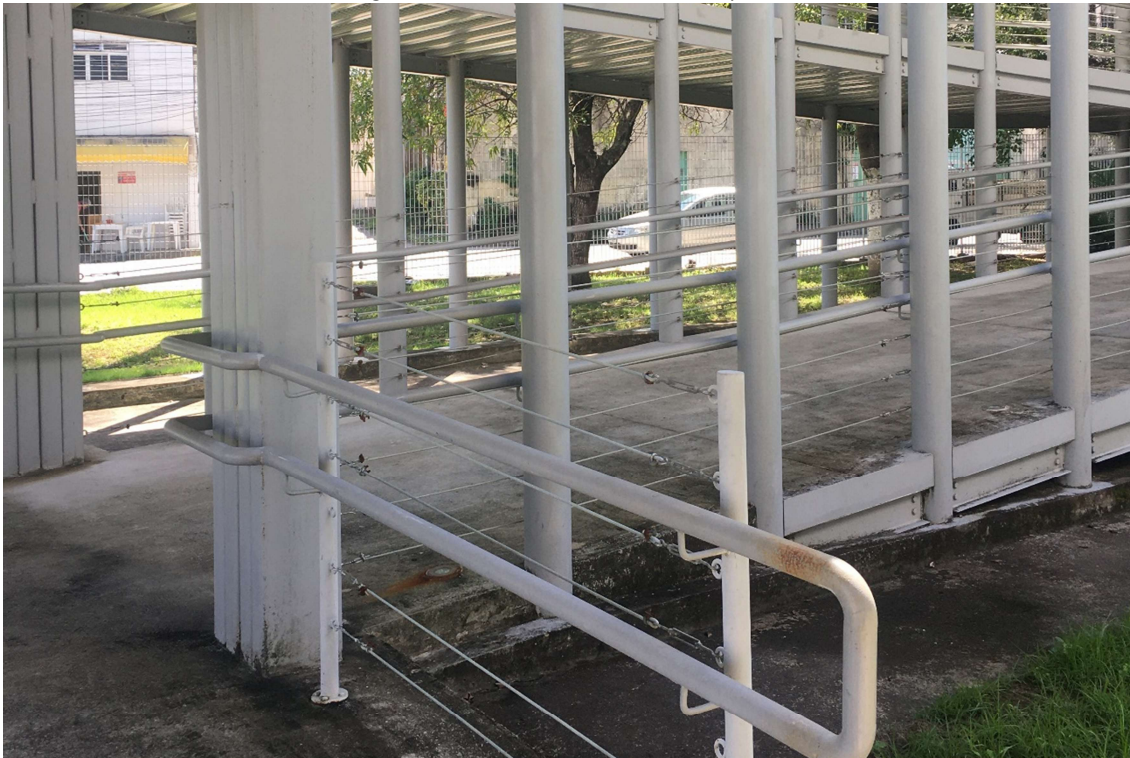
Figura 26 - Corrimão na subida da rampa de acesso
