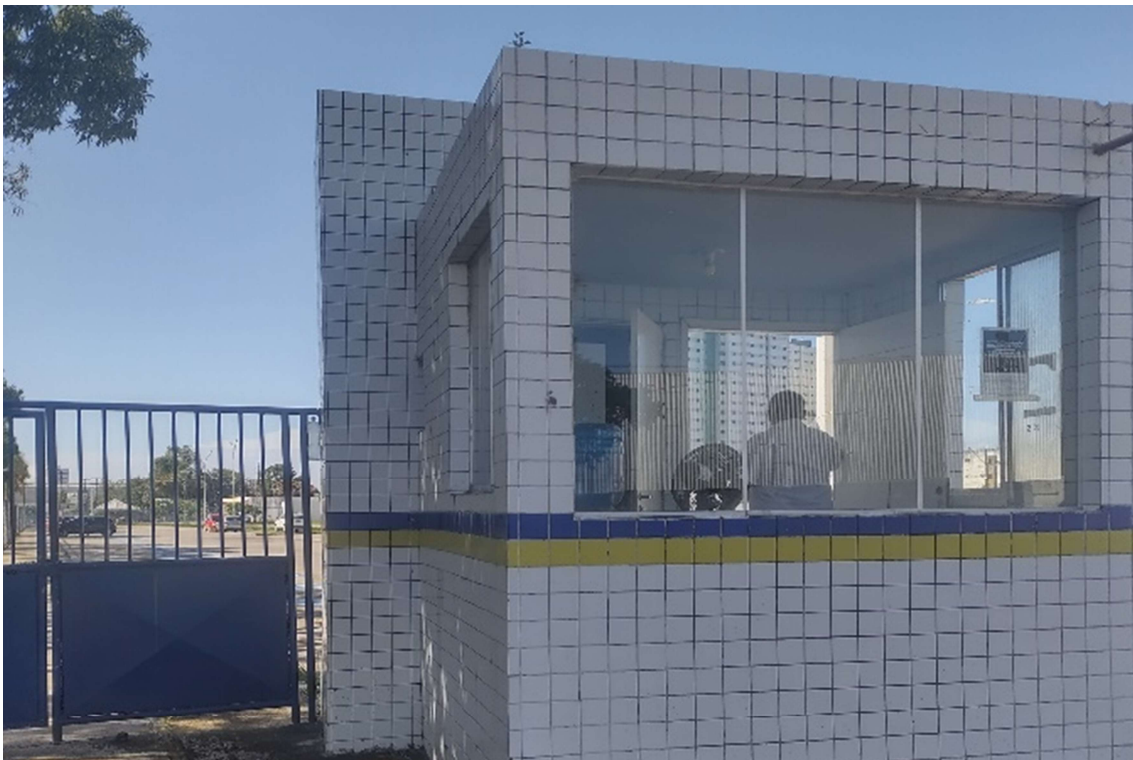
Figura 104 – Guarita de Acesso ao ESTACIONAMENTO GERAL
