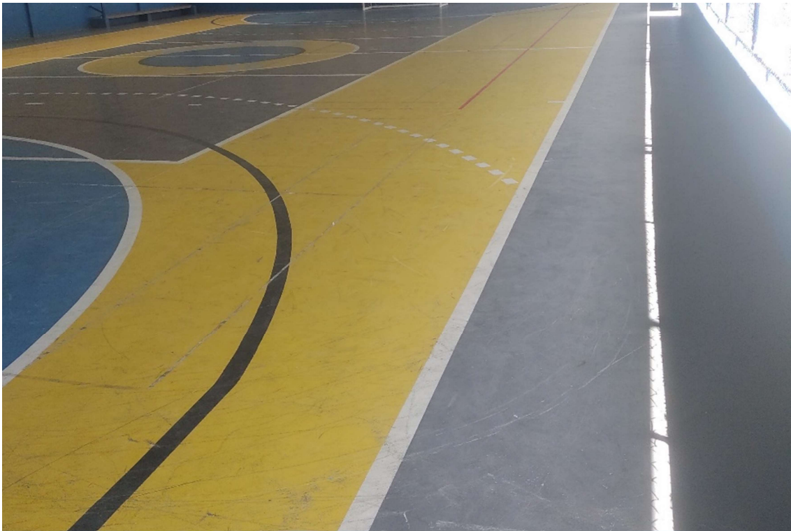
Figura 85 – Pisos da QUADRAS POLIESPORTIVAS com marcações
