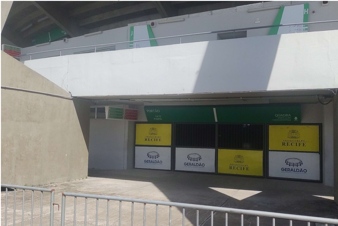
Figura 36 - Portão de acesso exclusivo à tribuna
