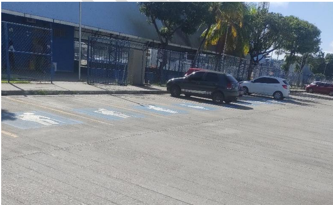
Figura 110 – Portão de acesso às QUADRAS POLIESPORTIVAS
