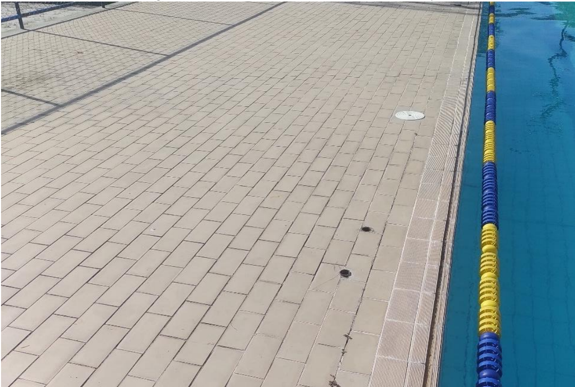
Figura 96 - Piso da área do PARQUE AQUÁTICO e raia da piscina
