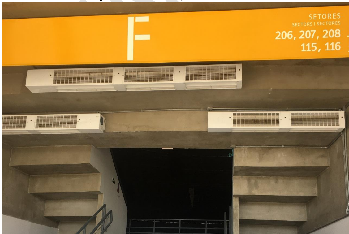
Figura 67 - Cortinas de ar do pavimento intermediário
