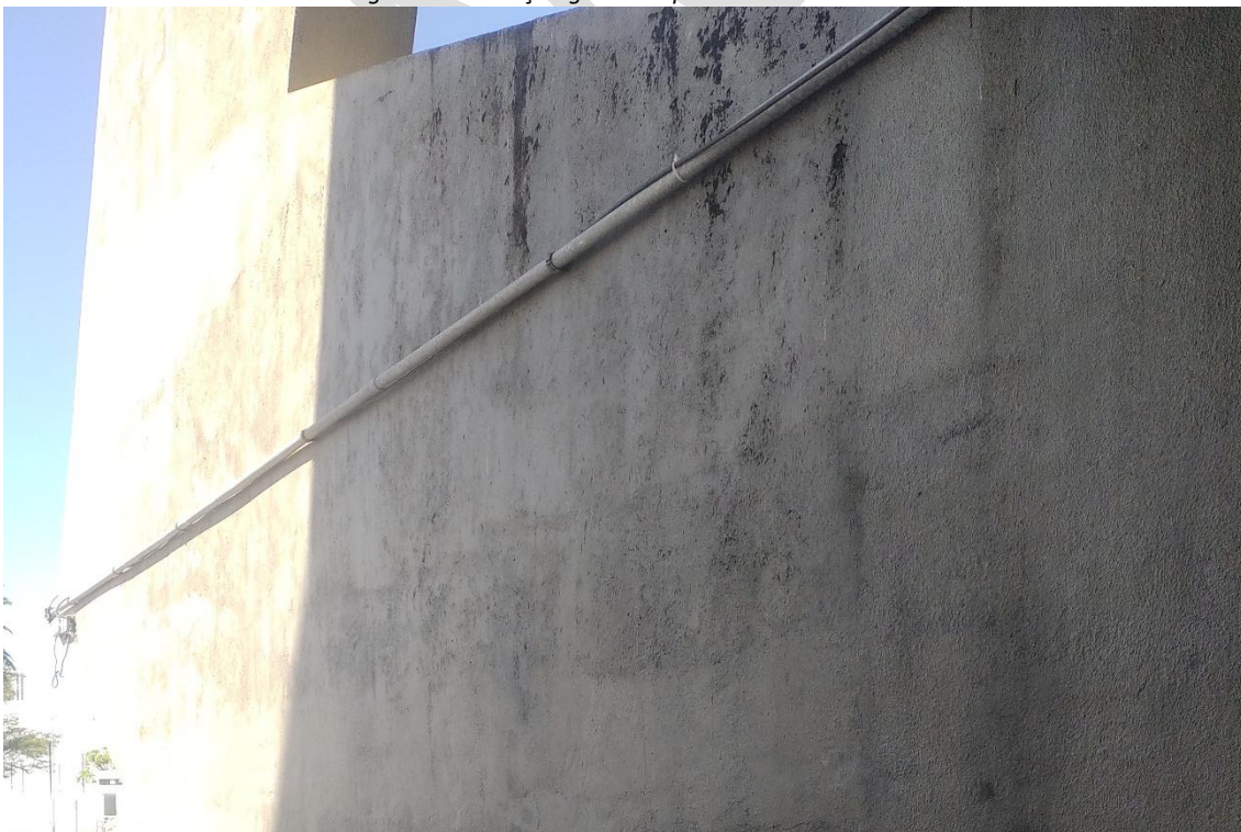
Figura 23 - Situação geral dos pilares da ARENA MULTIUSO
