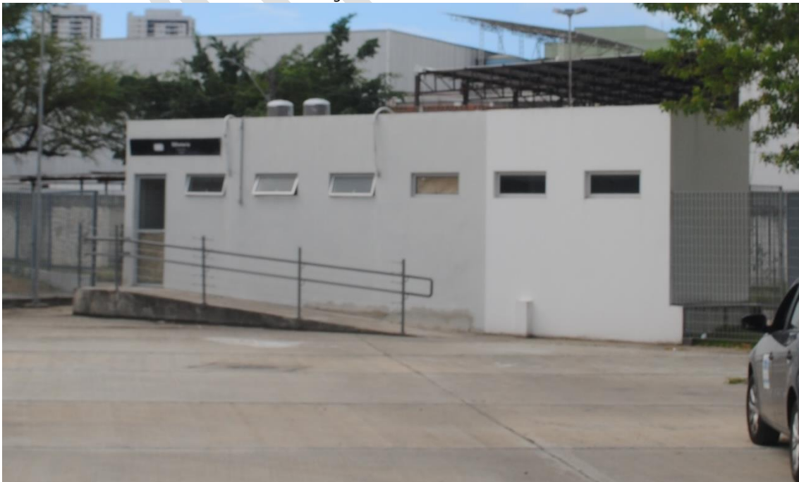
Figura 119 - Acesso à bilheteria
