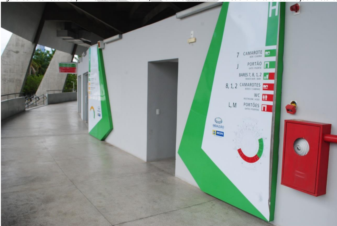
Figura 55 - Corredor do pavimento intermediário, hidrante e sistema de direcionamento e localização existente
