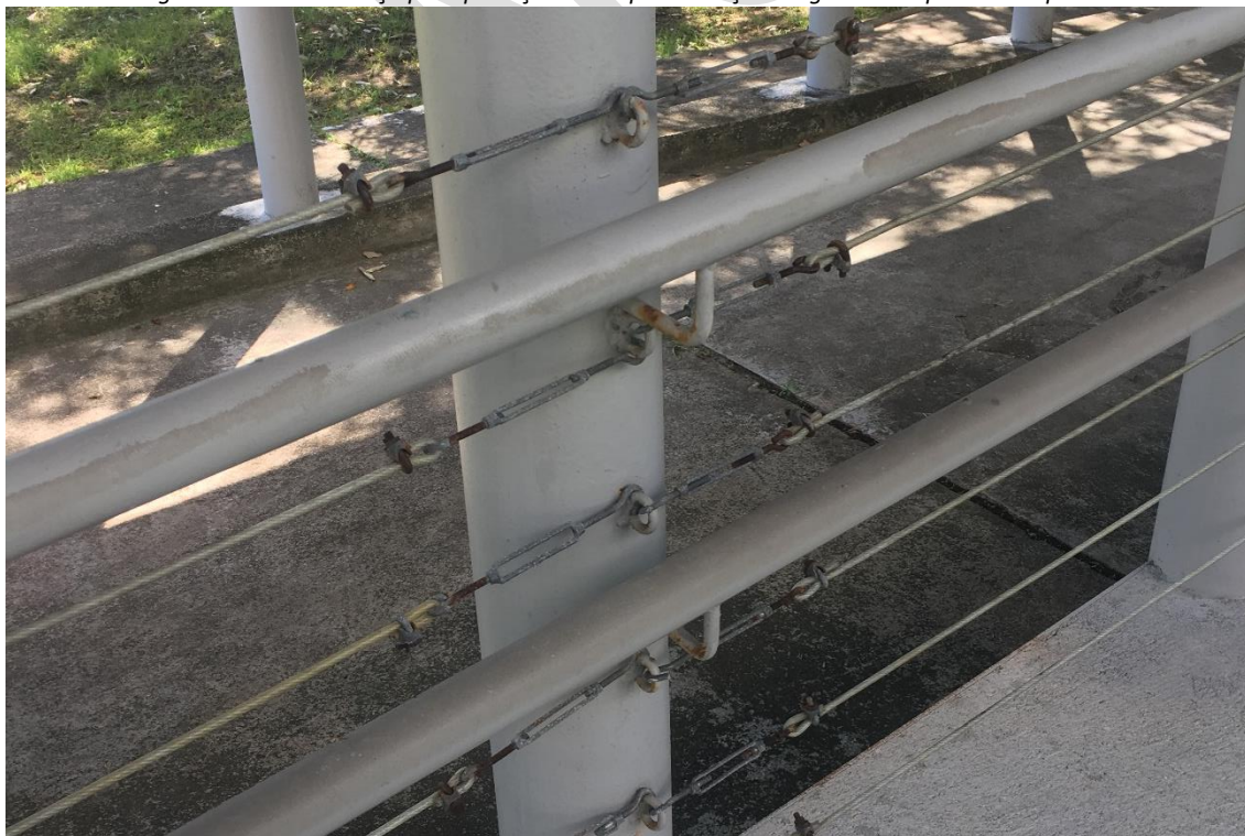
Figura 27 - Cabos de aço para proteção e complementação do guarda corpo das rampas de acesso
