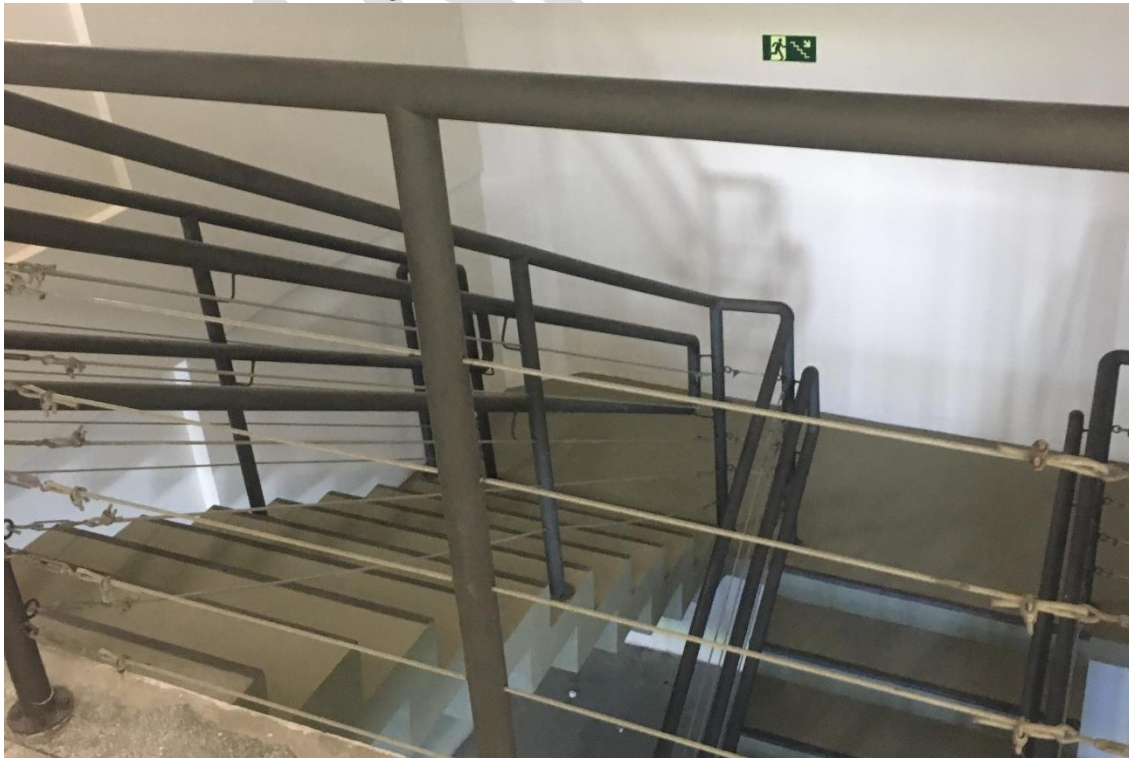
Figura 63 - Escada de acesso exclusivo à tribuna
