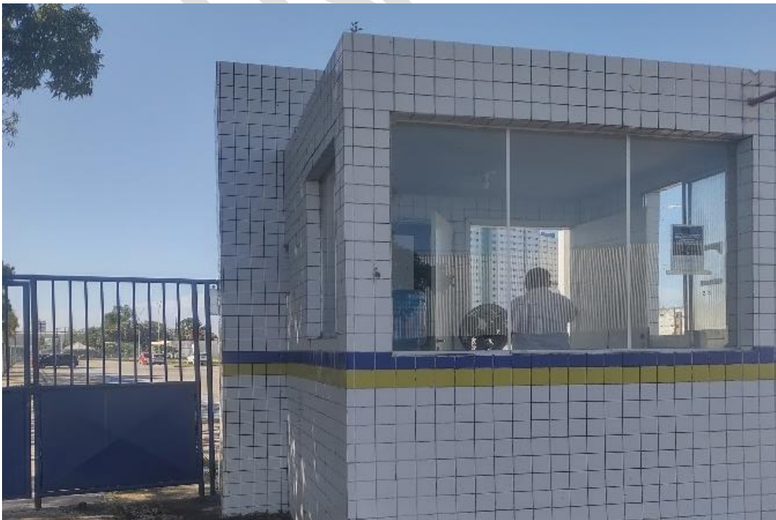
Figura 104 – Guarita de Acesso ao ESTACIONAMENTO GERAL
