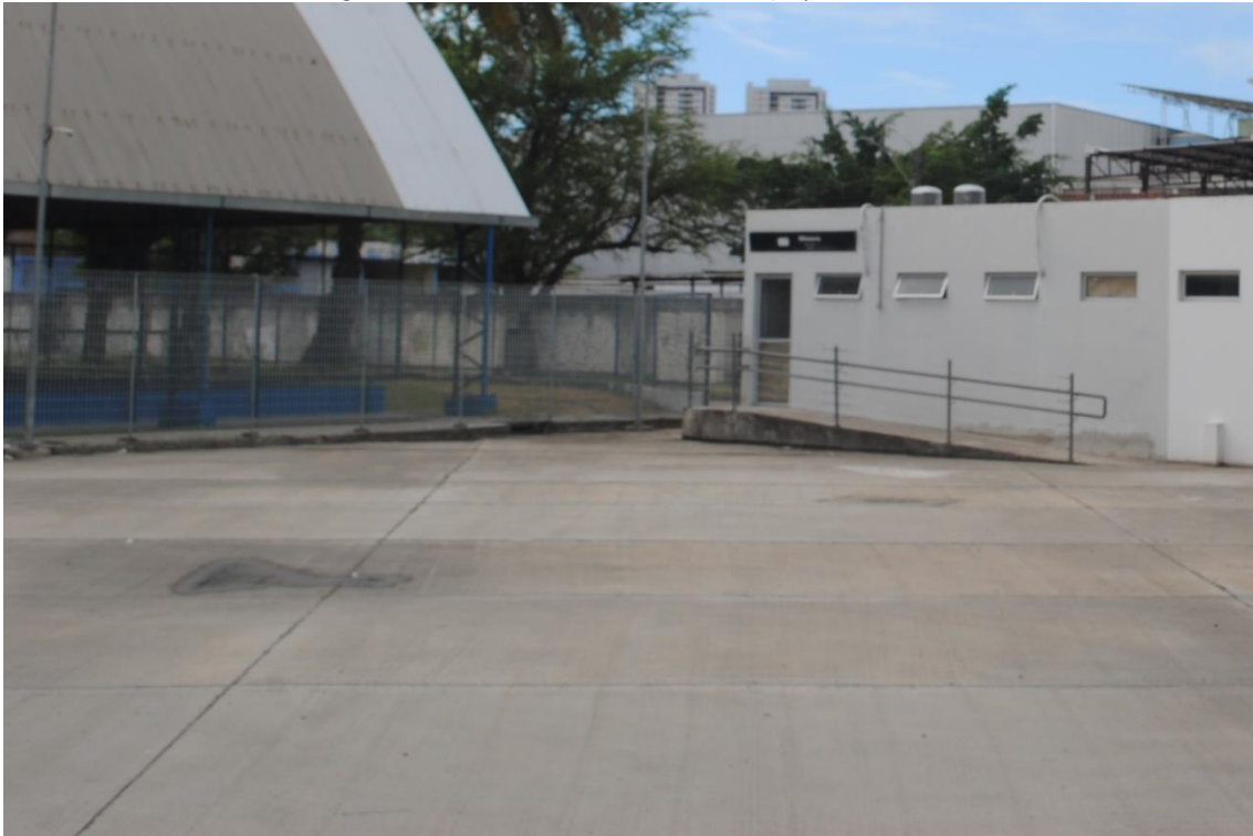
Figura 116 - ESTACIONAMENTO DE SERVIÇO próximo à bilheteria
