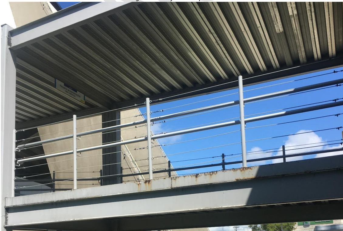
Figura 29 - Laje da rampa de acesso
