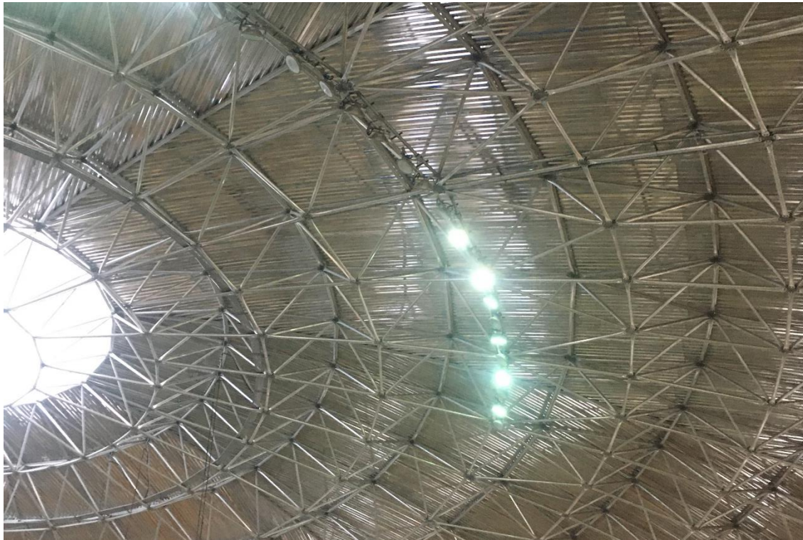
Figura 24 - Estrutura de suporte da cobertura e sistema de iluminação da ARENA MULTIUSO
