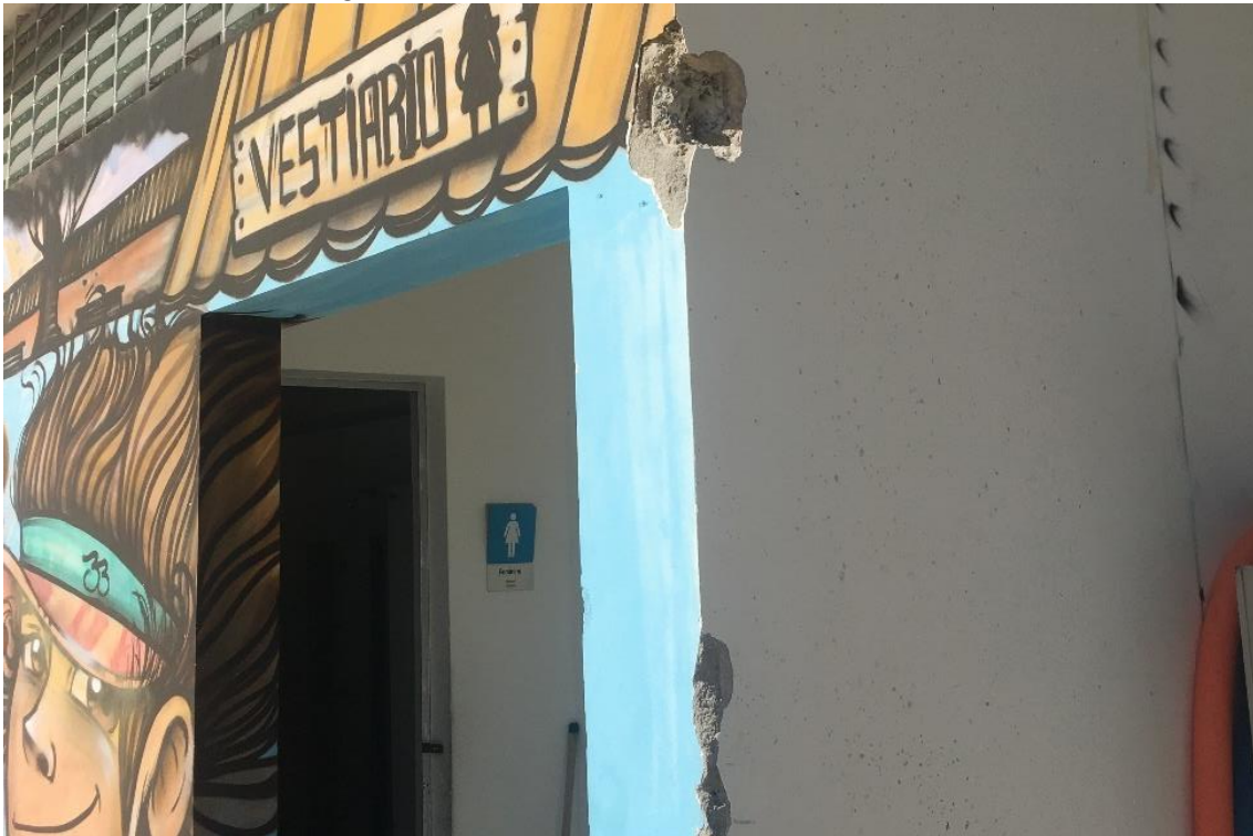
Figura 100 - Acesso aos vestiários do PARQUE AQUÁTICO
