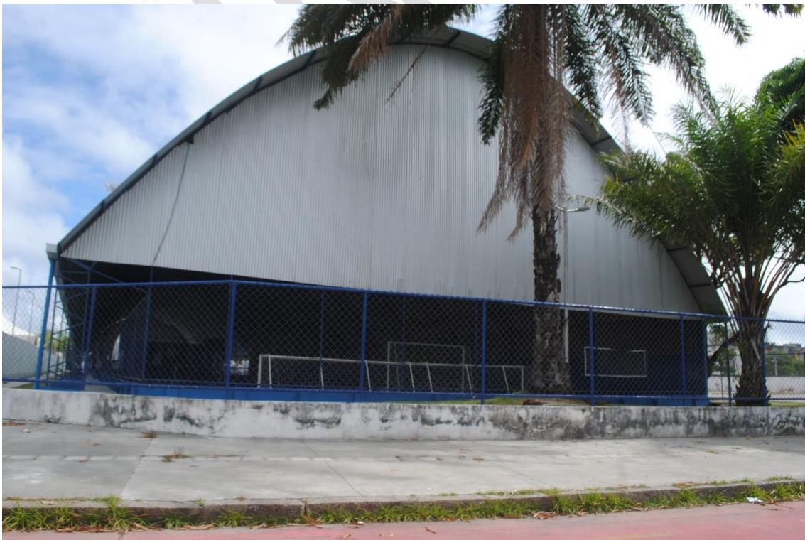
Figura 84 – Visão externa das QUADRAS POLIESPORTIVAS e alambrado
