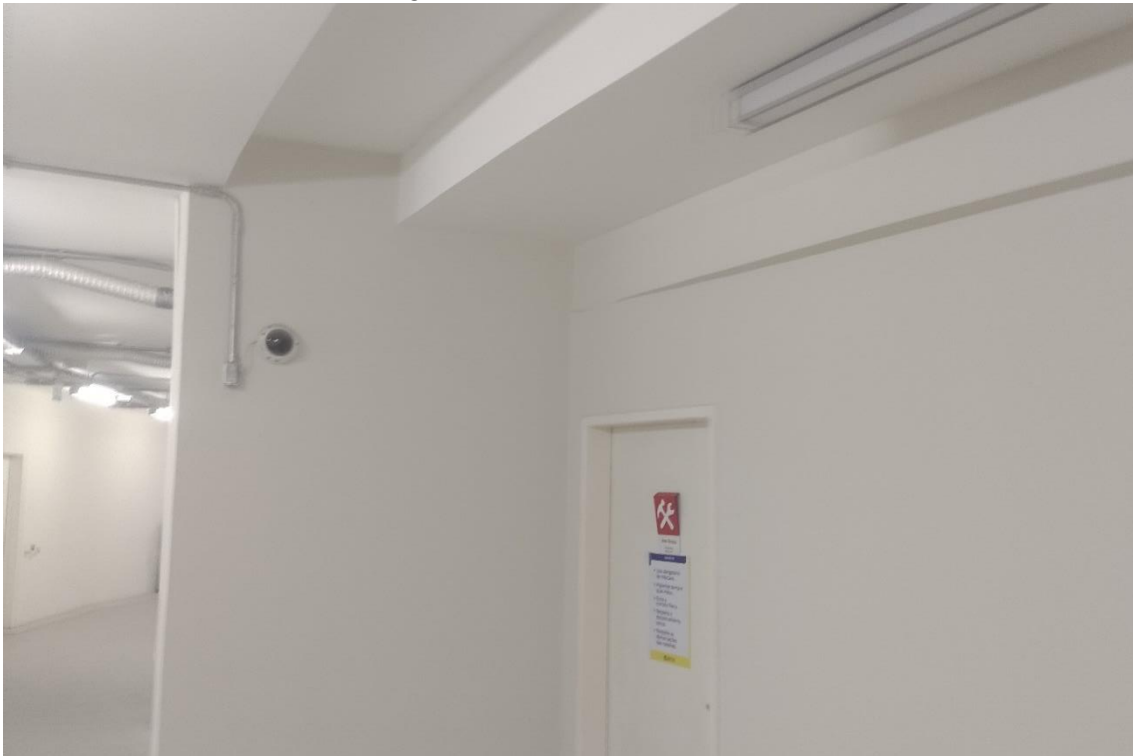
Figura 38 - Corredor entre as salas no térreo
