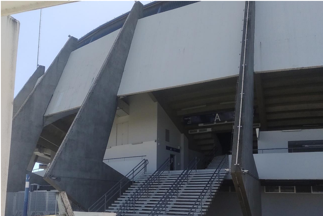
Figura 22 - Escada de acesso ao pavimento intermediário da ARENA MULTIUSO
