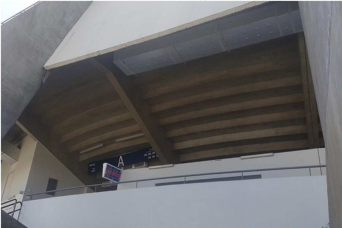
Figura 54 - Visão externa do corredor do piso intermediário
