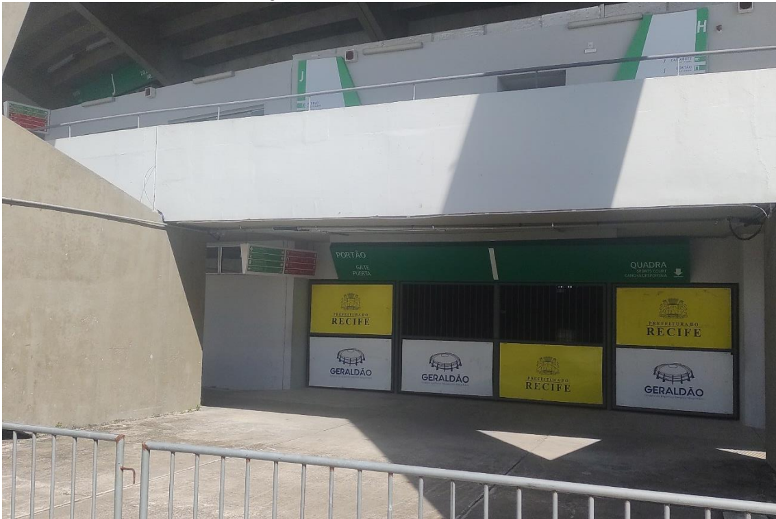
Figura 36 - Portão de acesso exclusivo à tribuna
