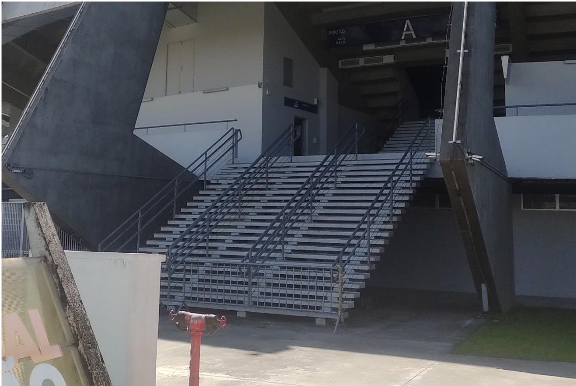
Figura 30 - Escadaria de acesso a ARENA MULTIUSO
