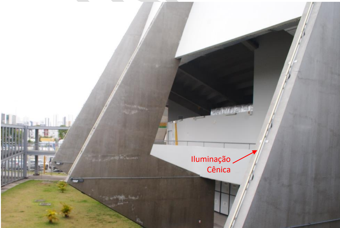
Figura 19 – Fachada, pilares e iluminação cênica da ARENA MULTIUSO
