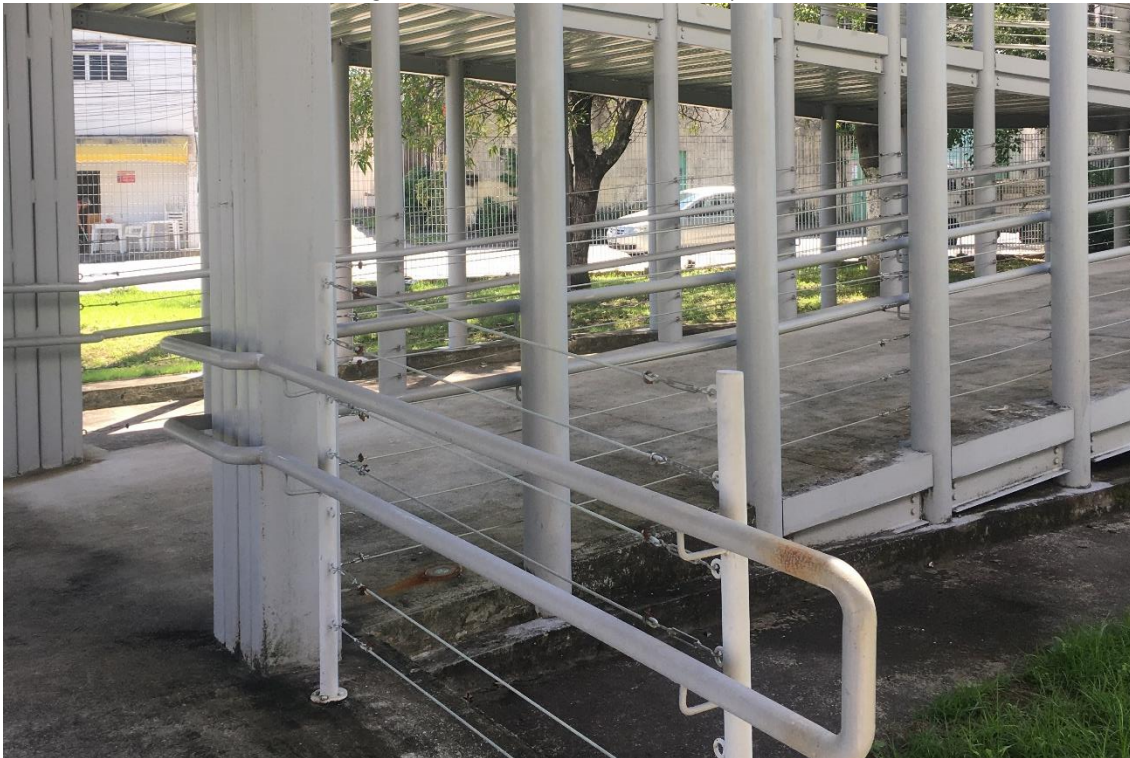
Figura 26 - Corrimão na subida da rampa de acesso
