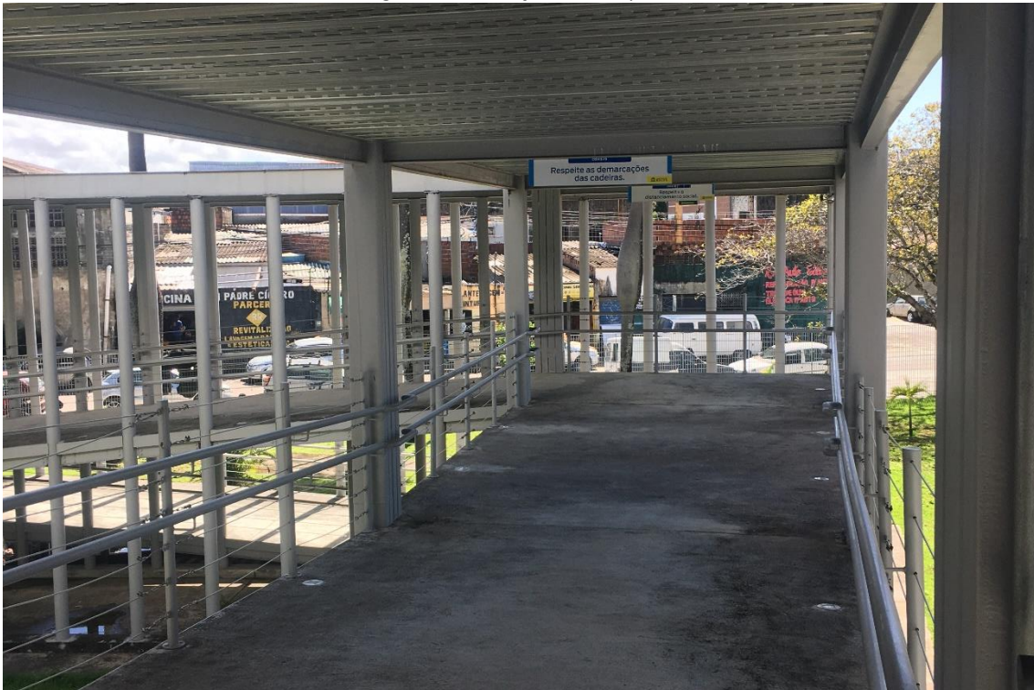
Figura 28 – Condições da rampa de acesso
