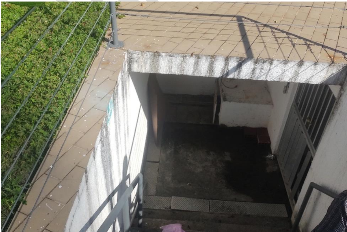
Figura 97 - Acesso da casa de bombas e filtros das piscinas
