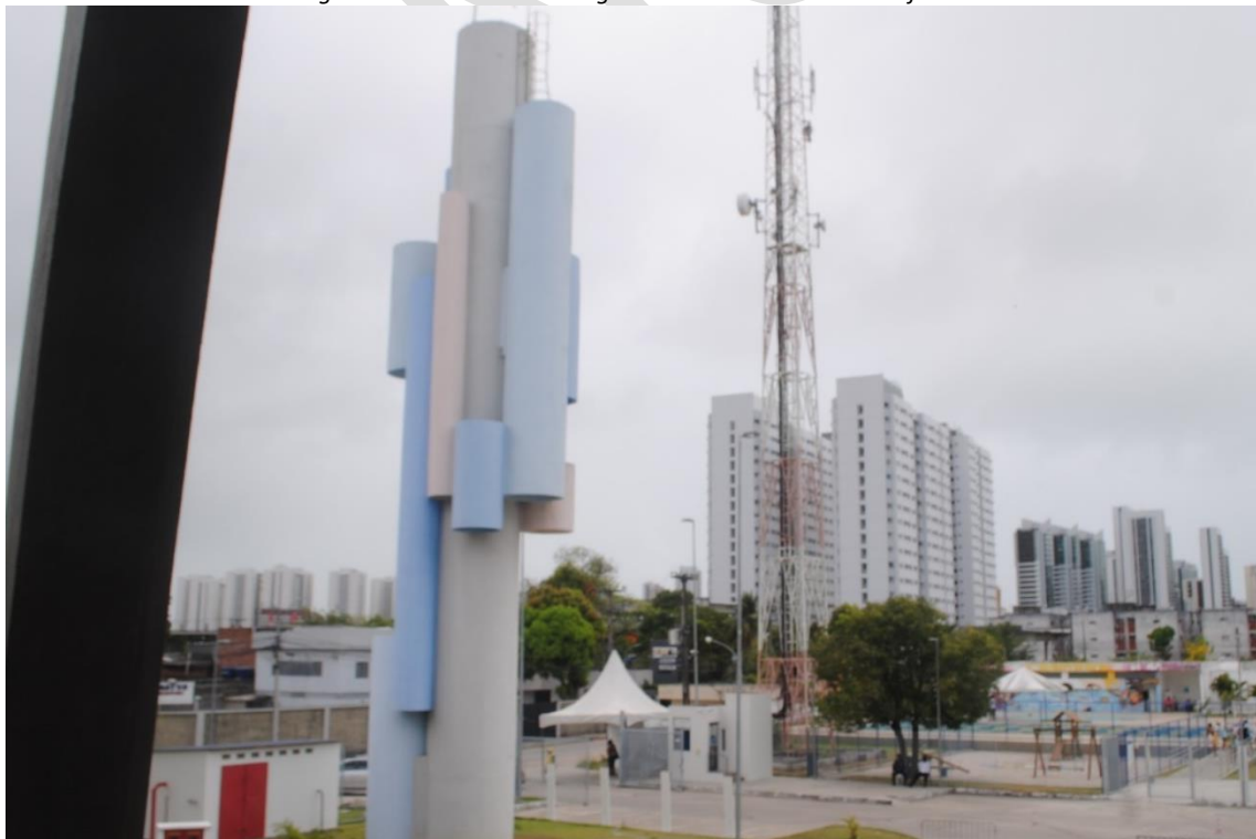
Figura 6 - Reservatório de água e torre de antena de telefonia
