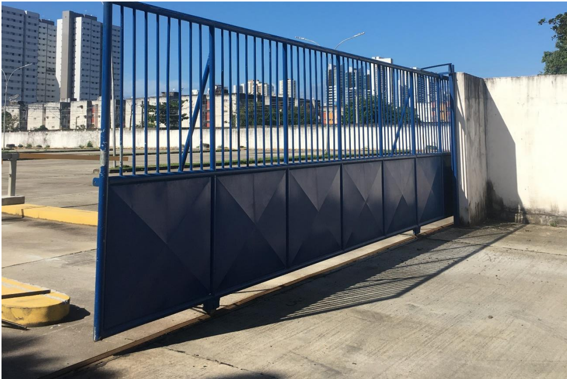
Figura 103 – Portão de Acesso ao ESTACIONAMENTO GERAL
