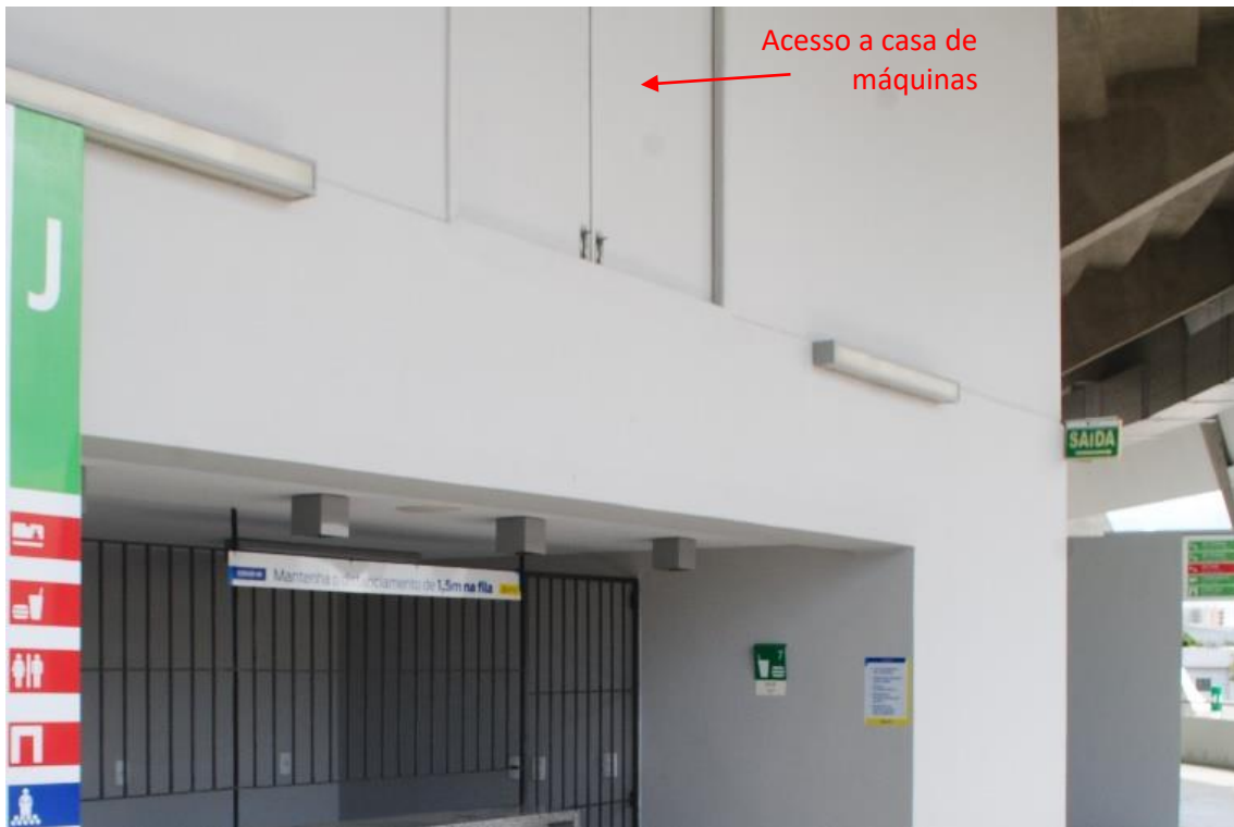
Figura 68 - Acesso a casa de máquinas
