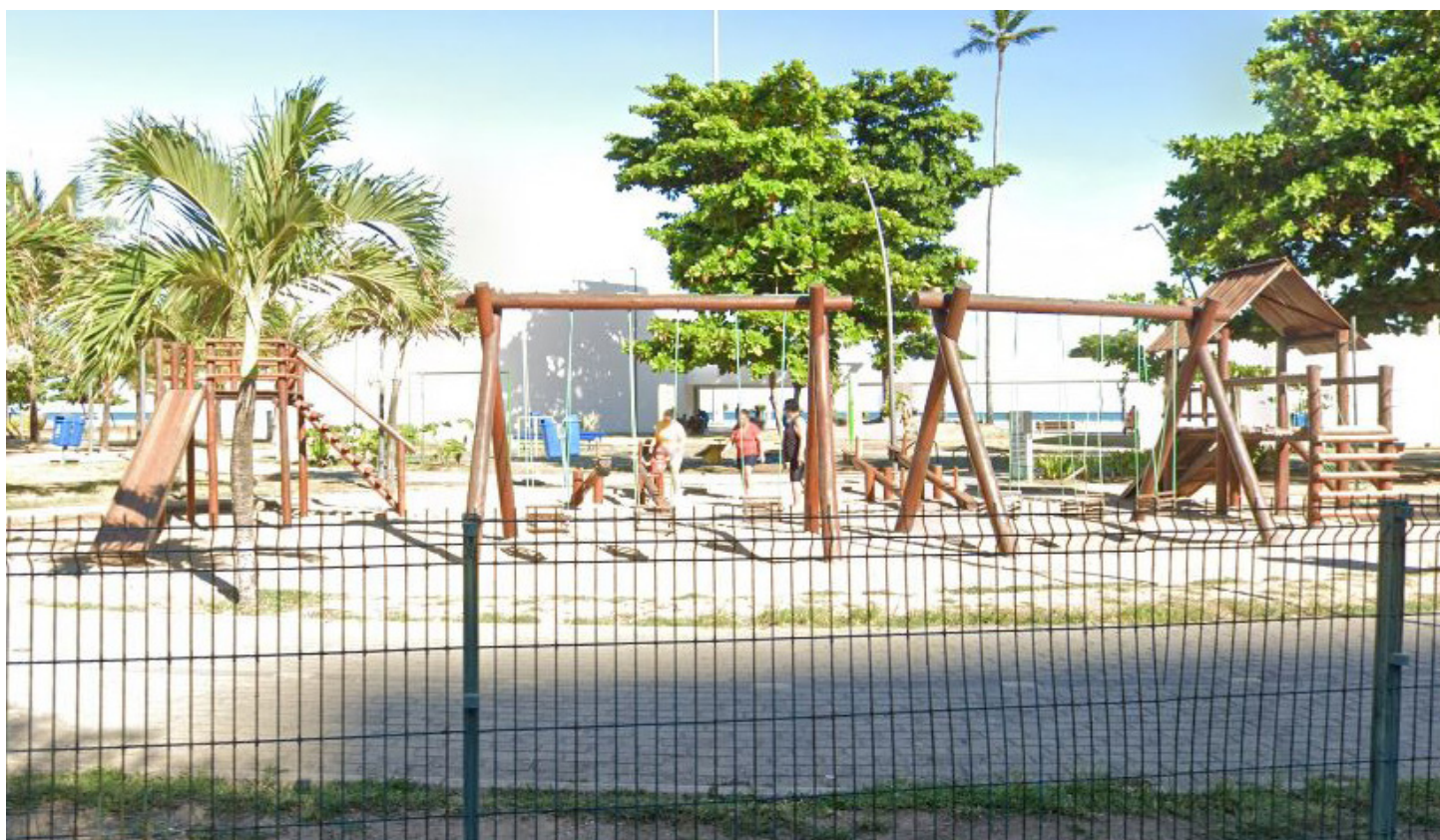
Figura 37 — Foto da estrutura. Fonte: google street view.
