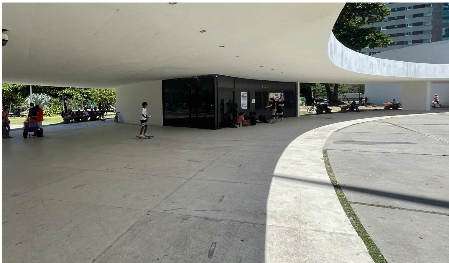
Figura 25 — Foto da edificação. Fonte: visita técnica feita pela equipe em janeiro de 2022.
