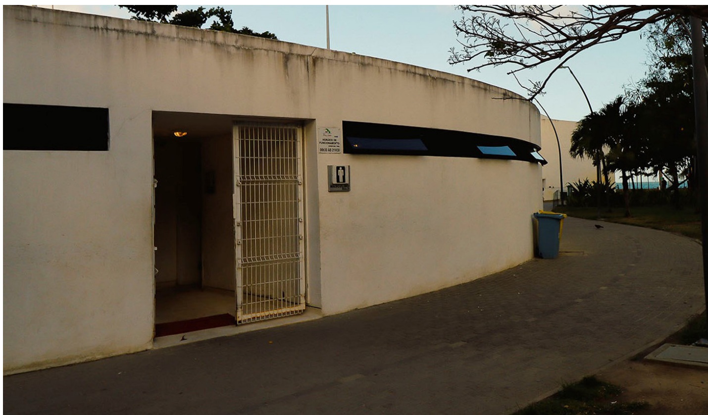
Figura 43 — Foto da estrutura. Fonte: BNDES.
