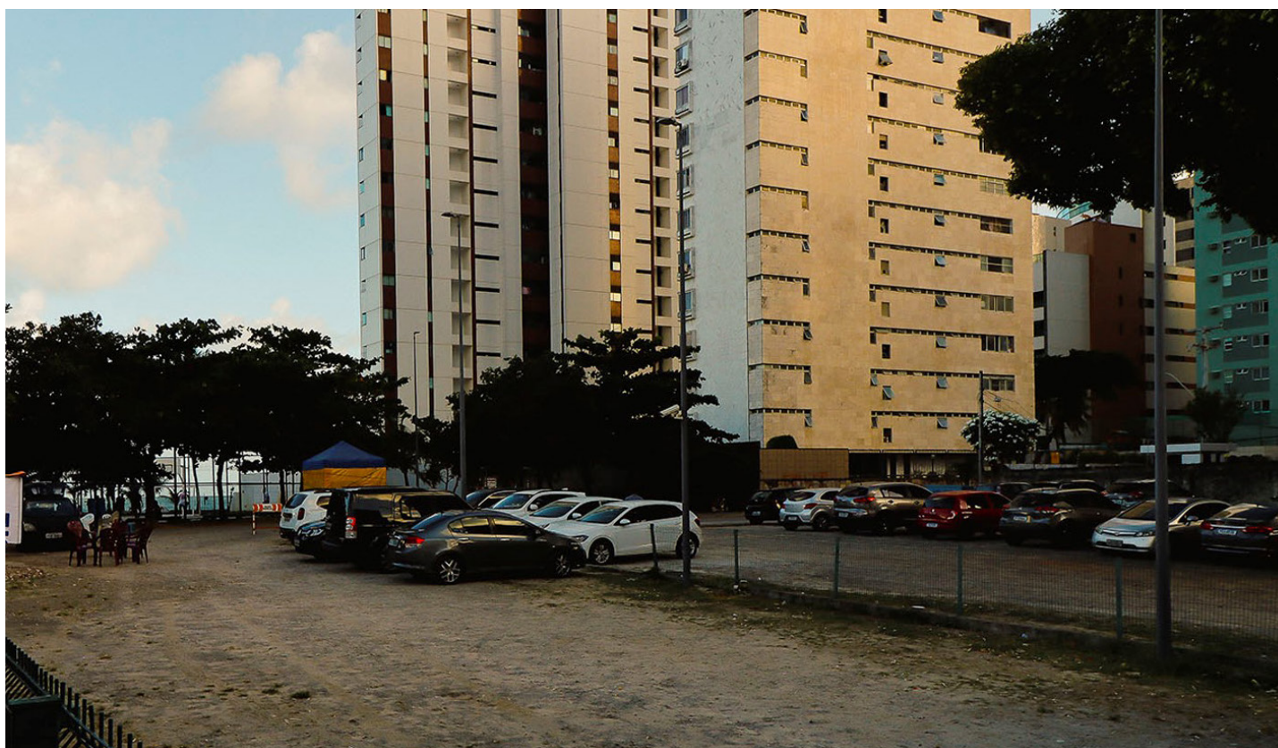
Figura 47 — Foto da estrutura. Fonte: BNDES.
