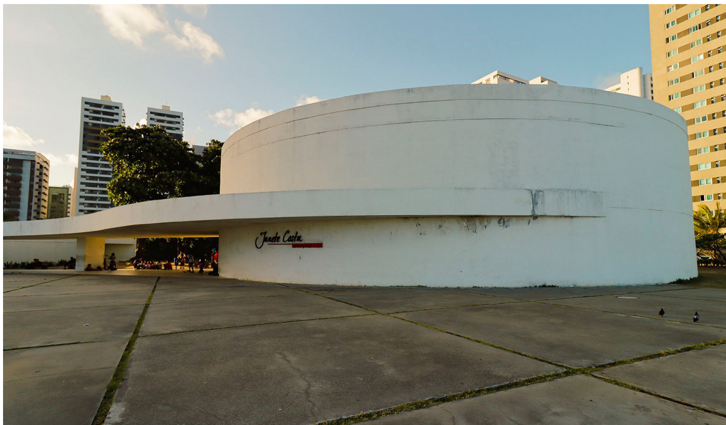
Figura 23 — Foto externa da edificação. Fonte: BNDES.
