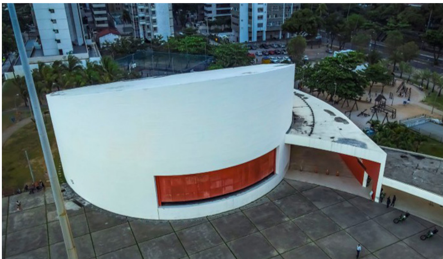
Figura 21 — Foto externa da edificação. Fonte: BNDES.
