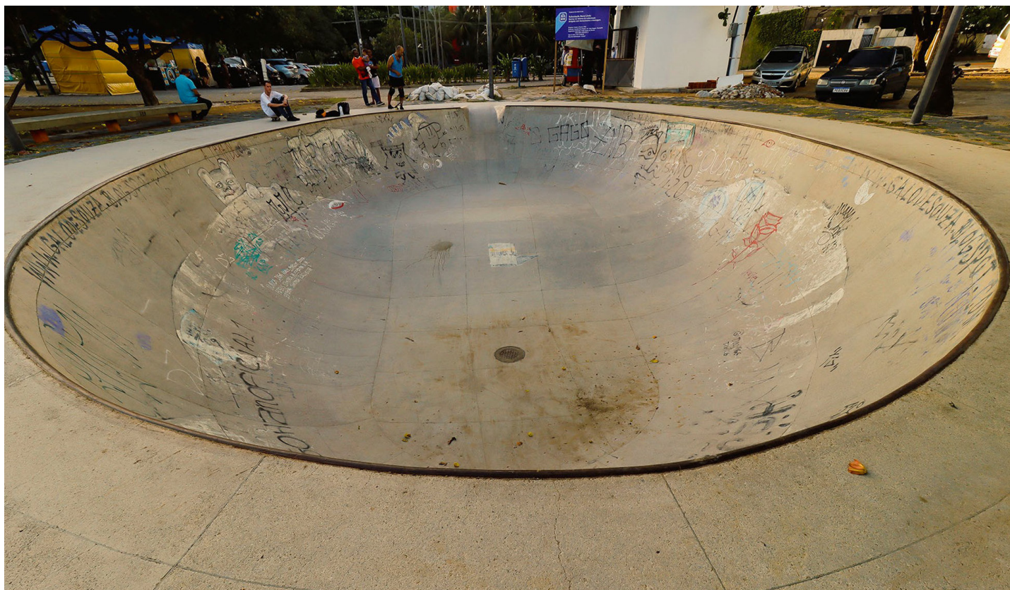
Figura 33 — Foto da estrutura. Fonte: BNDES.
