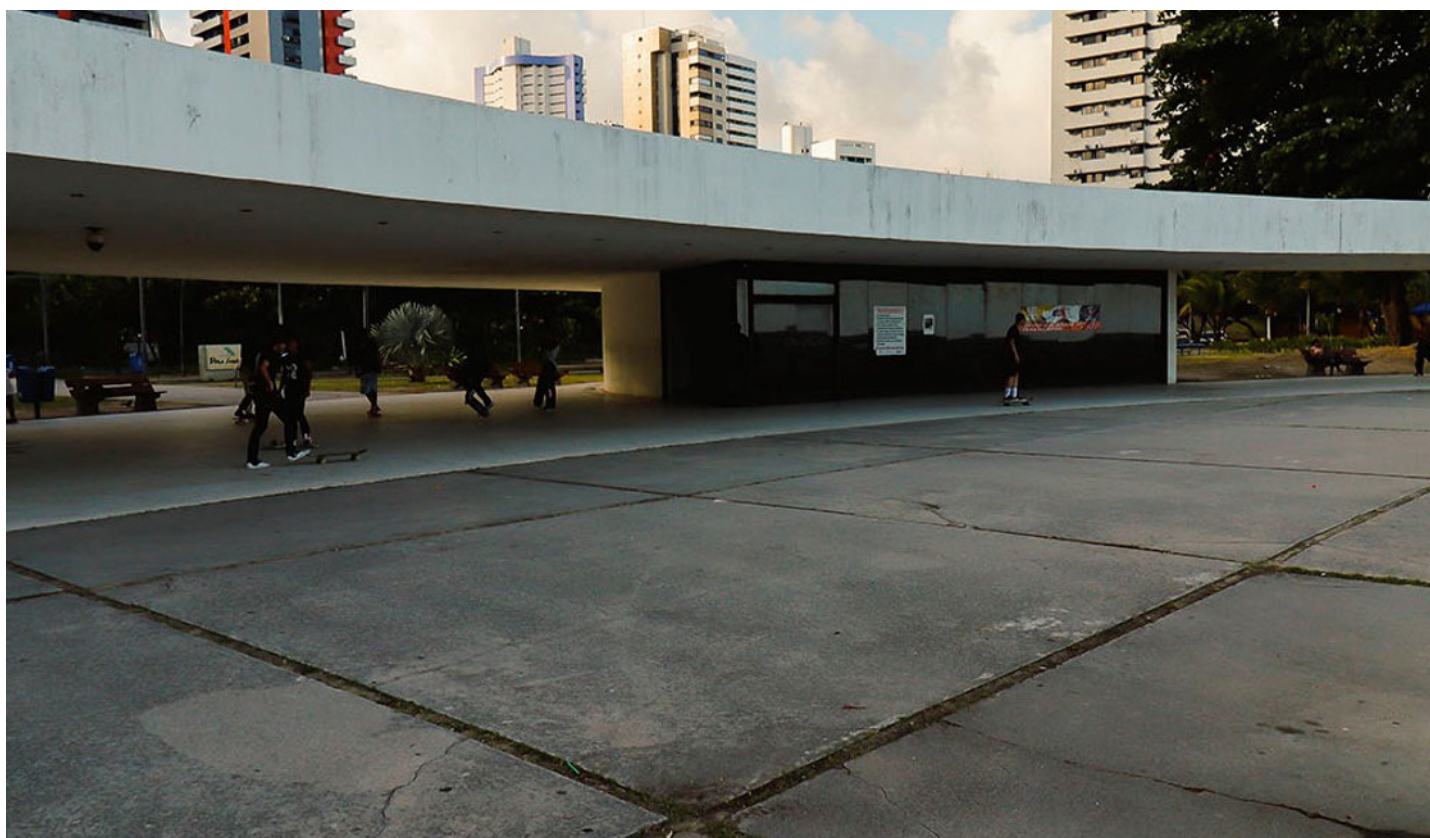
Figura 28 — Foto externa da edificação. Fonte: BNDES.
