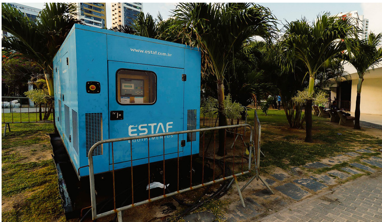
Figura 41 — Foto da estrutura. Fonte: BNDES.
